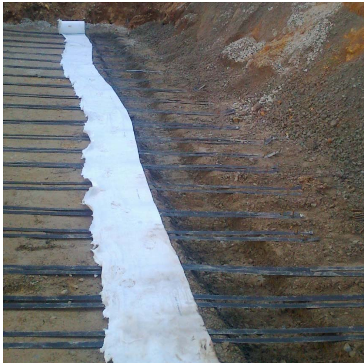
Fotografia 2.29 – Vala com geotêxtil
