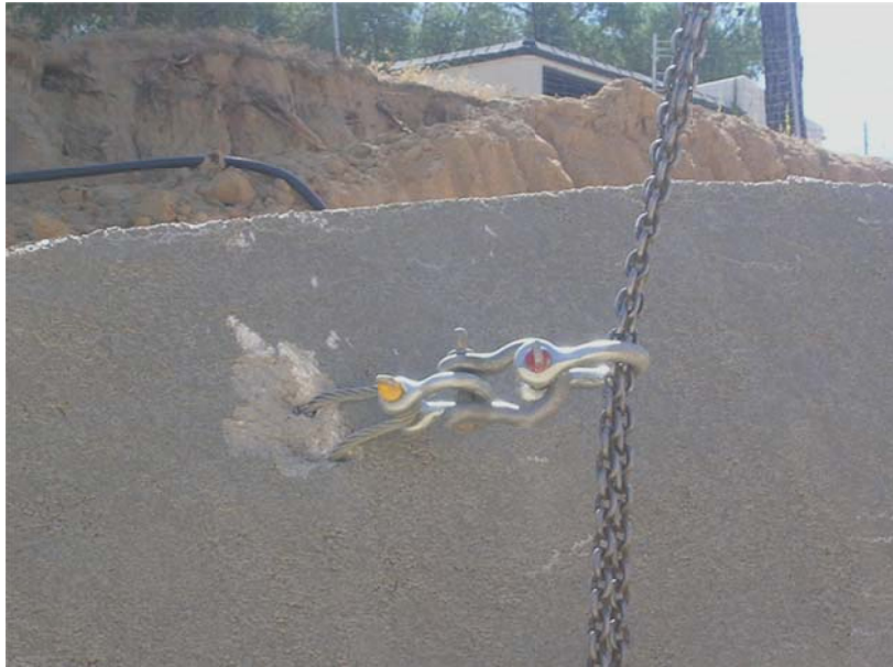
Fotografia 2.10 – Pormenor de apoio da peça no chão
