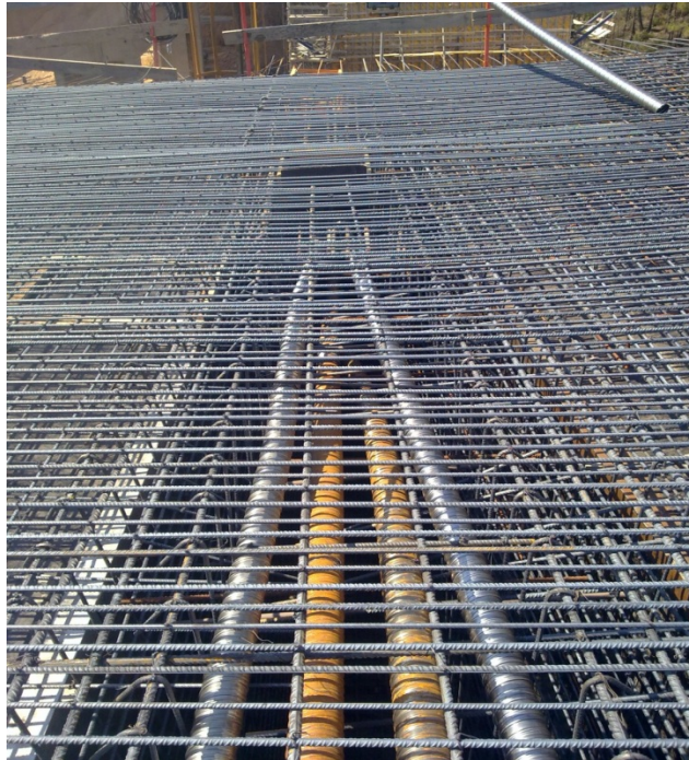
Fotografia 3.5 –Pormenor de bainhas evidenciando o traçado dos cabos
