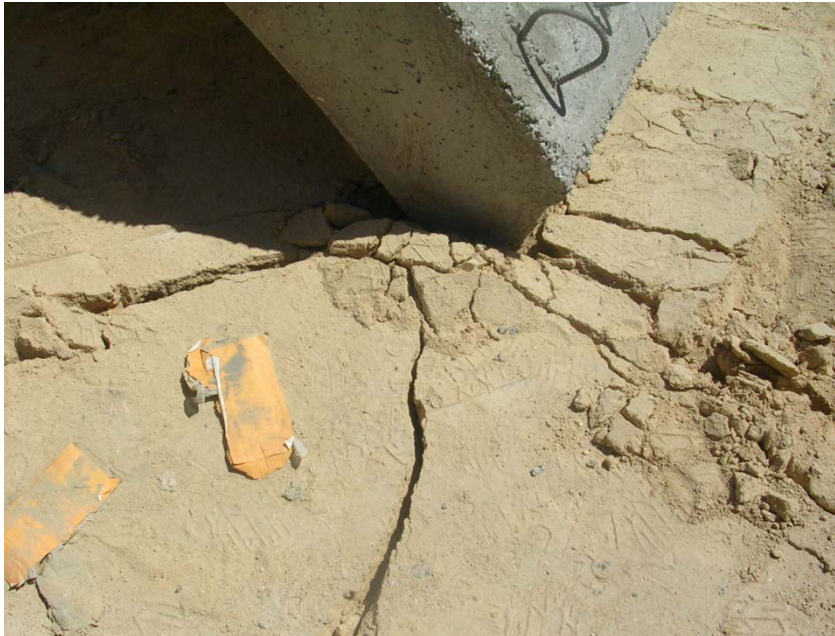
Fotografia 2.9 – Pormenor de apoio da peça no chão
