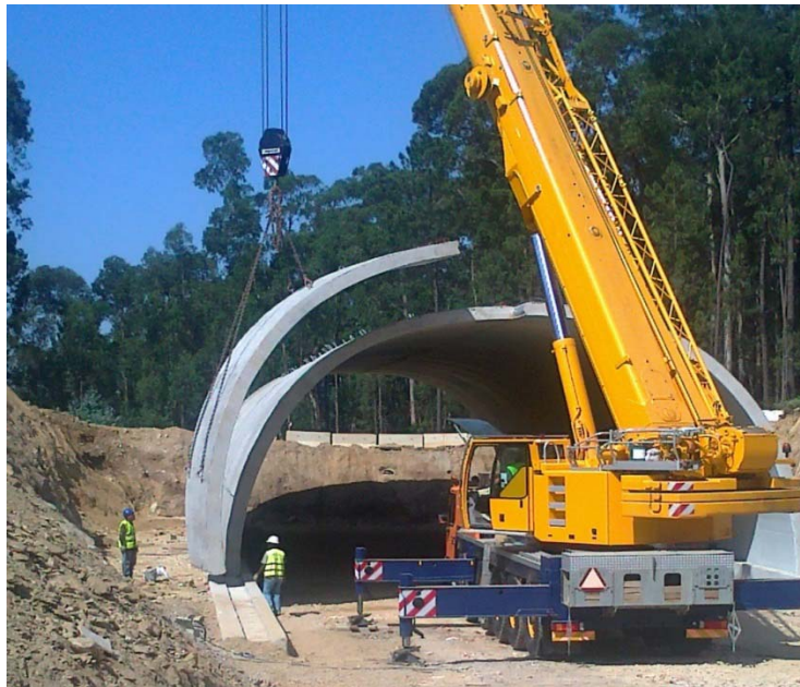
Fotografia 2.14 – Colocação da peça
