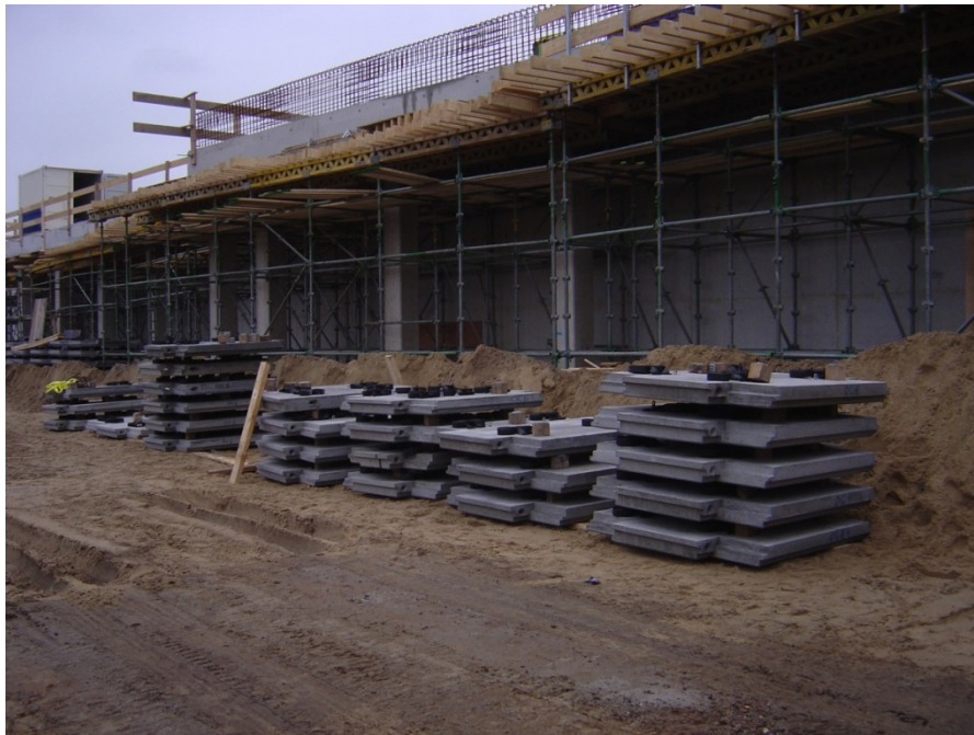
Fotografia 2.28– Escamas em stock munidas de armaduras
