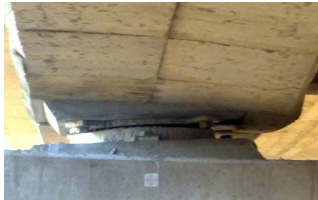
Fotografia 3.2 – Pormenor aparelho de apoio
