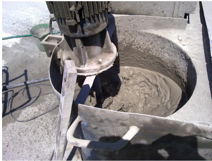
Fotografia 3.16 – Fabrico da calda de injeção
