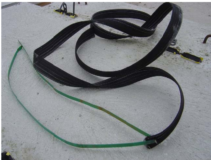
Fotografia 2.25 – Guia utilizada para a inserção de armaduras
