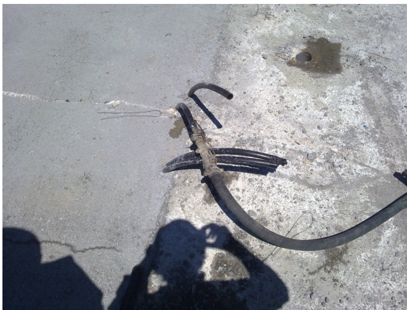
Fotografia 3.18 – Injeção da calda
