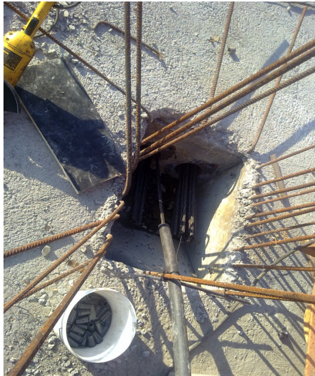
Fotografia 3.14 – Enfiamento do aço e cunhas
