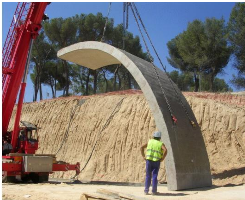
Fotografia 2.13 – Colocação da peça em suspensão
