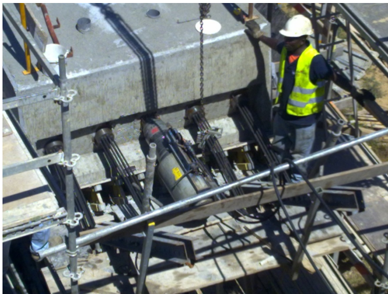
Fotografia 3.10 – Tensionamento dos cabos (Pilar)
