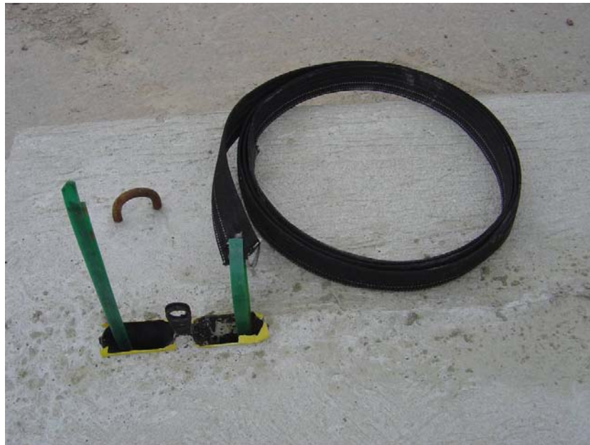
Fotografia 2.26 – Inserção de armaduras
