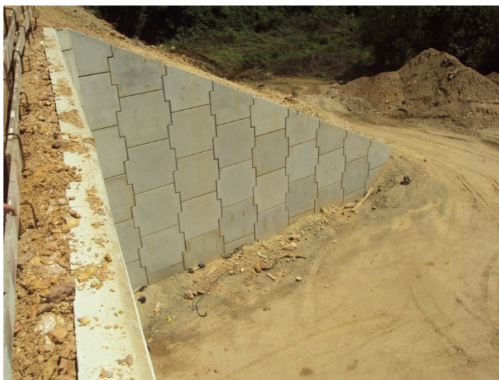
Fotografia 2.21 – Muro de ala PI5
