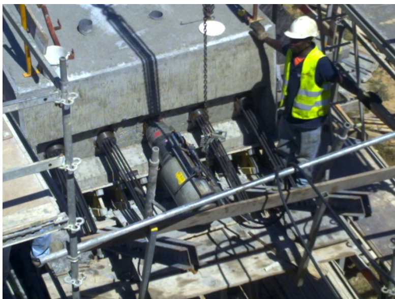
Fotografia 3.15 – Tensionamento dos cabos (Pilar)
