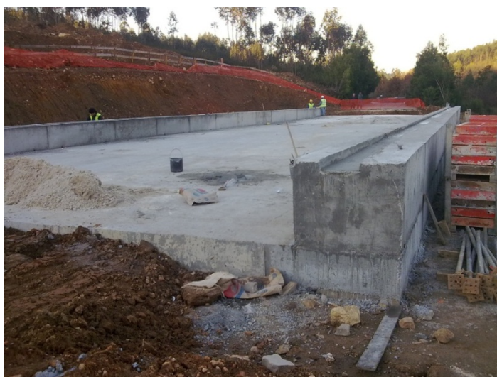
Fotografia 2.4– Laje de fundação PI5.
