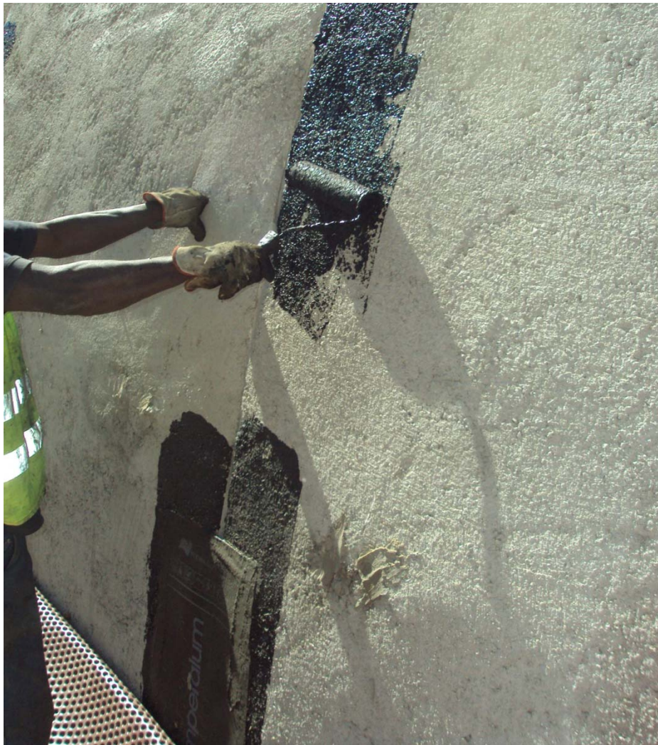
Fotografia 2.20 – Colocação da tela impermeabilizante
