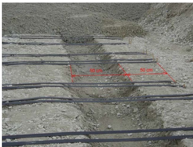
Fotografia 2.32 – Pormenor da vala – opção 2
