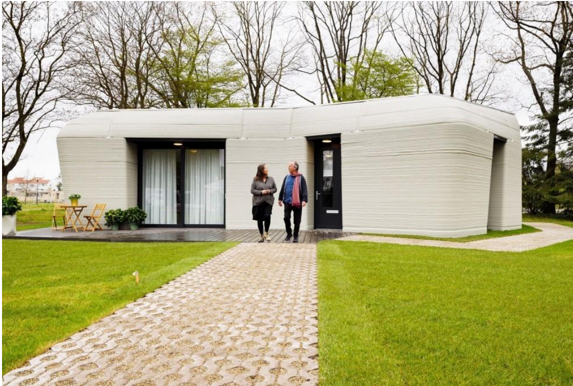
Figura 1.2 - Casa impressa em betão 3D em Eindhoven (Project Milestone)(3dprintedhouse, n.d.)
