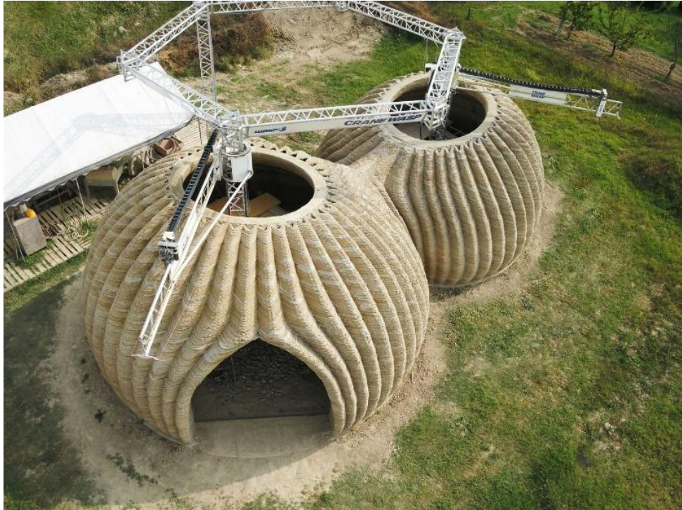
Figura 1.5 - Tecla 3D Edifício impresso WASP (Crane, 2018)
