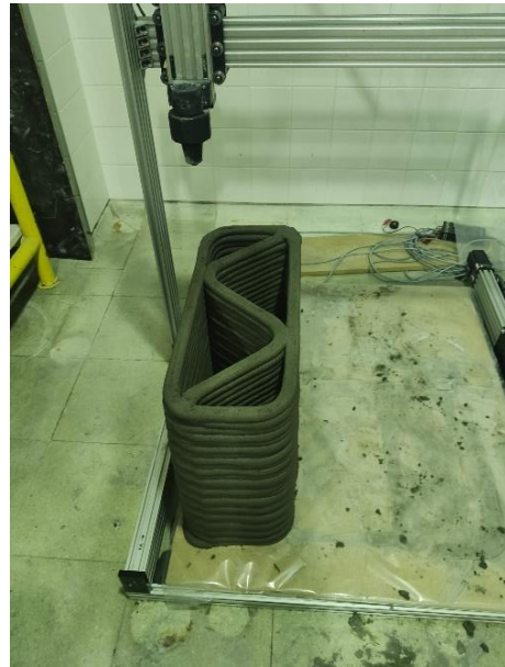
Figura 4.10 - Vista superior da parede Modelo 1
