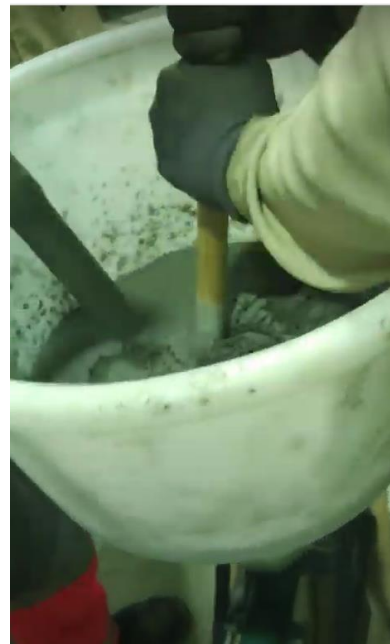
Figura 4.4 - Argamassa colocada no funil
