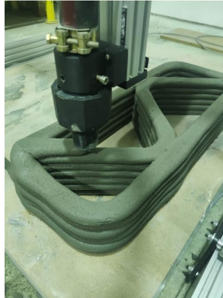
Figura 4.6 - Impressão de Parede Modelo 0
