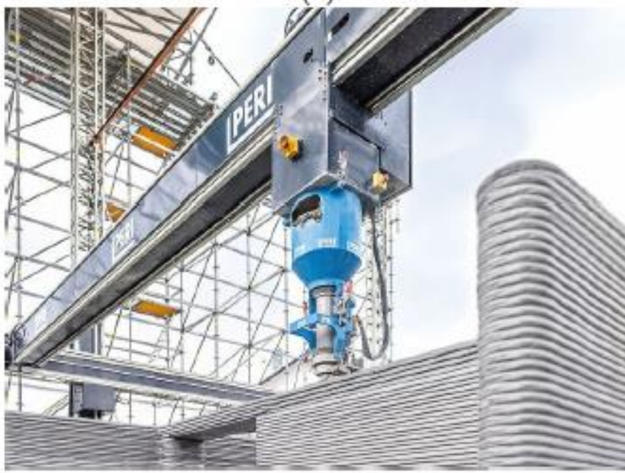
Figura 1.3 - Peri 3D Gantry Impressora 3D (Puzatova et al., 2022)
