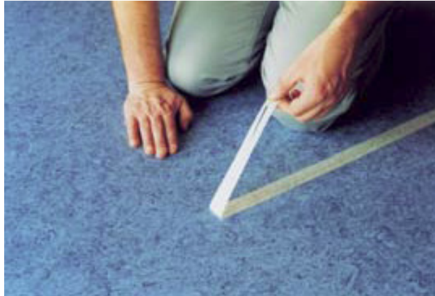
Figura 33 – Remoção da fita com a inclinação necessária [16]
