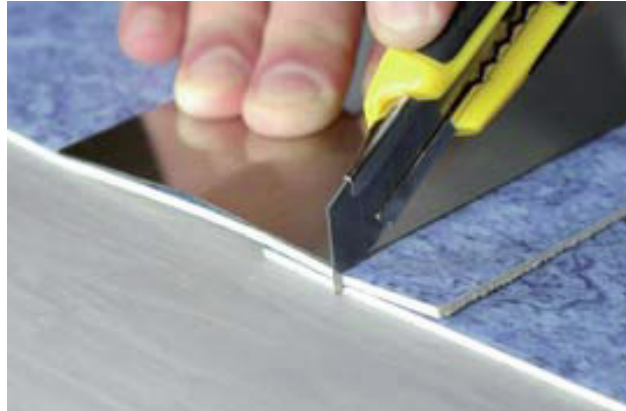
Figura 23 – Execução do corte duplo [16]
