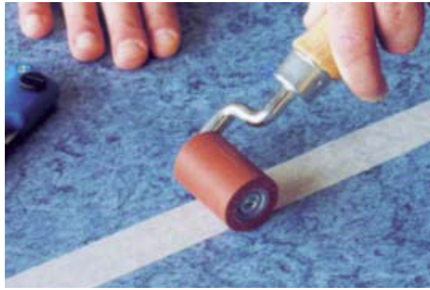
Figura 28 – Passagem do rolo compressor [16]
