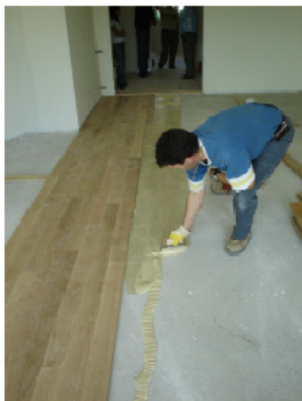
Figura 69 – Exemplo de aplicação de Thomsit P685
