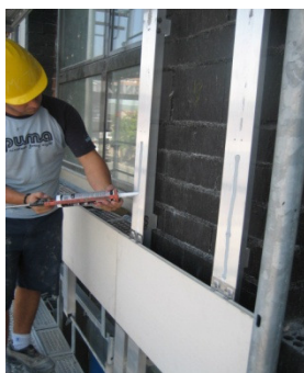
Figura 43 – Exemplo de aplicação em painéis de fachadas (20)
