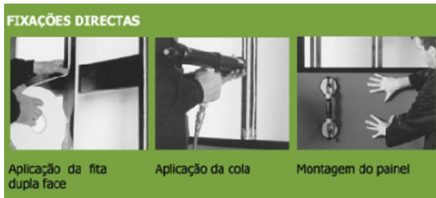
Figura 66 – Procedimentos para fixações directas (25)
