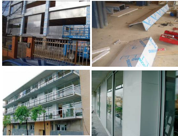
Figura 54 – Aplicação de SP-101 em painéis exteriores (12)
