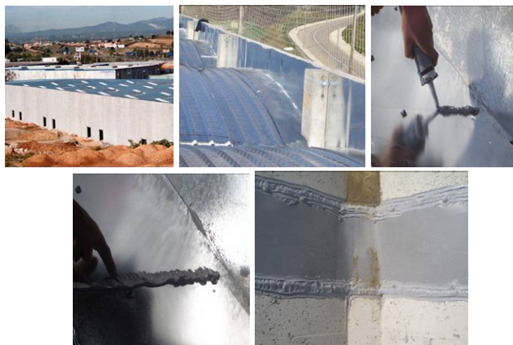
Figura 53 – Aplicação de SP-101 em coberturas metálicas (12)
