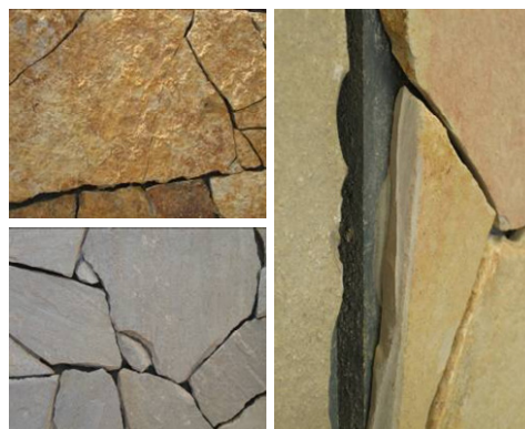
Figura 57 – Aplicação de SP-101 em pedra natural (12)
