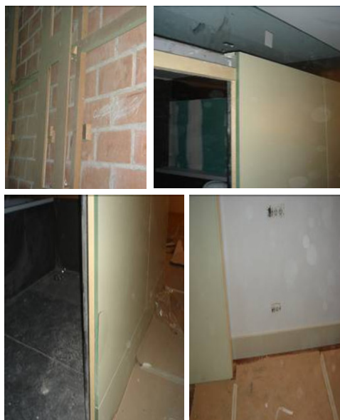
Figura 55 – Aplicação de SP-101 em painéis interiores (12)
