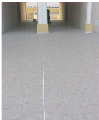
Figura 16 – Exemplo de junta bem dimensionada (12)
