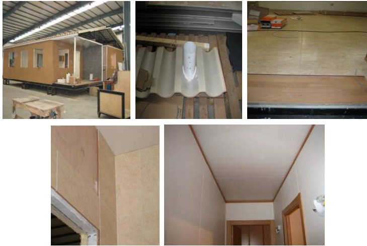
Figura 51 – Aplicação de SP-101 em casas pré-fabricadas (12)
