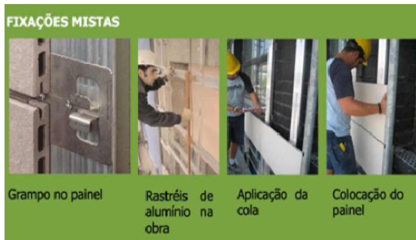
Figura 67 – Procedimentos para fixações mistas (25)
