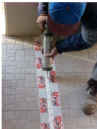
Figura 47 – Exemplo de aplicação do produto Sista SP-201 Juntas (21)
