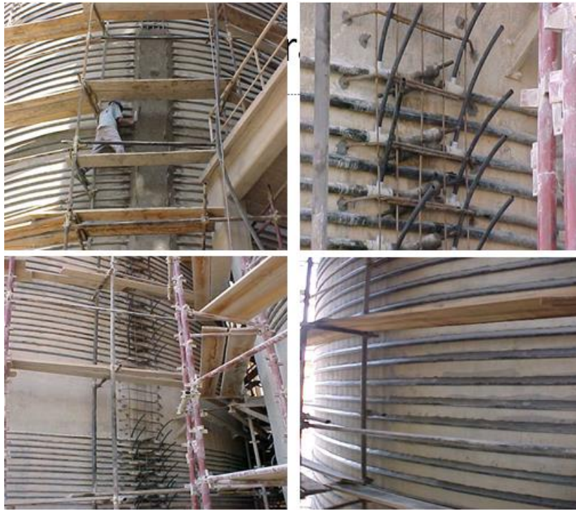
Figura 6.41 – Silo do caso prático-sistema Freyssinet
