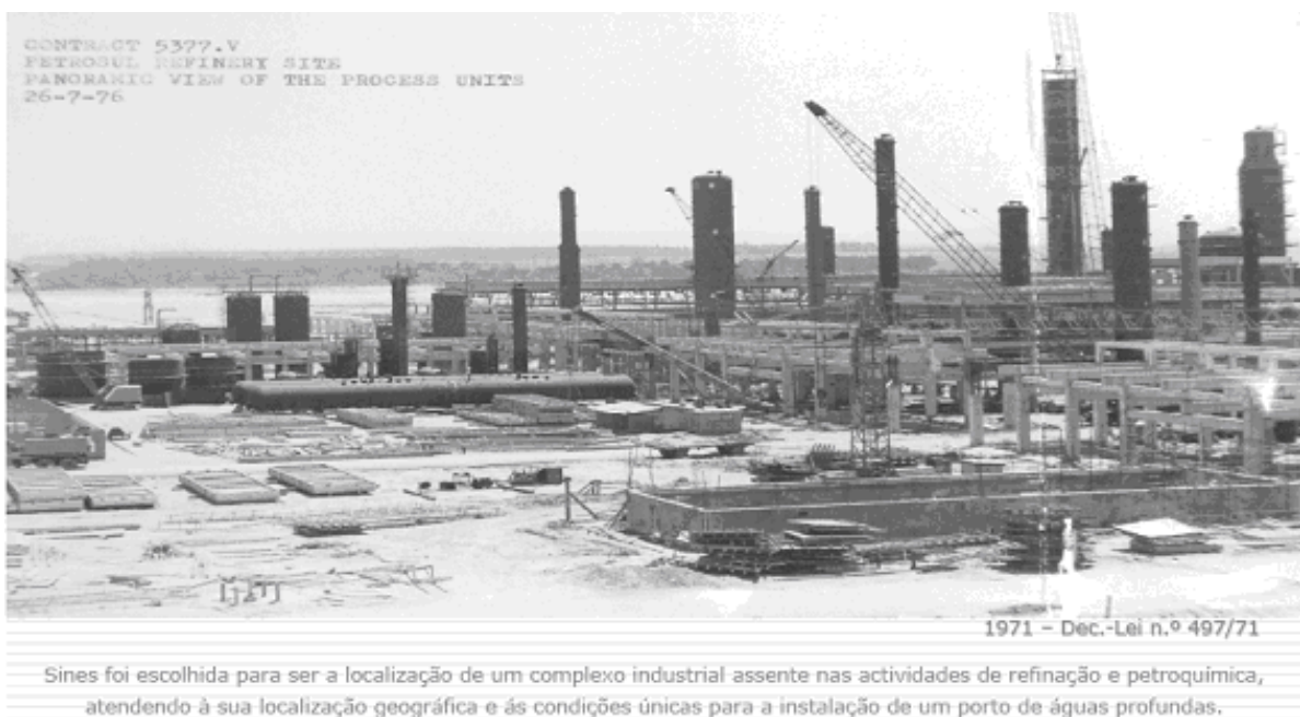
Figura 1 – Fase inicial da construção da Refinaria de Sines
