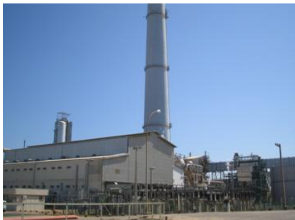
Figura 5 – Edifício central das Utilidades
