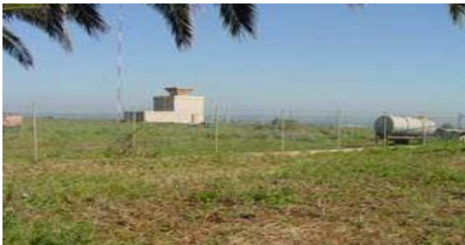
Figura 10 – Estação do Monte Chãos
