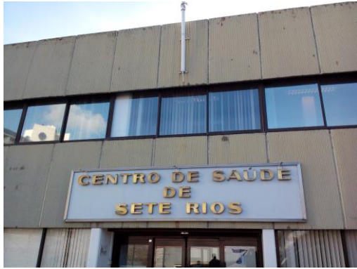
Figura 47 – Fachada da entrada principal
