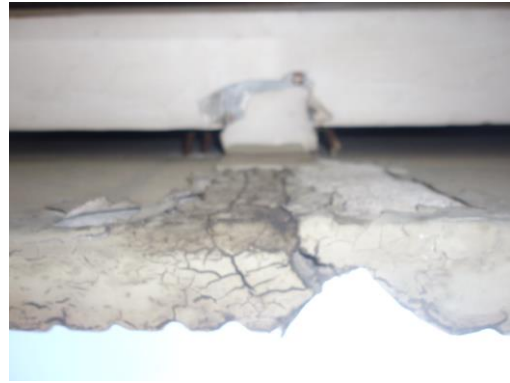
Figura 30 – fixação dos painéis pré-fabricados
