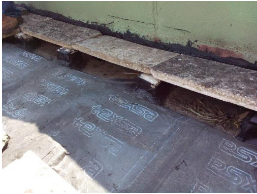
Figura 13 – Solução provisória de impermeabilização
