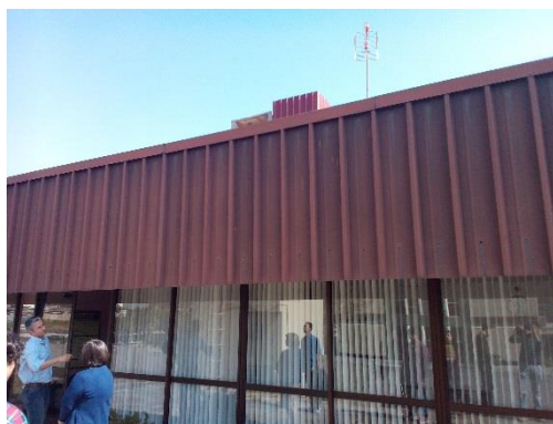
Figura 10 – Cobertura último piso do edifício
