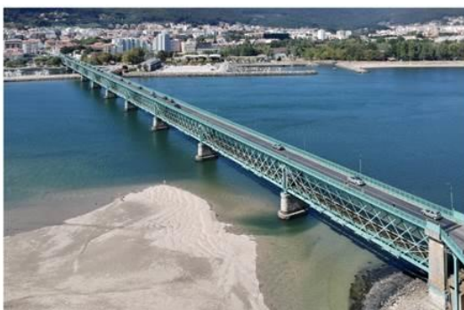
Fig.3 Ponte de Viana do Castelo, projeção de Gustave Eiffel. Inaugurada em 1878
