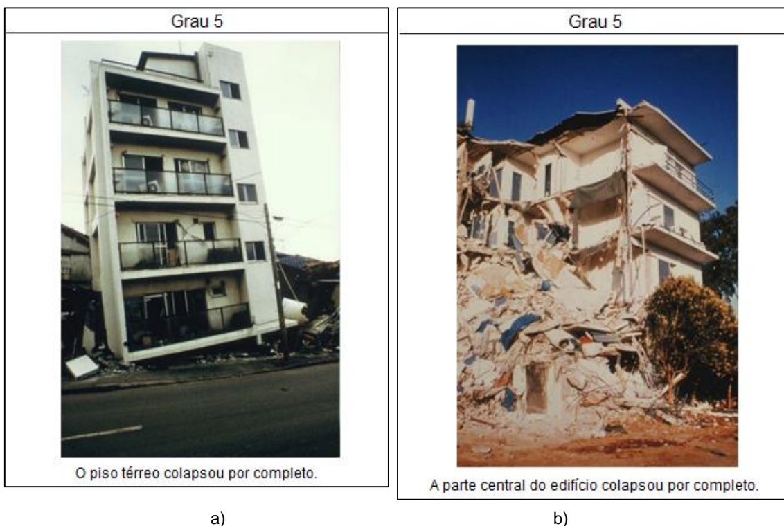
Figura 4.11 – a) Estrutura com paredes de betão armado com danos de grau 5. Sismo de Great Hanshin, Japão (1995). Local: Kobe (Grünthal, 1998); b) Estrutura em pórtico de betão armado com danos de grau 5. Sismo de North Peloponissos, Grécia (1995). Local: Aegion (Grünthal, 1998).
