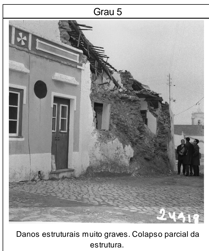
Figura 4.28 – Estrutura com paredes de adobe com danos de grau 5. Sismo de 1969, Algarve (Marecos & Castanheta, 1970; Sousa, 2006).
