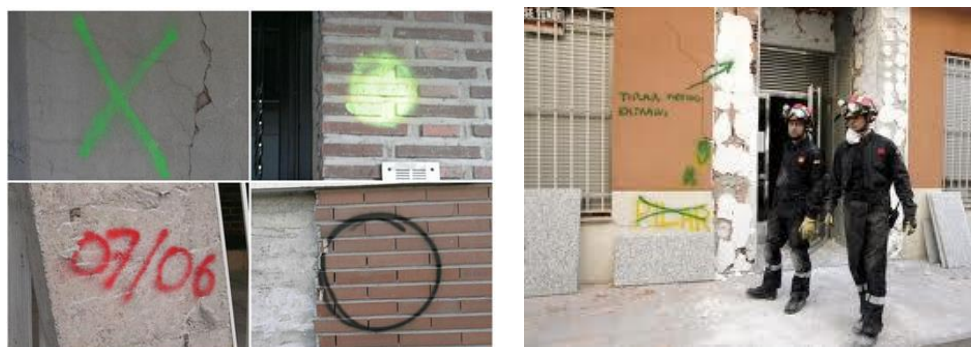
Figura 1.3 – Exemplos da sinalética utilizada nos edifícios em Lorca (Missão do LNEC a Lorca, 2011).
