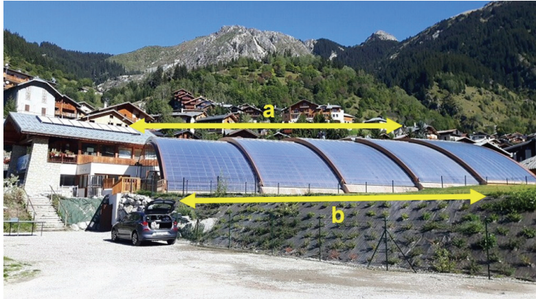
Figura 3.21 - Cobertura de piscina municipal (Champagny, França)
