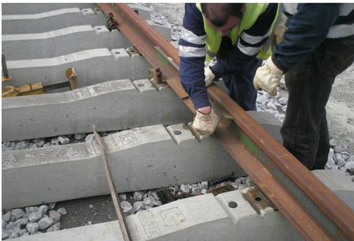
Figura 5.8 - Verificação da folga nos topos dos carris - [Modernização do Troço Bombel e Vidigal a Évora]
