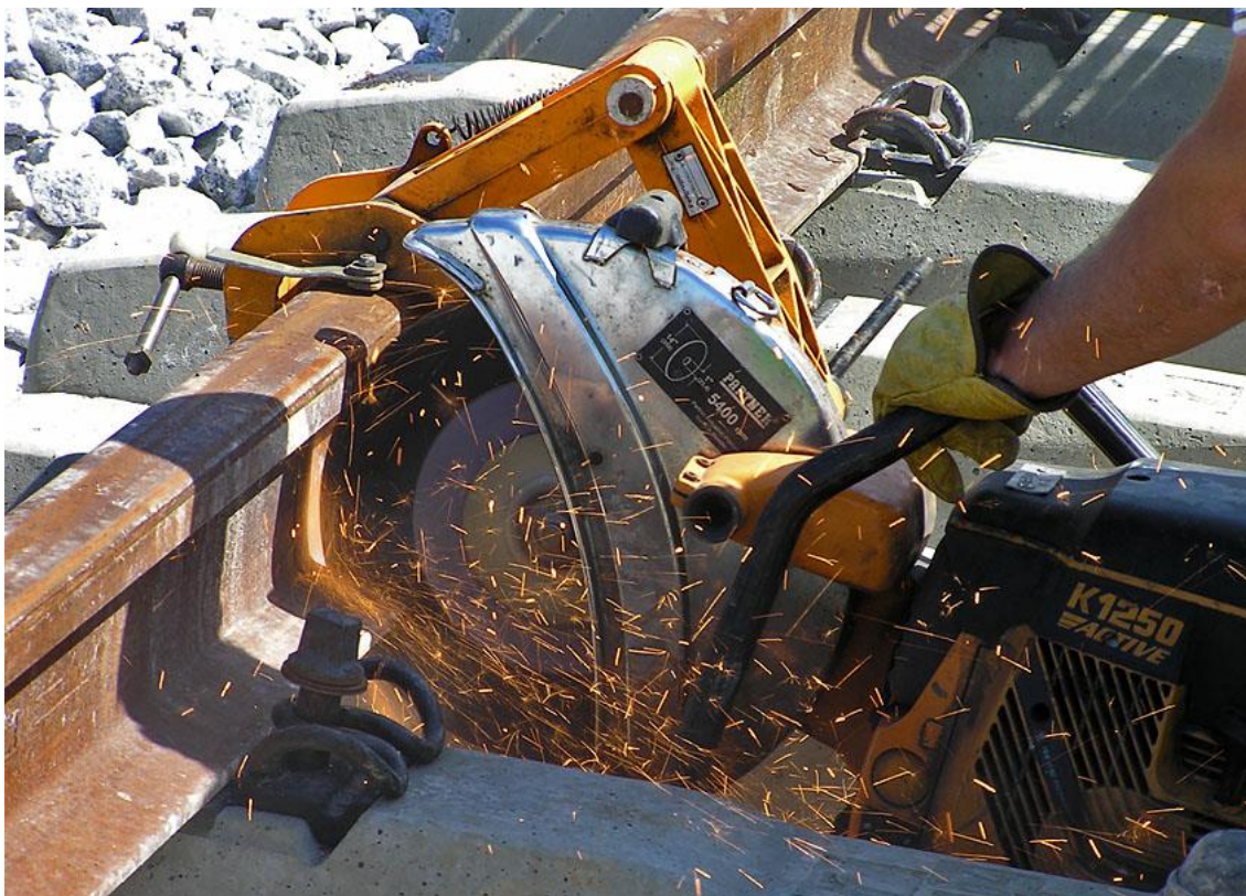
Figura 5.7 - Corte de carril - [Linha do Norte - Sub-Troço 2.1 Entroncamento – Albergaria dos Doze]
