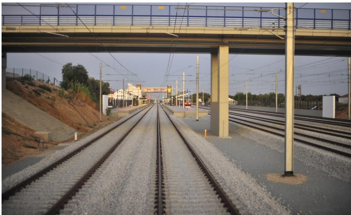
Figura 3.1 - Via Moderna [Modernização do Troço Bombel e Vidigal a Évora]
