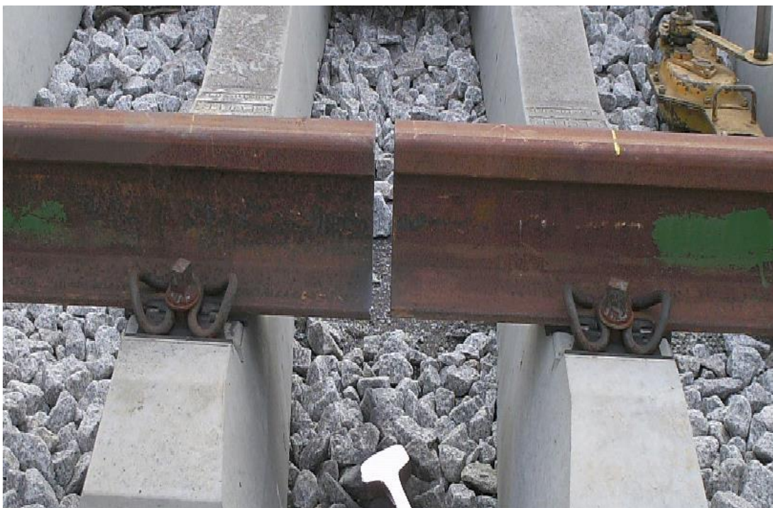
Figura 5.4 - Topos dos carris a soldar - [Modernização do Troço Bombel e Vidigal a Évora]
