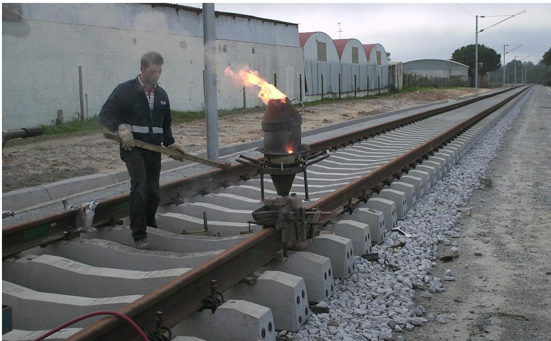
Figura 5.12 - Execução da soldadura - [Modernização do Troço Bombel e Vidigal a Évora]
