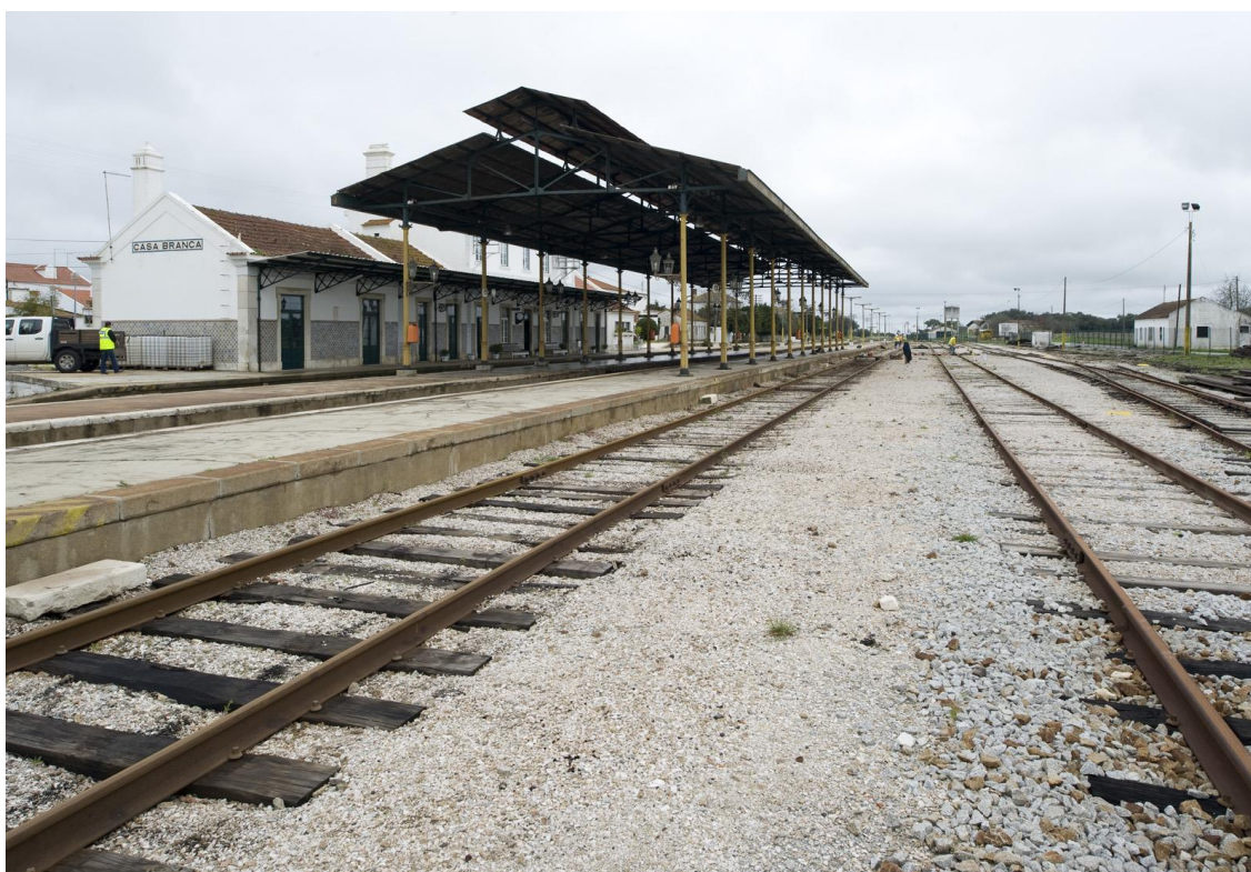
Figura 2.1- Via Clássica - [Modernização do Troço Bombel e Vidigal a Évora]
