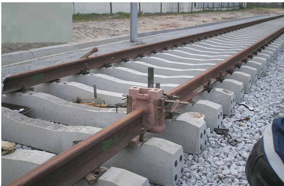
Figura 5.9 - Moldes usados nas soldaduras - [Modernização do Troço Bombel e Vidigal a Évora]
