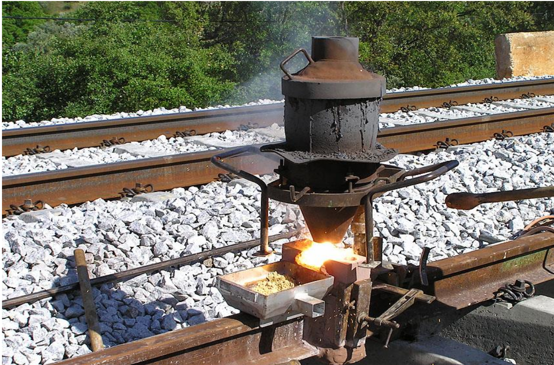
Figura 5.13 - Descarga do material fundido - [Linha do Norte - Sub-Troço 2.1 Entroncamento – Albergaria dos Doze]
