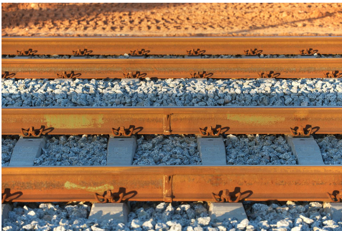
Figura 5.1 - Soldaduras - [Estação da Raquete - Sines]
