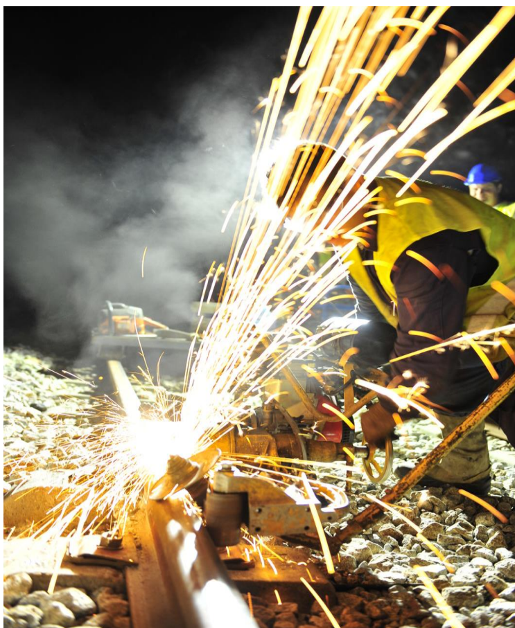
Figura 5.16 - Acabamento da Soldadura - [Unidade Operacional Sul]
