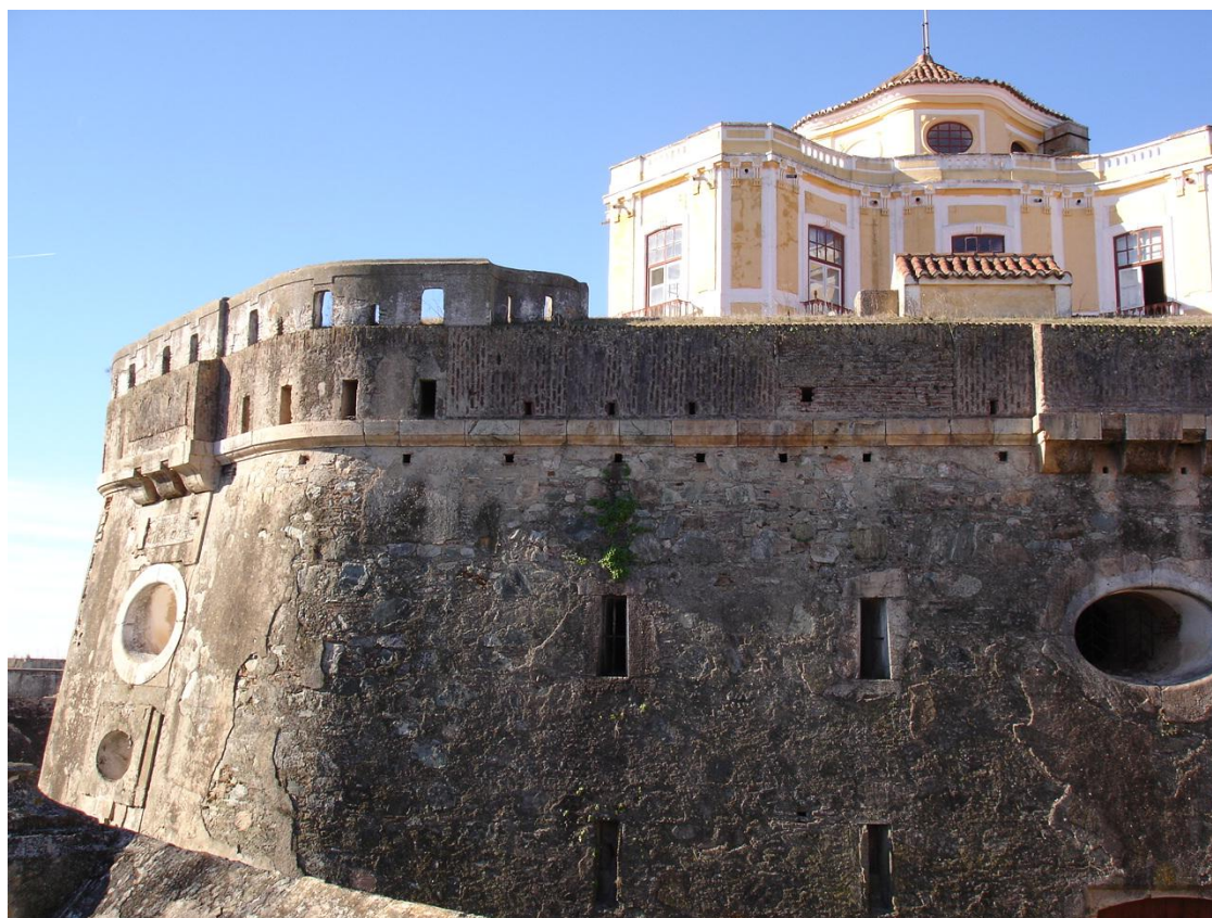
Figura 9 – Foto da fachada exterior do piso 2 do Reduto Central e da Casa do Governador
