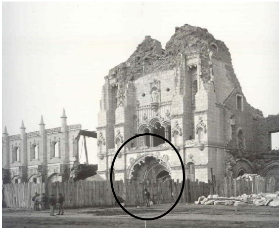
a) Queda da torre (1878) 39
