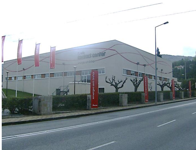
Figura 30 - Centro de Atendimento Permanente em Seia (antes da intervenção) - Exterior
