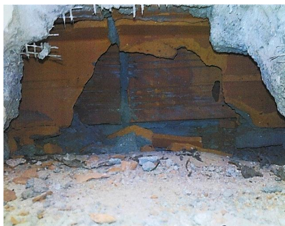
Figura 5 - Edifício Sede de Escritórios em Coimbra - Sondagem de prospecção realizada
