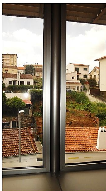
Figura 17 - Edifício Sede de Escritórios em Coimbra - Zona onde foi aplicada uma das juntas de dilatação no interior da caixilharia metálica
