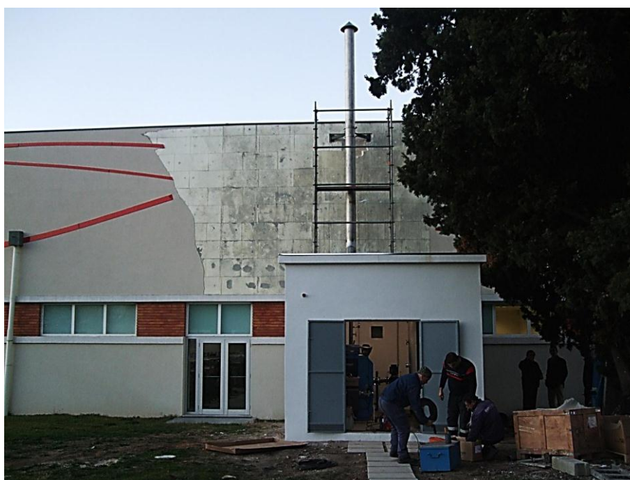
Figura 33 - Centro de Atendimento Permanente em Seia - Construção de zona onde se situa a caldeira de gás natural
