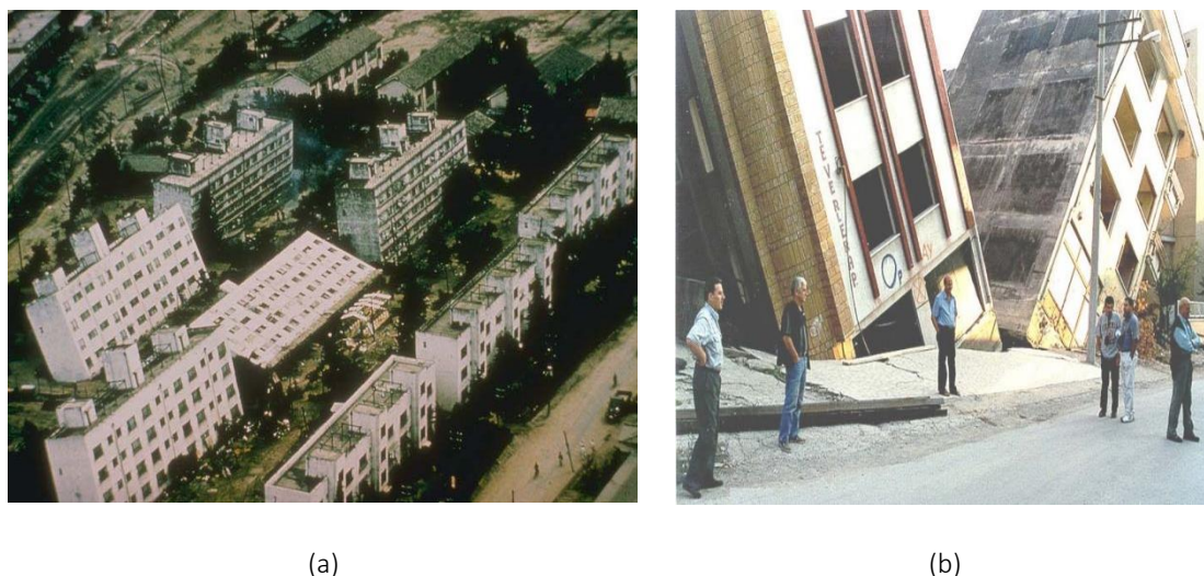
FIGURA 2.3 – Colapso de vários edifícios por liquefação – (a) sismo de Niigata, 1964 [4]; (b) sismo de Izmit, 1999 [5]
