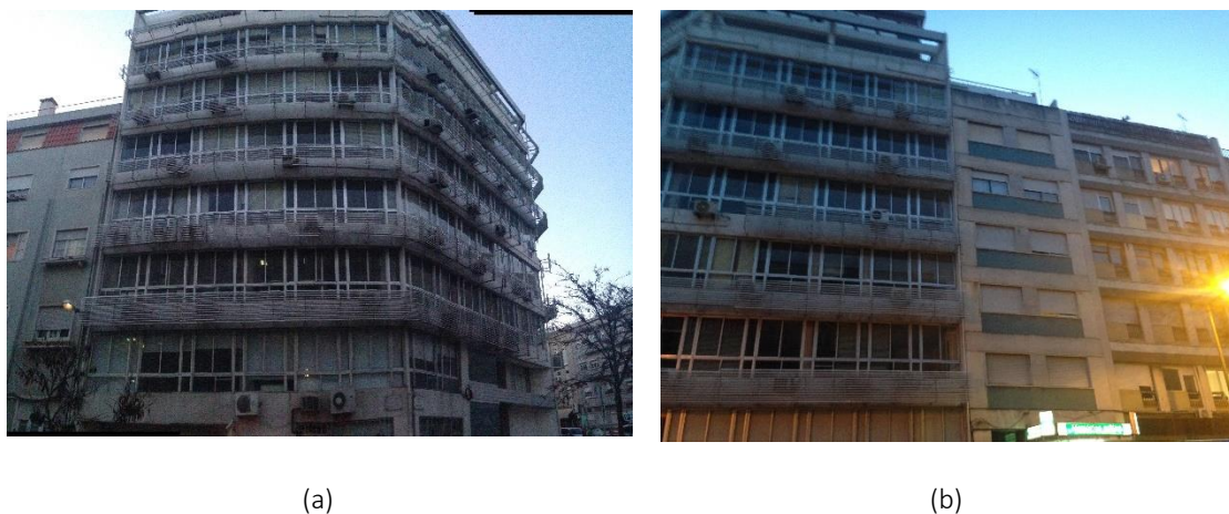
FIGURA 4.11 – Desnivelamento dos edifícios adjacentes: (a) Lado esquerdo; (b) Lado direito
