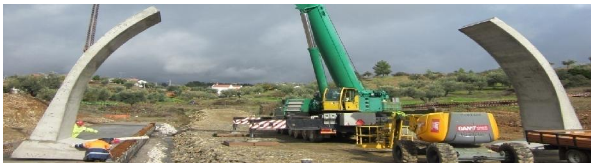
Colocação dos elementos pré-fabricados das matériês com lintel e sapatas exteriores.
