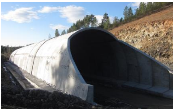
Matiére com lintel e sapata exterior.
