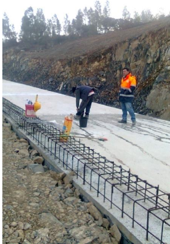
Fundações e armadura para lintel interior.
