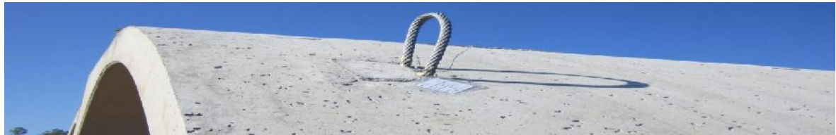
Transporte dos elementos pré-fabricados e pormenor do ponto de suspensão provisório.
