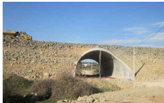
Matiére com lintel e sapata exterior.
