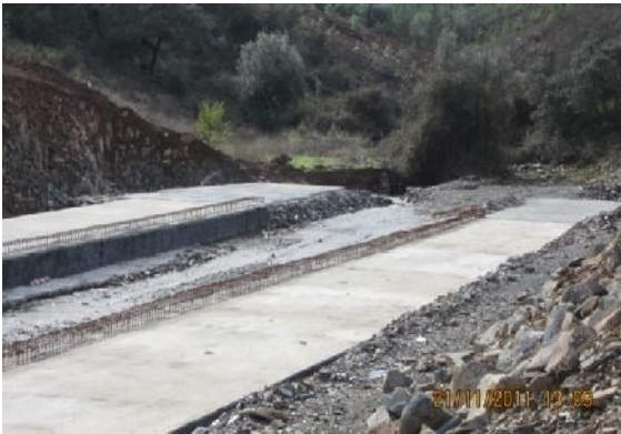
Fundações e armadura para lintel interior.
