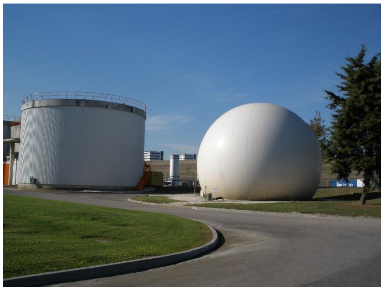
Figura 5 – Digestor anaeróbio e gasómetro da ETAR de Beirolas
