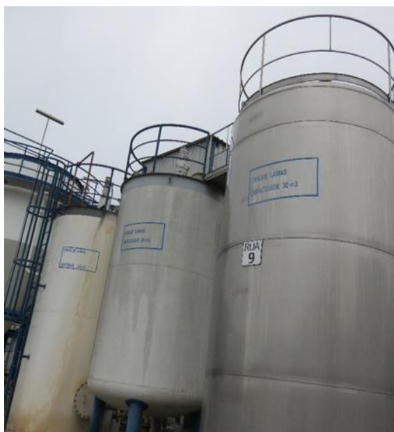
Figura 15 - Espessador de lamas secundárias e Tanque de lamas mistas (primárias e secundárias)
