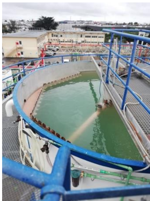
Figura 13 – Descarregador do decantador secundário
