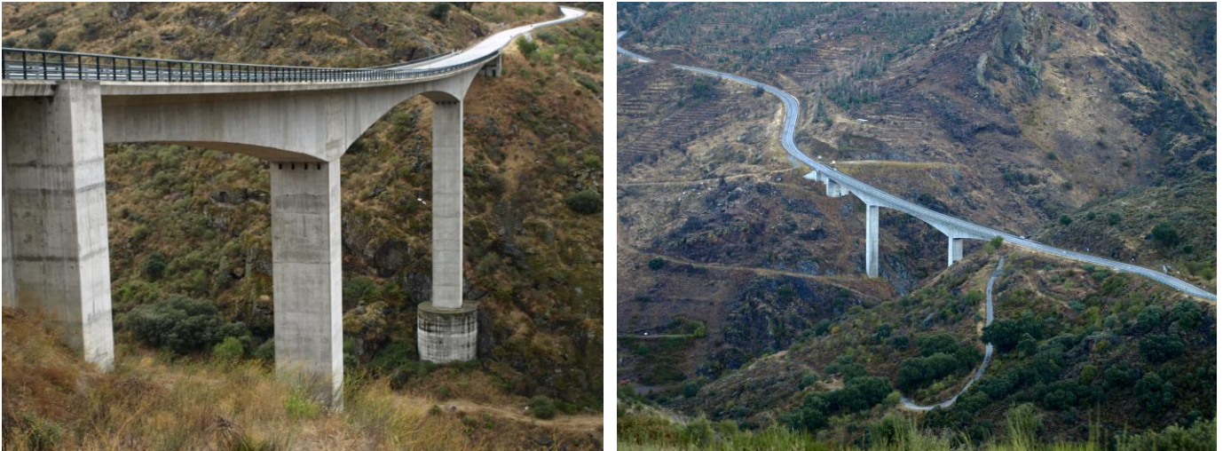
Figura 5.21 – Vista geral da ponte sobre o rio Angueira.
