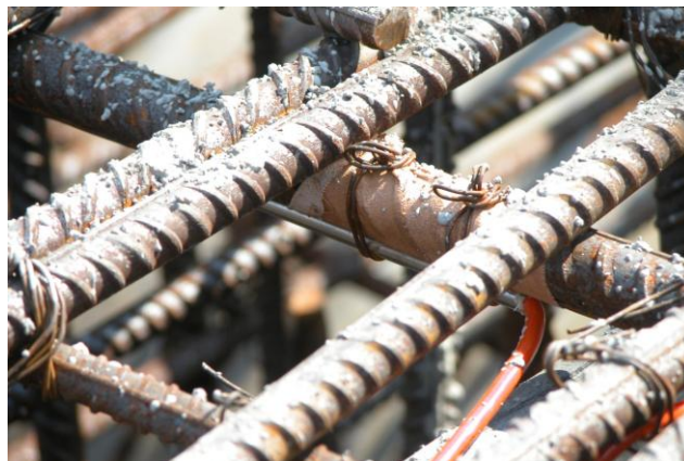
Figura 5.2 – Termómetro Obra monitorizada pelo NOE - Ponte da Catumbela – Angola
