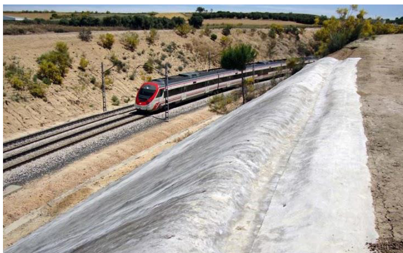
Figura 2.8 – Valeta de crista de talude [12]
