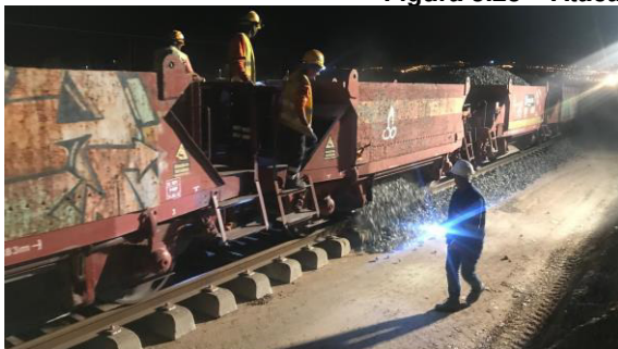
Figura 5.26 – Balastragem (descarga)
