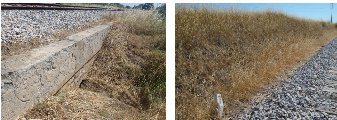
Figura 3.7 – Exemplo de órgãos de drenagem existentes a intervir
