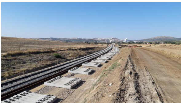
Figura 4.6 – Distribuição de TBMP
