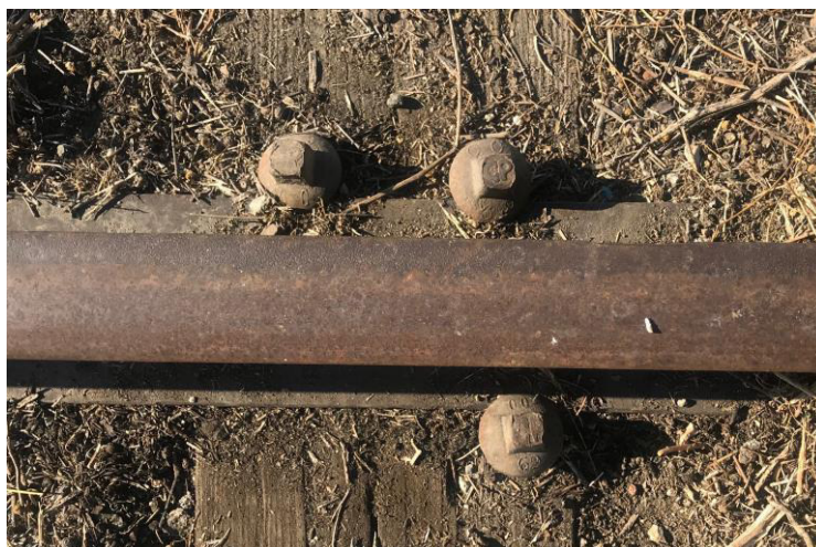
Figura 2.19 – Fixação rígida
