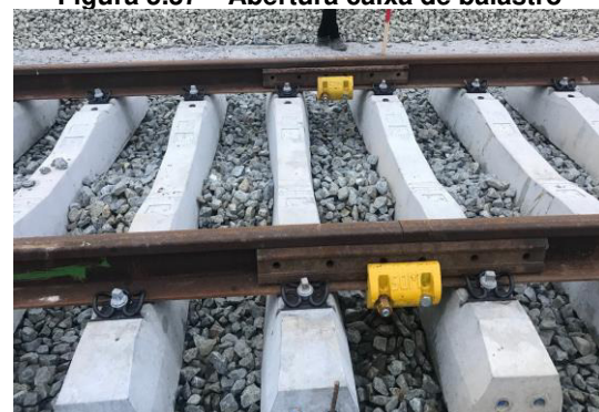
Figura 5.39 – Aplicação de C de ligação
