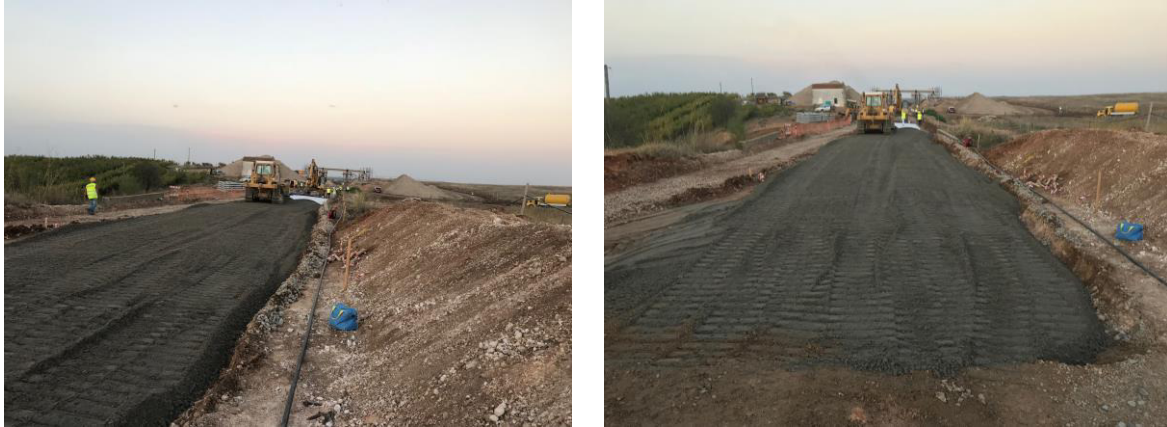
Figura 5.24 – Execução de camada de sub-balastro
