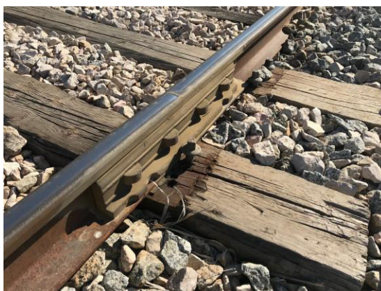
Figura 2.23 – Barreta de 4 furos, lado passivo
