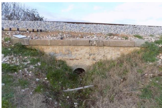
Figura 2.6 – Passagem Hidráulica de uma Via Férrea
