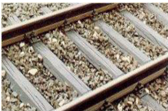
Figura 2.12 – Travessas de madeira [16]
