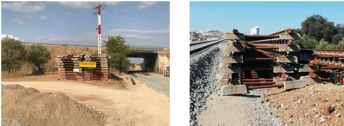
Figura 4.3 – Stock de TBB e tramos via provisória
