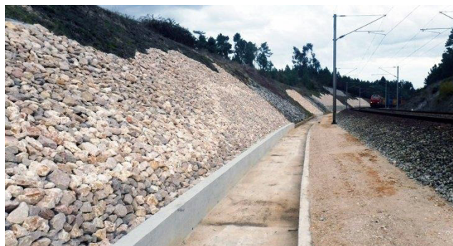
Figura 2.7 – Valeta de pé de talude e plataforma [11]
