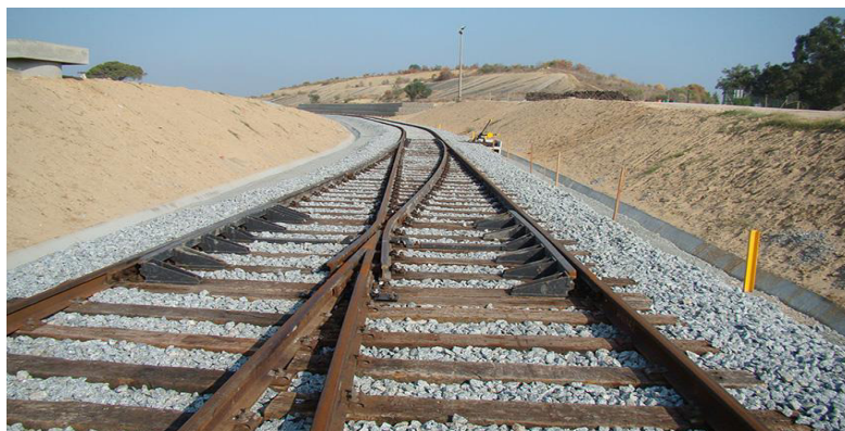
Figura 2.11 – Balastro na via férrea [15]
