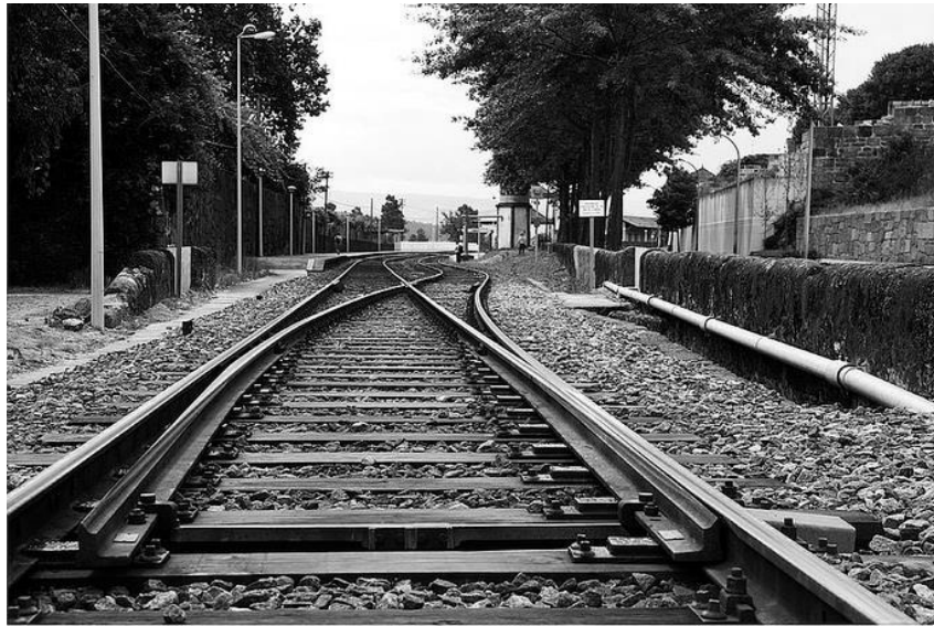
Figura 2.25 – Aparelho de mudança de via [27]
