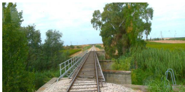
Figura 3.16 – Ponte sobre o Rio Caia (Vista Nascente / Poente)
