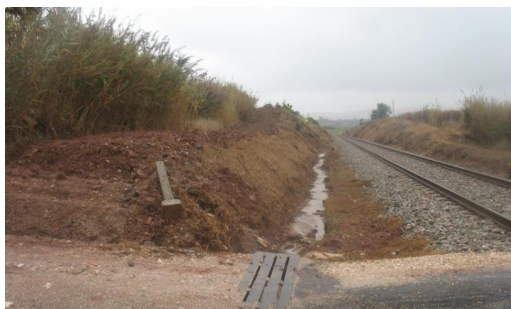
Figura 2.4 – Talude em Escavação [9]
