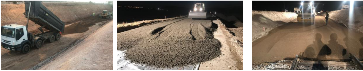
Figura 5.23 – Tratamento / Saneamento de Plataforma
