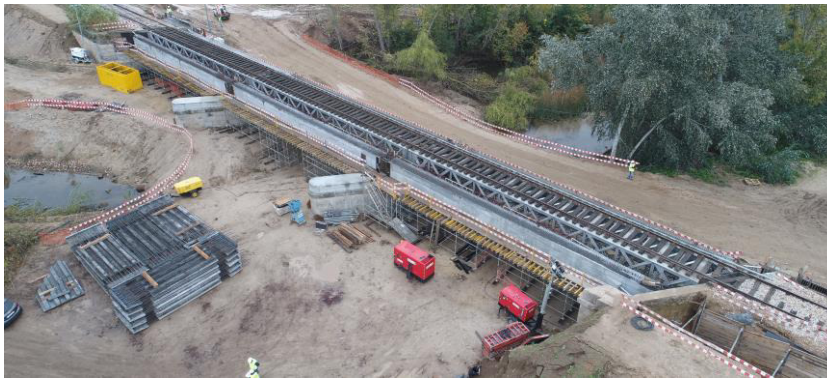
Figura 5.44 – Ponte do Caia – Trabalhos preparatórios [39]
