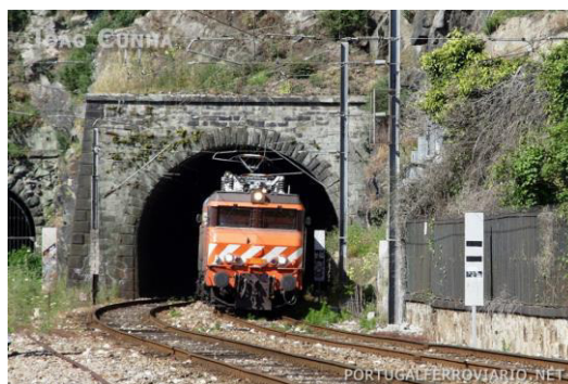
Figura 2.10 – Túnel da Campanhã [14]
