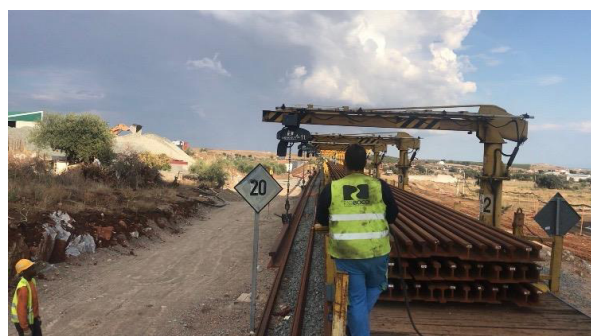
Figura 4.7 – Descarga de comboio de carril 60 E1
