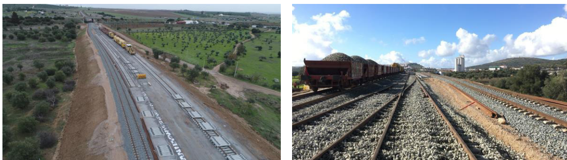
Figura 5.13 – Trabalhos de Via nas linhas I, II e III
