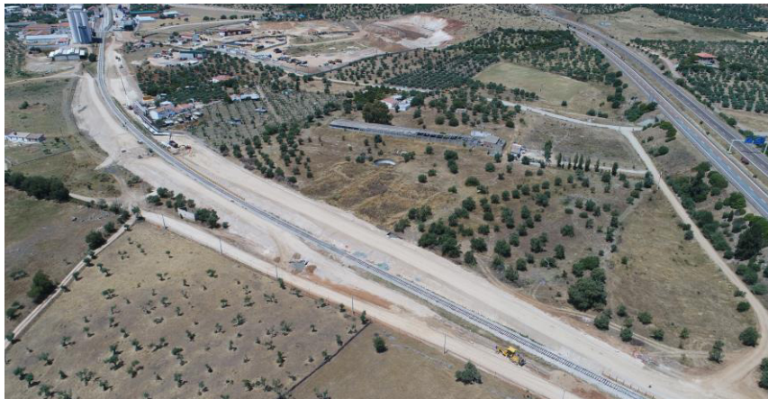
Figura 5.3 – Execução de nova Plataforma e Muro M2 [39]
