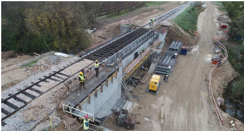
Figura 5.40 – Ponte do Caiola – Trabalhos preparatórios [39]
