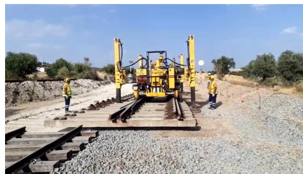
Figura 5.7 – Movimentação de AMV TMP3
