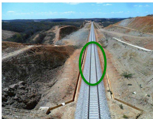
Figura 2.2 – Superestrutura de Via Férrea[7]
