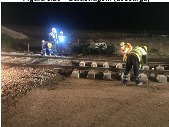
Figura 5.28 – Colocação de fecho misto
