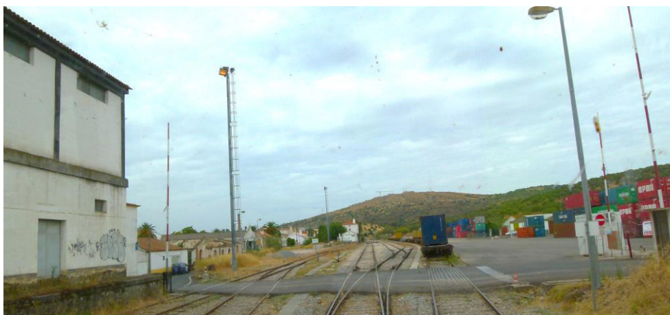
Figura 3.4 – Atravessamento de nível na Estação de Elvas
