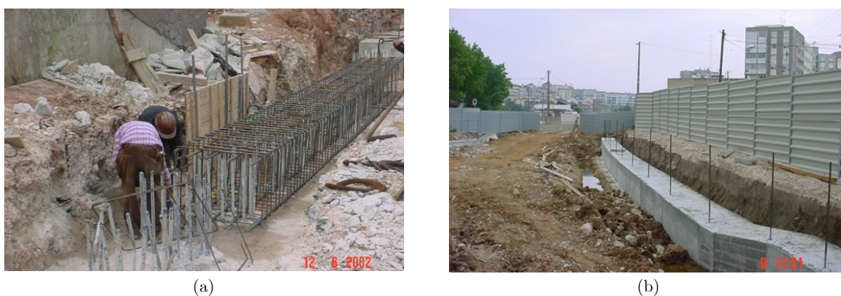
Figura 4.18 - (a) Armadura e cofragem da viga de encabeçamento; (b) Viga de encabeçamento após descofragem.
