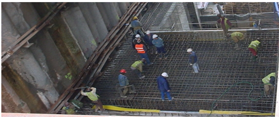
Figura 5.1 – Aspeto da armadura da laje de cobertura no Modelo 1.
