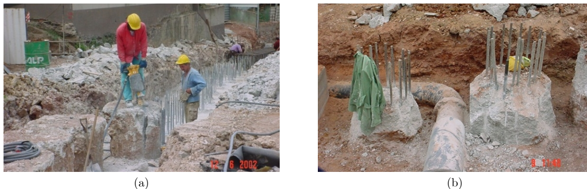
Figura 4.17 - (a) Saneamento do topo da estaca; (b) Intersecção da cortina de estacas com infra estruturas existentes.
