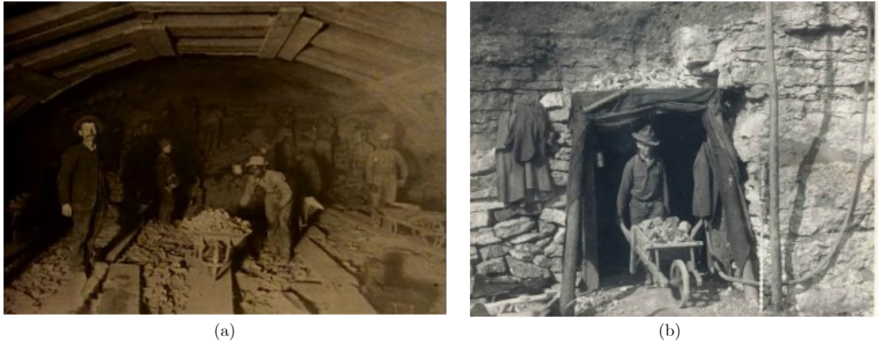
Figura 2.3 - (a) Aspeto da frente de obra; (b) Operário a remover os escombros do interior do abrigo.
