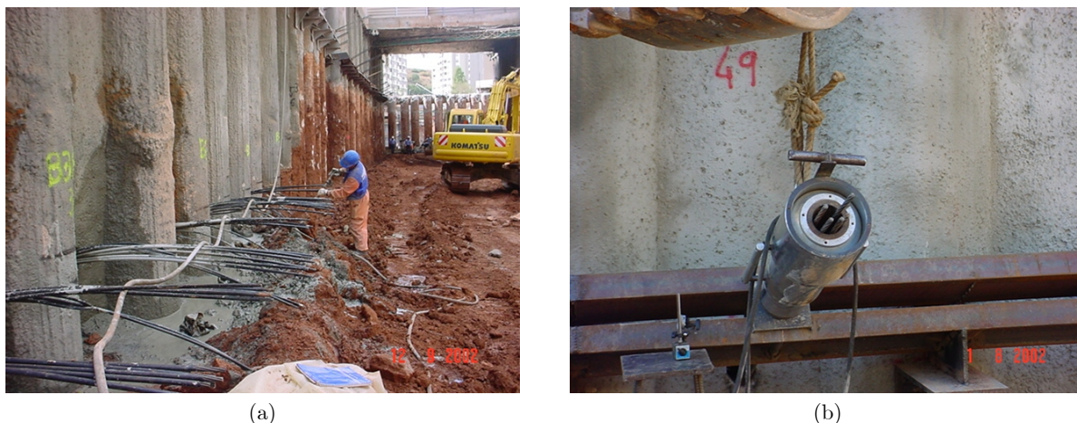
Figura 4.25 - (a) Injeção de calda nas ancoragens; (b) Tensionamento dos cabos da ancoragem.
