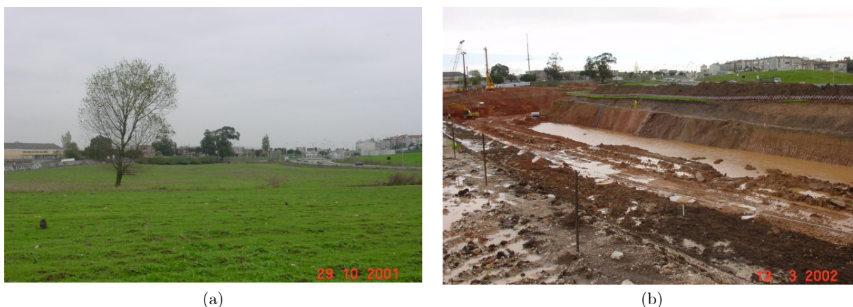
Figura 4.7 - Zona 1 – Quinta da Falagueira: (a) Antes da intervenção; (b) Durante a Intervenção.
