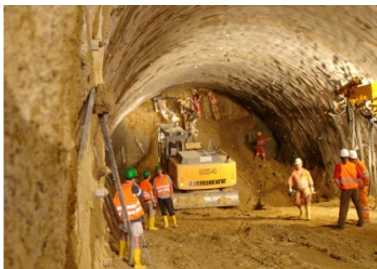
Figura 2.10 - Processo construtivo NATM (centralsubwaysf).
