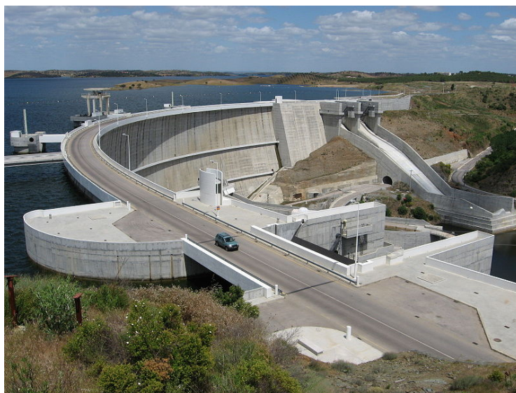
Figura 1.1 – Barragem de Alqueva [Site 1].
