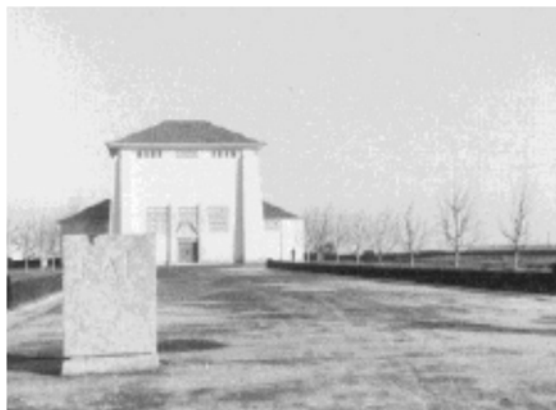
Fotografia 20 - Estação elevatória dos Olivais, 1962
