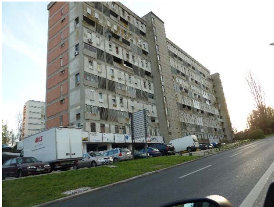
Fotografia 35 - Olivais Sul – Edifício em estudo Rua Cidade da Beira, 81
