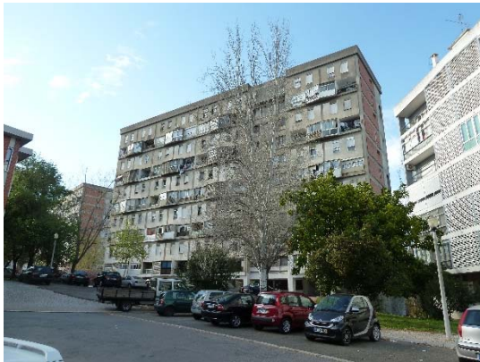
Fotografia 37 - Olivais Sul – Edifício em estudo Rua Cidade da Beira, 81 e 83
