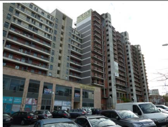
Fotografia 33 - Olivais Sul – Nova construção junto ao Spacio Shopping
