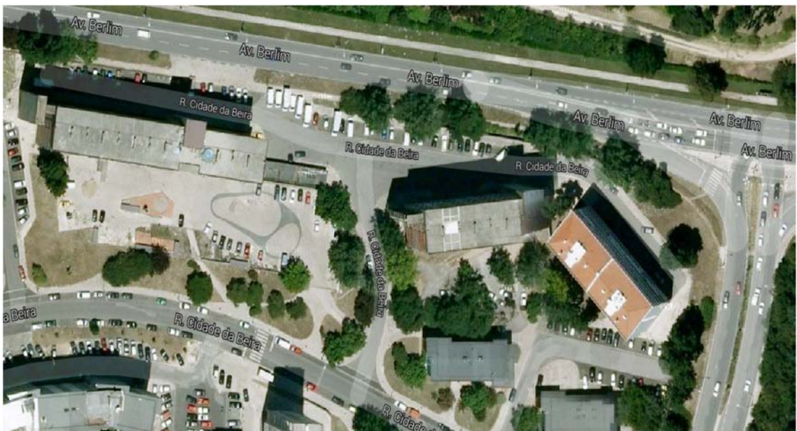
Fotografia 34 - Olivais Sul – Imagem aérea do edifício em estudo a reabilitar
