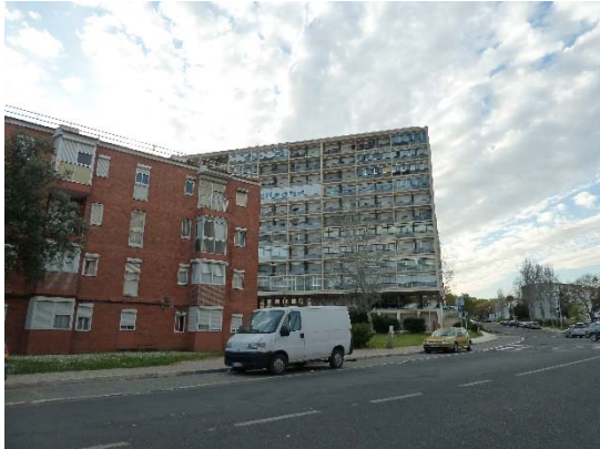
Fotografia 13 - Olivais Norte – Bandas de Arq. Braula Reis e João Mattoso e Edifício de 10 pisos de Arq. João Abel Manta
