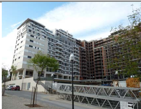
Fotografia 32 - Olivais Sul – Nova construção junto ao Spacio Shopping
