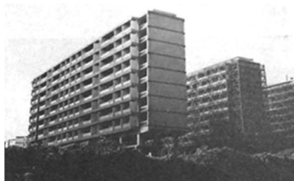
Fotografia 10 - Olivais Norte - Edifício de 8 pisos Arq. Artur Pires Martins e Cândido Palma de Melo (Fonte: Revista Municipal de Lisboa, nº98, 1963)
