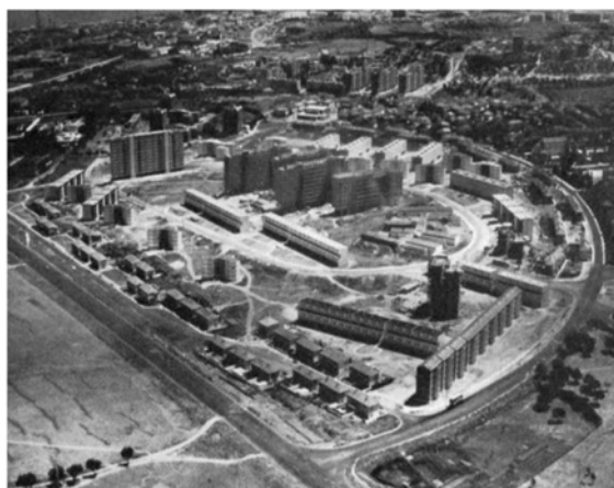
Fotografia 5 - Construção dos Olivais Norte 1967
