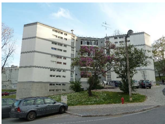
Fotografia 17 - Olivais Norte – Edifícios de 4 pisos (de planta em Y) – Arq. João Vasconcelos
