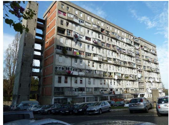
Fotografia 36 - Olivais Sul – Edifício em estudo Rua Cidade da Beira, 81
