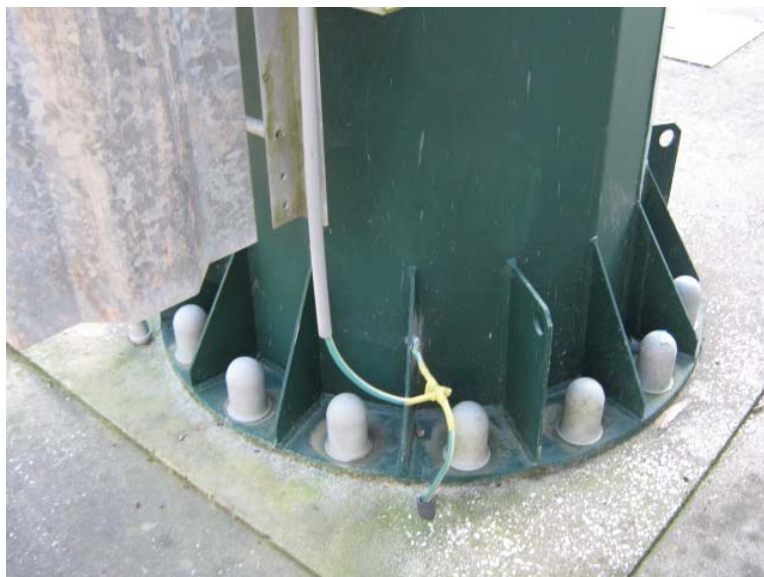
Figura 4 – Ligação tipo da base de uma Torre
