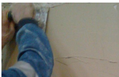
Aplicação do REABILITA Cal Acabamento
