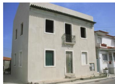
Aspecto final da argamassa
