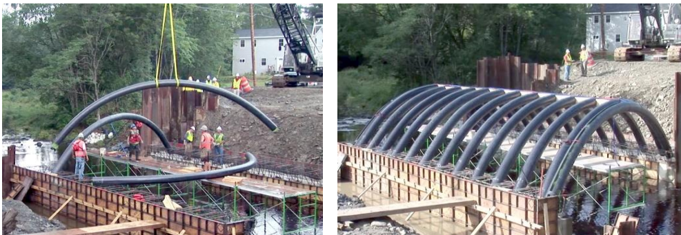
Figura 2.41 - Colocação de arcos pré-fabricados de CFRP (esq.), aspeto final dos arcos já preenchidos com betão (dirt.) [Universidade de Maine / AEWC]
