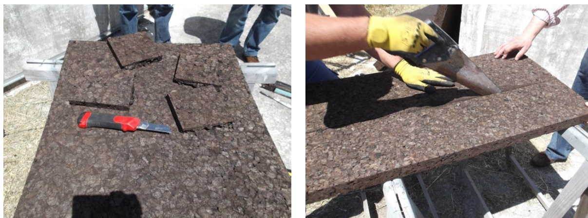
Figura 32 Corte de placas de aglomerado com menor espessura
