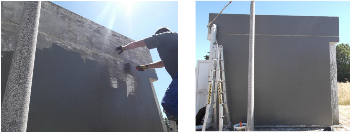
Figura 31 Aplicação da cola impermeabilizante
