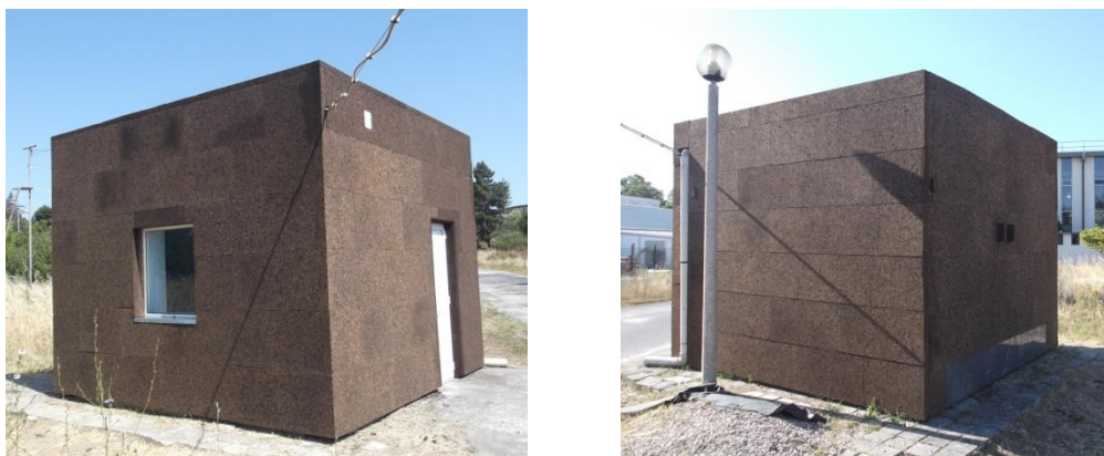
Figura 42 Finalização da aplicação das placas de aglomerado
