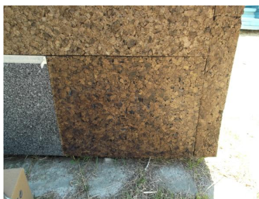
Figura 45 Aplicação de verniz incolor
