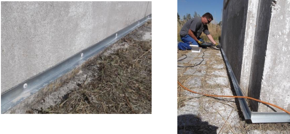
Figura 25 Colocação do perfil de aço
