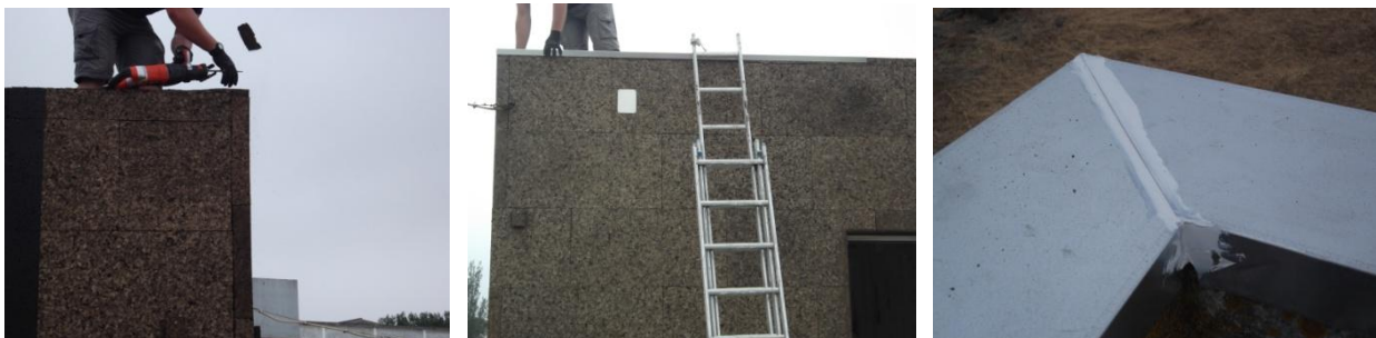
Figura 47 Colocação da chapa de remate com a cobertura
