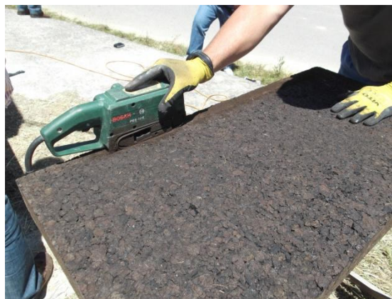
Figura 29 Lixagem para assento das placas de aglomerado no perfil de aço
