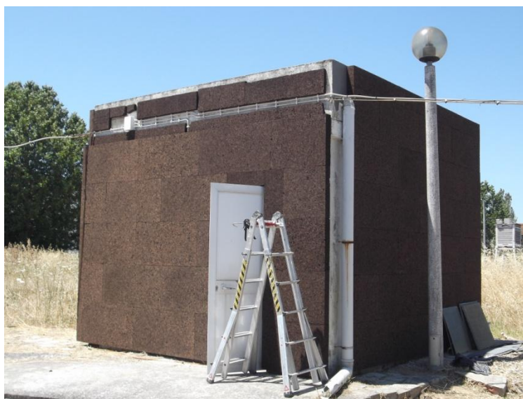
Figura 39 Aplicação de placas de menor espessura
