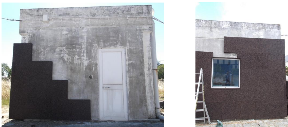
Figura 30 Colocação das placas com encaixe de topo (fachadas nascente à esq. e sul à dir.)
