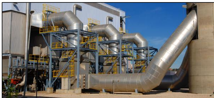
Figura 25: Sistema de tratamento dos efluentes gasosos correspondentes às três linhas de incineração da CTRSU (Valorsul, 2014)
