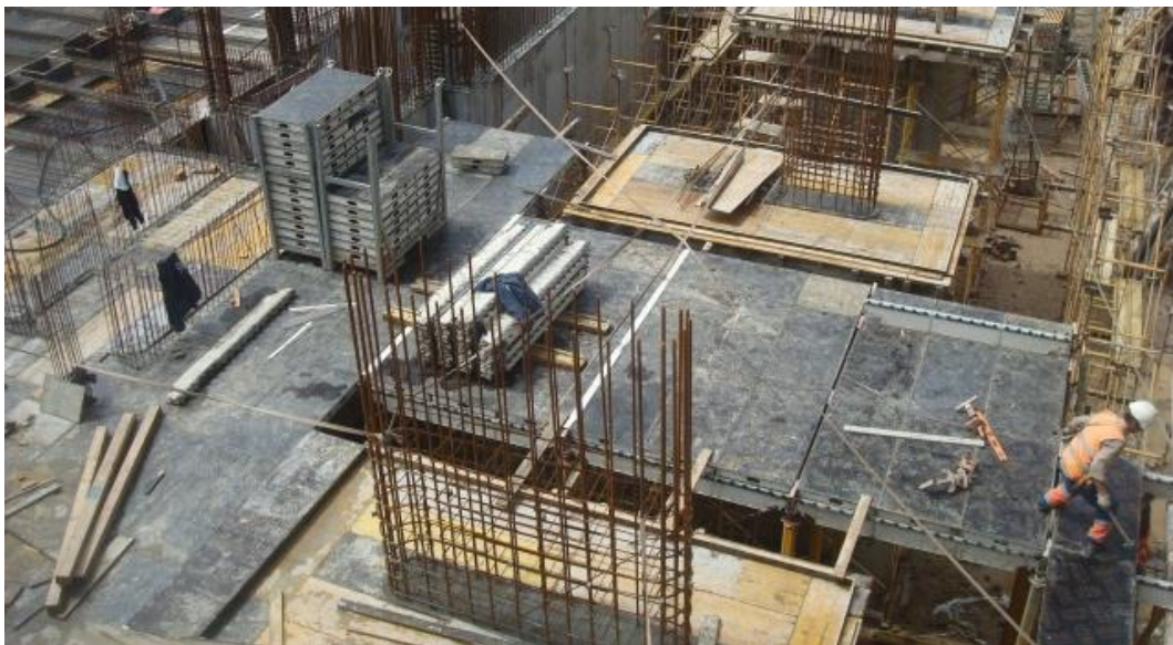
Figura 24 – Cofragem da laje de duplo pé-direito;
