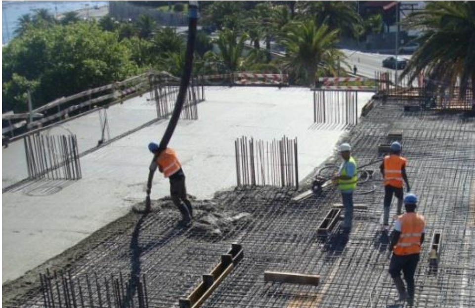
Figura 62 – Armação/aplicação de aço e betonagem;
