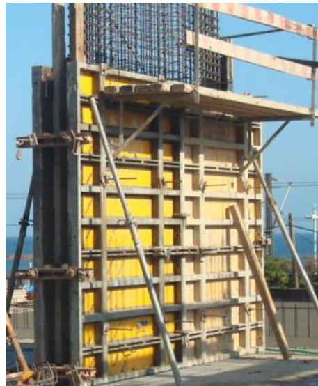
Figura 37 – Pilar executado com os painéis Doka ;
