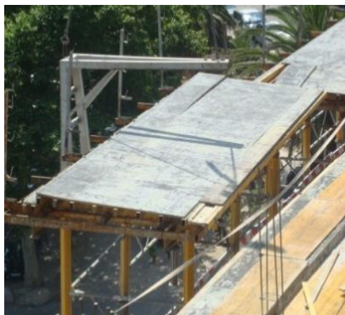
Figura 59 – Colocação da Mesa de cofragem especial com recurso a grua;
