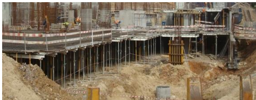
Figura 43 – Zona condicionante da obra - poços de fundação;
