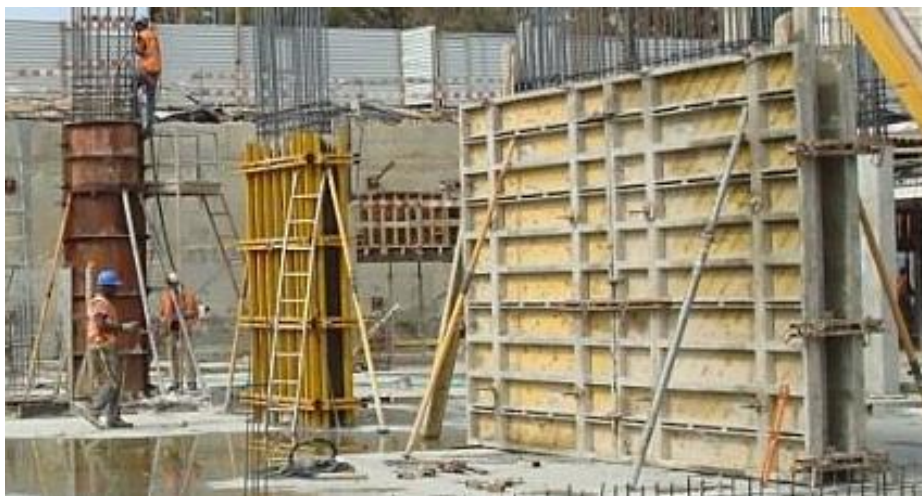
Figura 40 – Cofragem de pilares com as diversas soluções;
