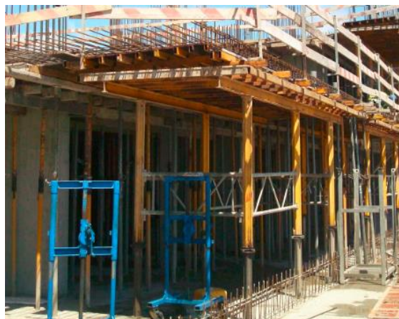
Figura 28 – Mesa de cofragem especial para consola de espessura variável;
