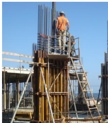
Figura 71 – Betonagem de pilar;
