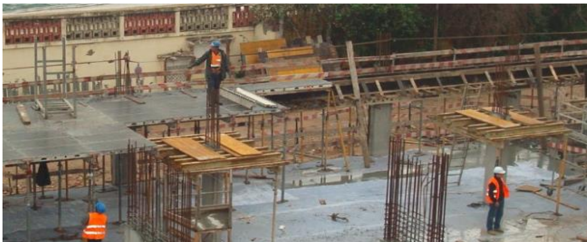
Figura 22 – Conjugação dos Sistemas para execução de laje;
