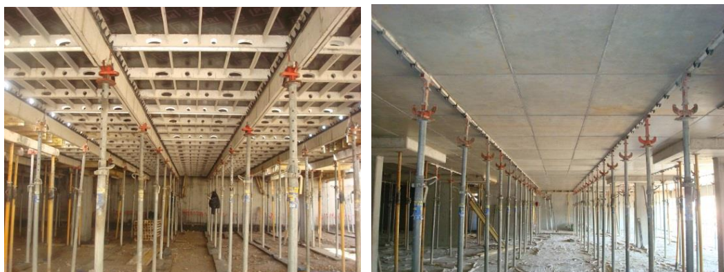
Figura 18 – Sistema de cofragem Skydeck ;
