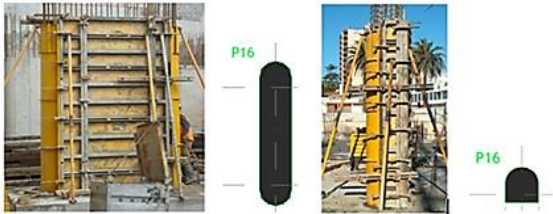
Figura 39 – Pilar P16 e sistema de cofragem adoptado;
