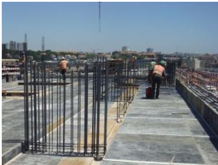
Figura 61 – Aspecto final da laje tipo;
