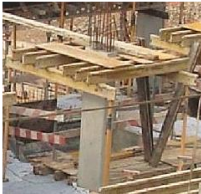
Figura 20 – Sistema Dokaflex e sua aplicação nos capitéis;
