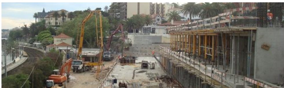
Figura 44 – Condicionantes para a betonagem de laje no piso 1;
