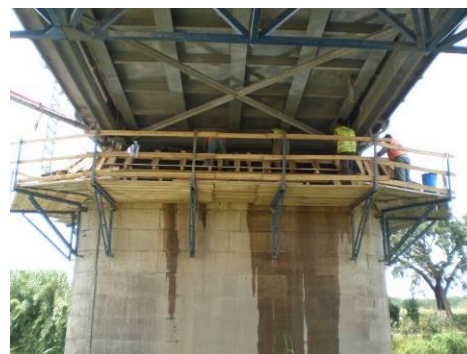
Figura 62: Plataforma fixa de acesso ao pilar
