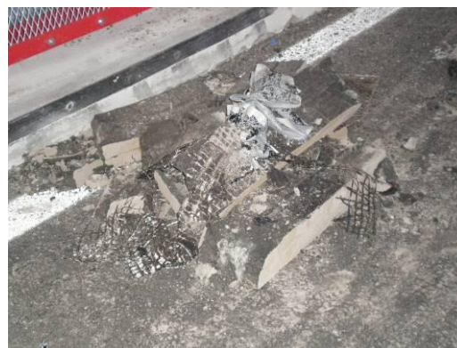
Figura 157: Destroços provenientes da remoção do betuminoso
