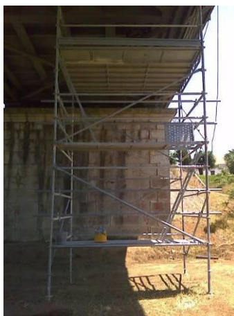
Figura 63: Andaime de serviço para acesso aos encontros
