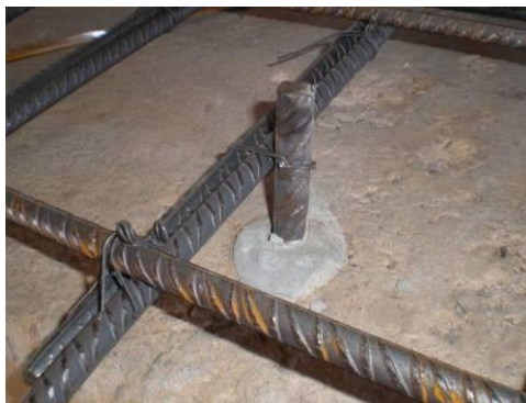
Figura 101: Amarração dos conectores à armadura de aço
