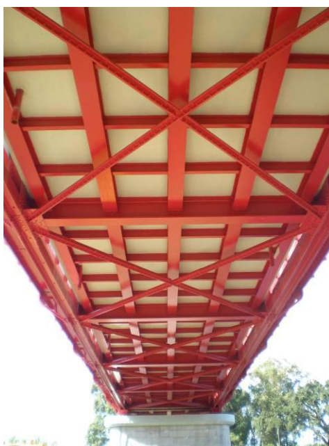
Figura 128: Aspecto final da face inferior do tabuleiro
