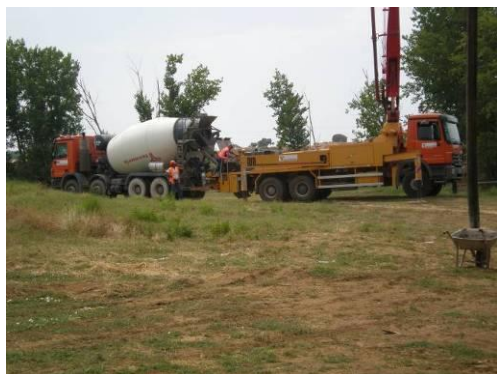
Figura 110: Recepção do betão pronto no Camião Bomba
