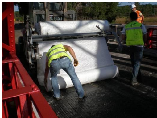
Figura 151: Aplicação da grelha em fibra de vidro
