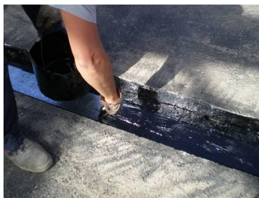
Figura 173: Aplicação da rega de colagem sobre as chapas metálicas
