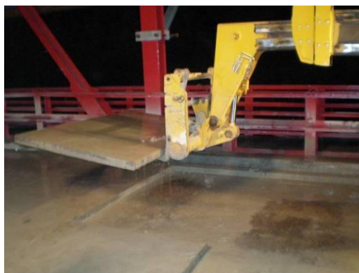
Figura 138: Remoção das placas do pavimento após os cortes transversais e longitudinais
