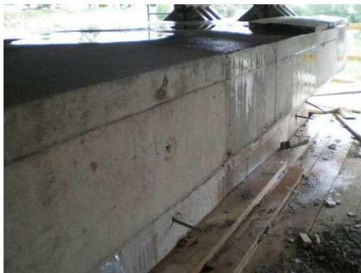
Figura 115: Aspecto final da superfície após descofragem
