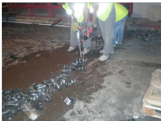
Figura 156: Remoção do betuminoso compreendido entre os cortes
