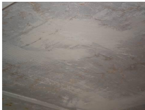
Figura 98: Aspecto da argamassa após acabamento final
