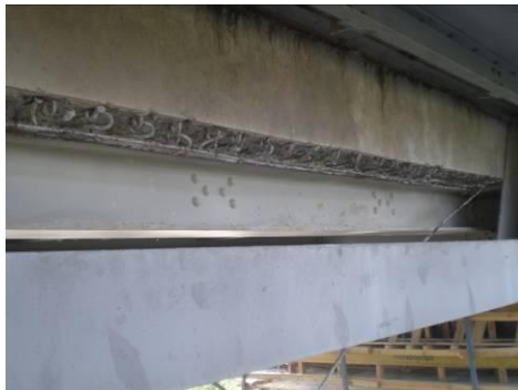
Figura 117: Corte e demolição da secção inferior da viga-lancil
