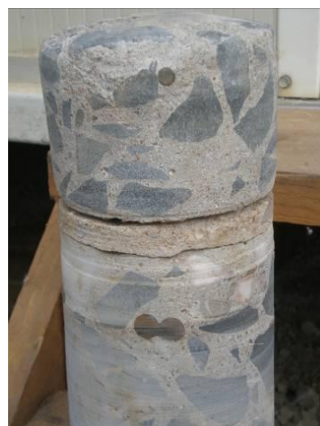
Figura 136: Carote realizado no tabuleiro da Ponte
