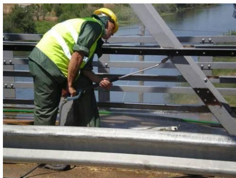
Figura 121: Lavagem das superfícies a alta pressão
