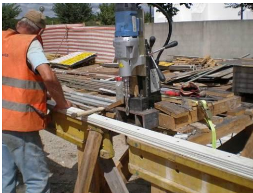
Figura 65: Bancada para realização dos furos nas barras metálicas
