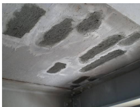
Figura 97: Aspecto da argamassa antes do acabamento final
