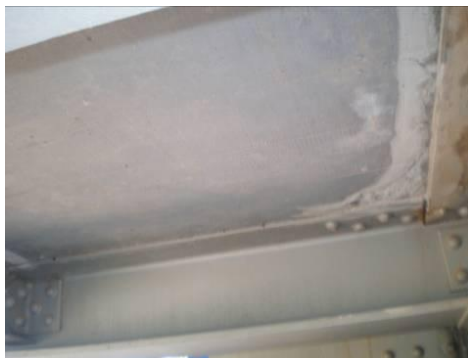
Figura 95: Aspecto final da protecção na face inferior do tabuleiro
