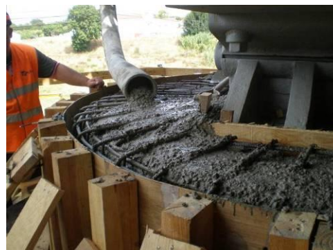
Figura 111: Lançamento do betão pronto
