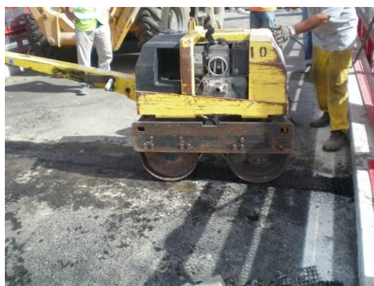
Figura 179: Compactação ultima camada com cilindro de rolo
