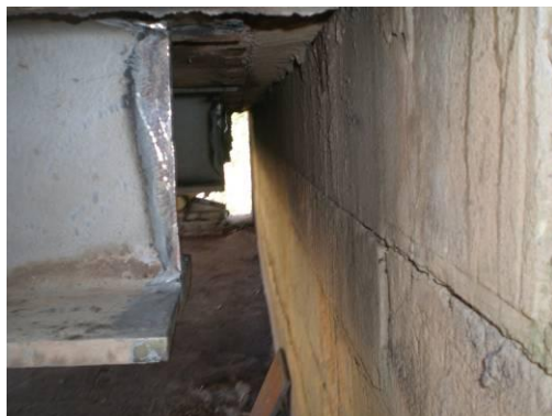
Figura 17: Cordas inferiores das vigas principais sem batentes nos encontros
