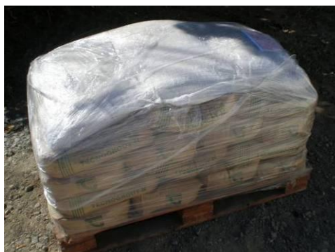
Figura 202: Palete de material devidamente embalada e protegida
