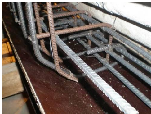
Figura 102: Amarração dos estribos à armadura longitudinal
