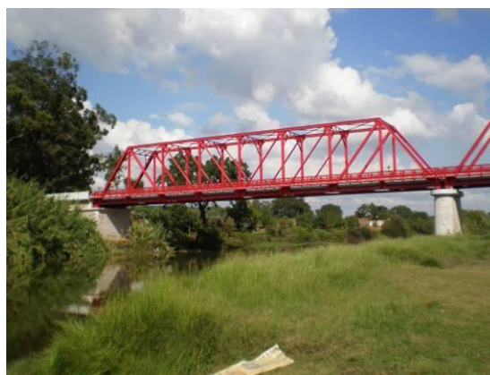
Figura 129: Aspecto geral do sistema de protecção aplicado na estrutura
