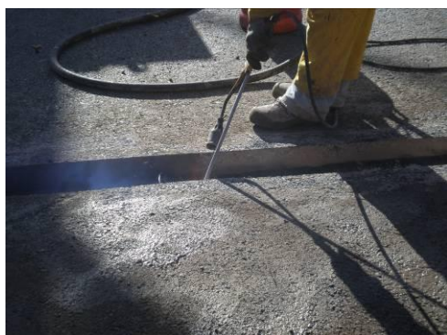
Figura 170: Aquecimento com lança térmica
