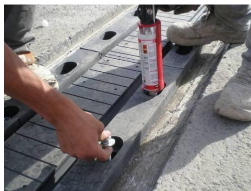
Figura 164: Colocação da resina epoxica e pernos de fixação
