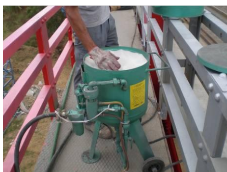
Figura 57: Equipamento de decapagem
