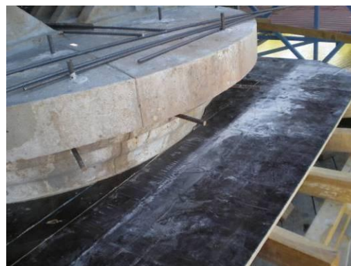
Figura 107: Aplicação do molde inferior em painéis de contraplacado marítimo
