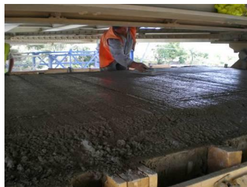
Figura 113: Talochamento da superfície do betão
