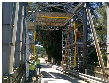
Figura 64: Andaime móvel interior de acesso à estrutura metálica
