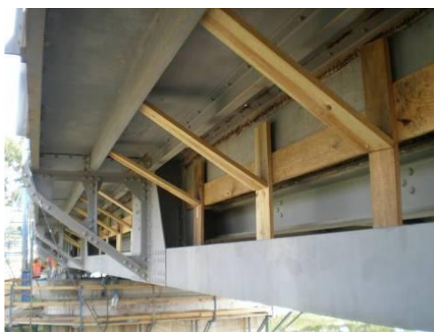
Figura 118: Aplicação de moldura com gabarito antes do enchimento com argamassa
