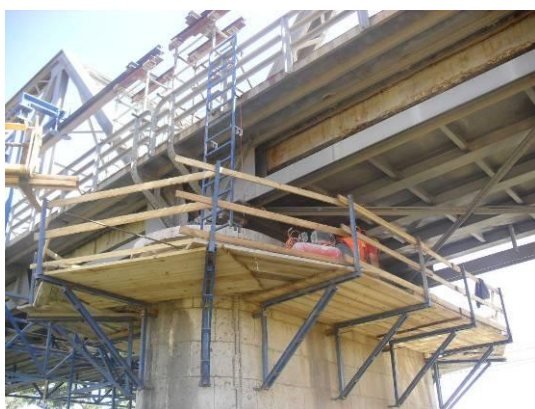
Figura 182: Plataforma de acesso ao pilar central
