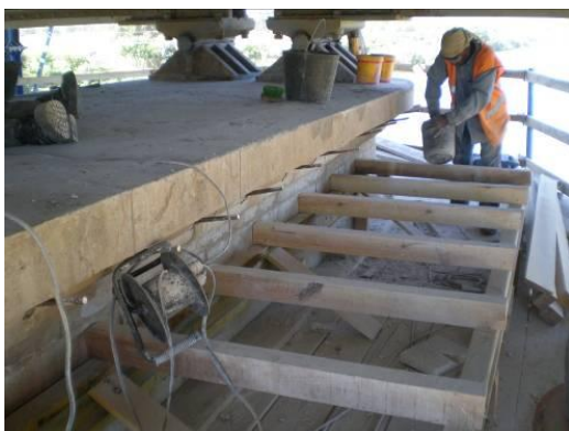
Figura 106: Execução do cavalete de apoio da cofragem
