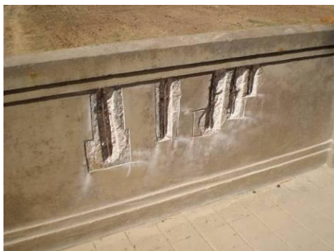
Figura 93: Aspecto final após o corte e remoção do betão deteriorado
