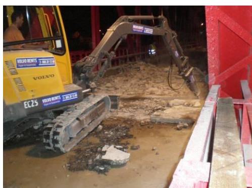
Figura 139: Demolição da argamassa com o martelo hidráulico
