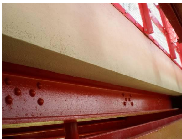
Figura 133: Aspecto geral da face exterior da viga-lancil
