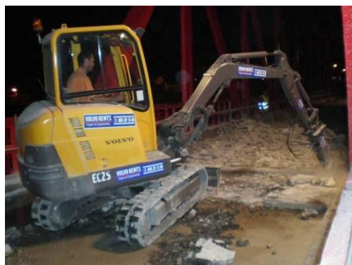
Figura 49: Miniescavadora com martelo hidráulico Volvo EC25
