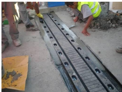
Figura 167: Aplicação do “grout” nas bandas de transição
