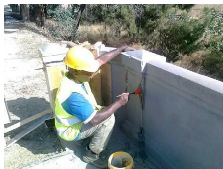
Figura 94: Aplicação do Sika Monotop 910 nos Guarda-Corpos de betão
