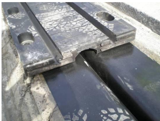
Figura 162: Instalação da membrana de drenagem de águas
