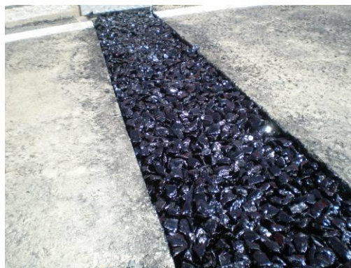
Figura 177: Aplicação dos inertes com a mistura betuminoso na caixa da junta
