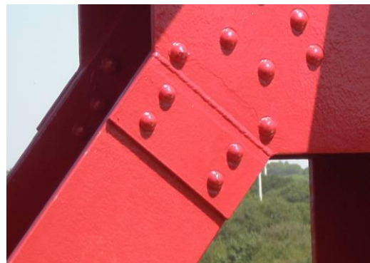
Figura 79: Aspecto final dos rebites após aplicação do sistema de protecção
