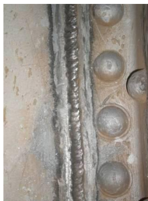
Figura 84: Aspecto final do cordão de soldadura
