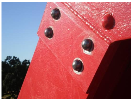
Figura 78: Aspecto final das cabeças dos rebites após a sua instalação
