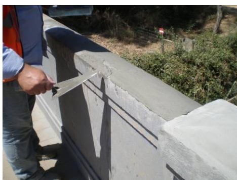
Figura 96: Aplicação manual do Sika Monotop 612 nos Guarda-Corpos
