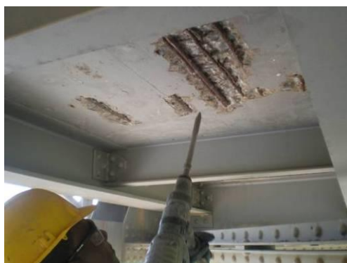
Figura 91: Demolição do betão deteriorado após o corte com disco diamantado
