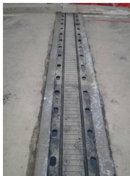
Figura 169: Aspecto final da junta de dilatação
