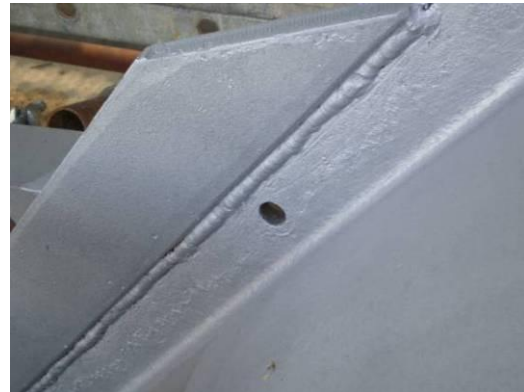
Figura 71: Aspecto final da soldadura no reforço inferior na diagonal após limpeza e aplicação da protecção anticorrosiva
