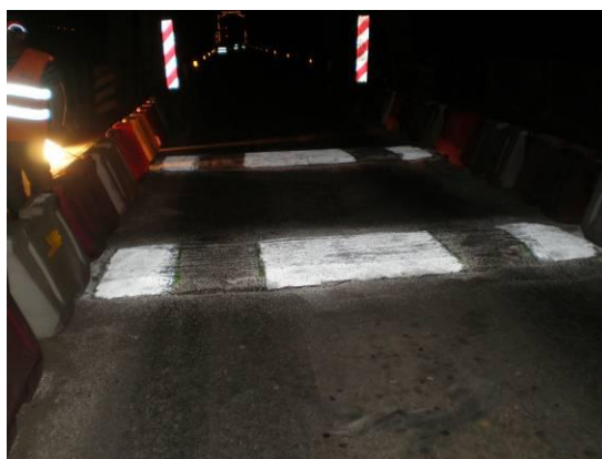
Figura 191: Lombas na faixa rodoviária
