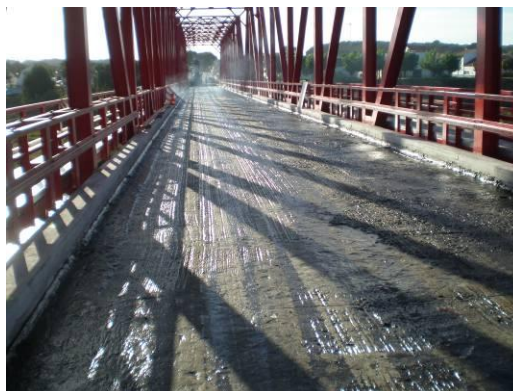
Figura 150: Aspecto final do tabuleiro após impermeabilização
