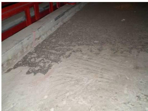
Figura 146: Limpeza dos detritos resultantes da demolição
