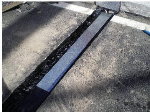
Figura 172: Colocação das chapas metálicas
