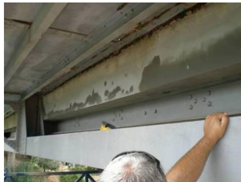
Figura 120: Viga-lancil após reabilitação com argamassa de elevada resistência
