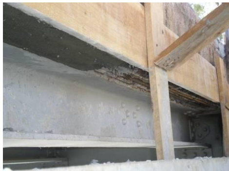
Figura 119: Enchimento com Mapegrout Tissotropico
