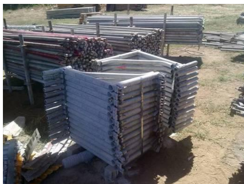
Figura 204: Acondicionamento de materiais de andaime para transporte
