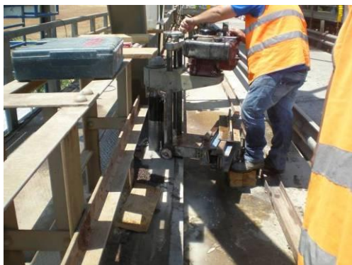
Figura 135: Realização da carotagem no tabuleiro da Ponte
