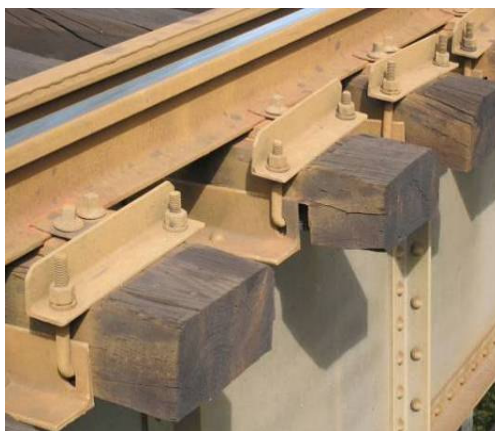
Figura 8.6 - Pormenor do tipo de fixação existente.
