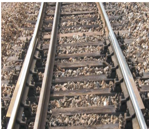
Figura 8.4 - AD à entrada da ponte.
