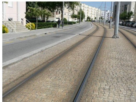
Figura 11.6 - Via betonada com revestimento em cubos de granito.
