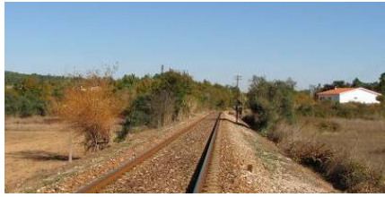
Figura 9.4 – PN – Km 20+188 – Situação actual (Sentido Miranda do Corvo / Serpins).
