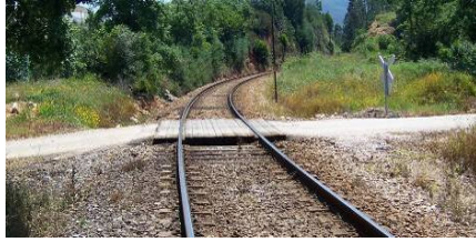
Figura 9.26 – PN – Km 34+434 – Situação actual (Sentido Miranda do Corvo / Serpins).
