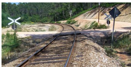
Figura 9.24 – PN – Km 32+122 – Situação actual (Sentido Miranda do Corvo / Serpins).
