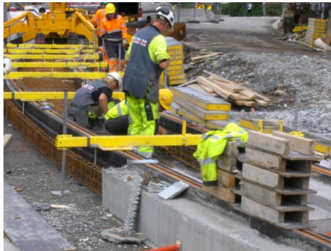
Figura 12.15 - Montagem da via betonada.
