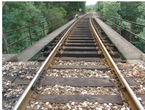
Figura 11.3 - Via nos encontros das pontes metálicas.
