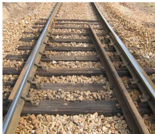
Figura 8.5 - AD à saída da ponte.
