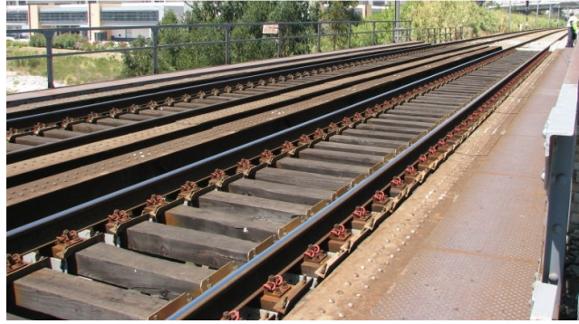
Figura 11.2 - Via em pontes metálicas.
