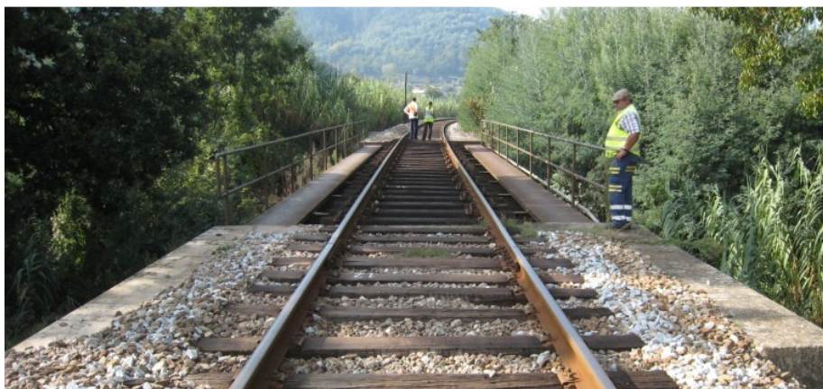
Figura 8.1 – Ponte de São João (Sentido Serpins / Miranda do Corvo).
