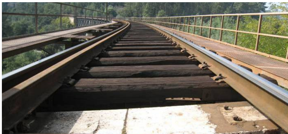
Figura 8.3 – Ponte de Serpins (Sentido Serpins / Miranda do Corvo).
