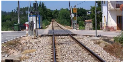
Figura 9.20 – PN – Km 30+102 – Situação actual (Sentido Miranda do Corvo / Serpins).
