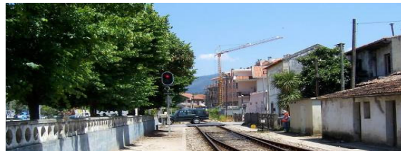
Figura 9.3 – PN – Km 19+310 – Situação actual (Sentido Miranda do Corvo / Serpins).
