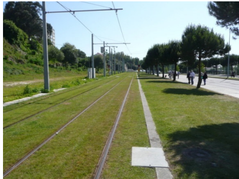
Figura 11.5 - Via betonada com revestimento relva.
