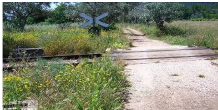
Figura 9.22 – PN – Km 30+808 – Situação actual (Sentido Miranda do Corvo / Serpins).
