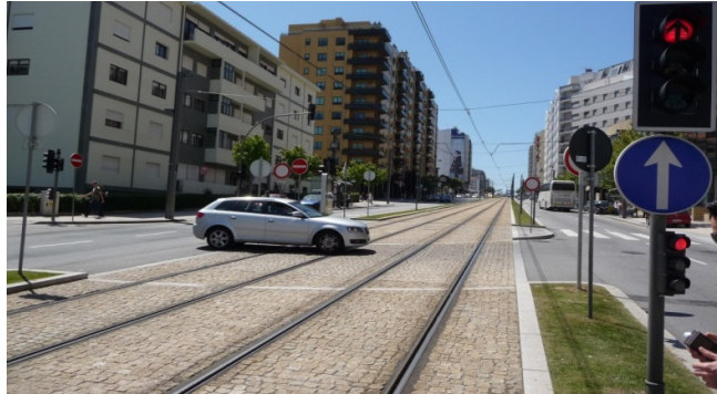
Figura 9.2 - Atravessamentos em zonas de via betonada
