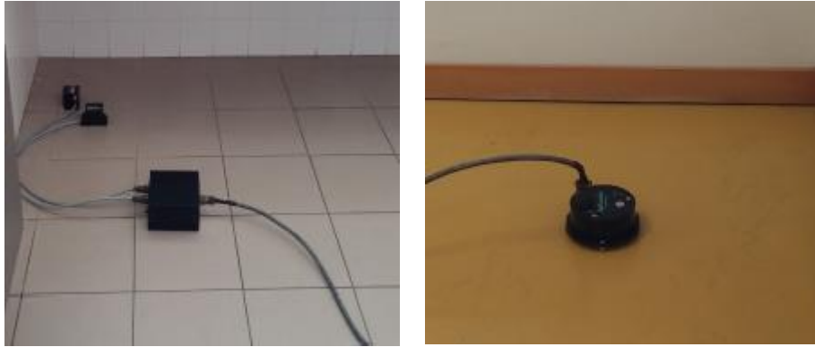
Figura 6.21 – Equipamentos utilizados no ensaio de vibração ambiental: a) par de acelerómetros uniaxiais; b) acelerómetro triaxial.
