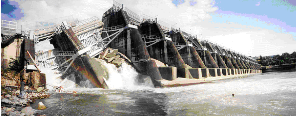
Figura 2-4 – Vãos danificados da barragem de Shih-Kang (Taiwan) pelo sismo Chi-Chi em Setembro de 1999 [Página de internet 5].
