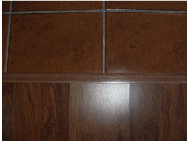
Figura 26– Aspecto de um perfil de transição em T entre divisões [Habitação particular]
