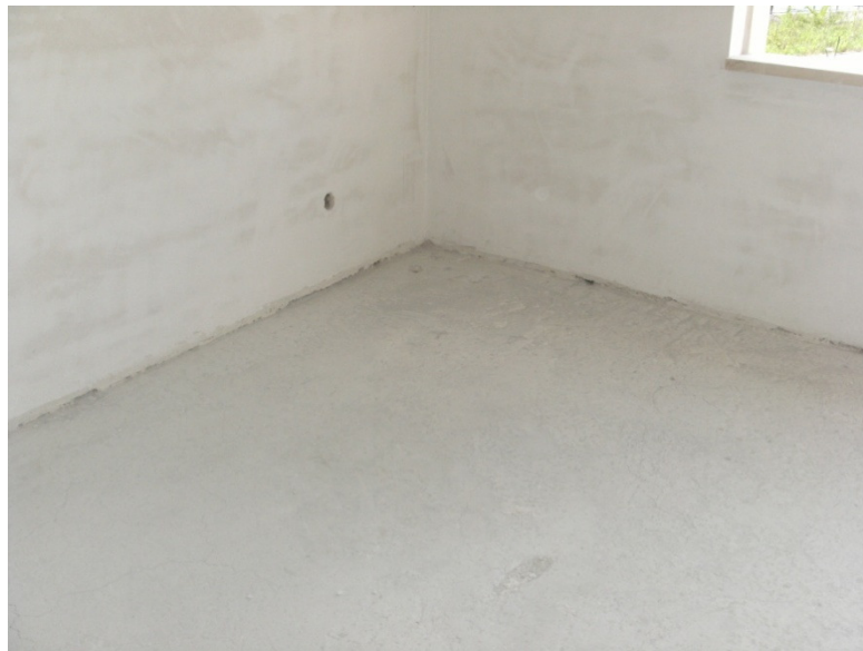
Figura 10 – Aspecto final da sub-base em betão [Habitação particular]
