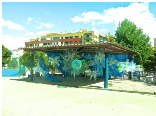
Fig.105 | Instalação - vista exterior.
