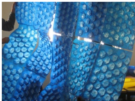
Fig.97 | Processo de execução de revestimentos laterais.
