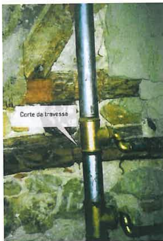
Figura 3.14 – Exemplo de remoção de corte da travessa [Lopes e Monteiro, 2008].
