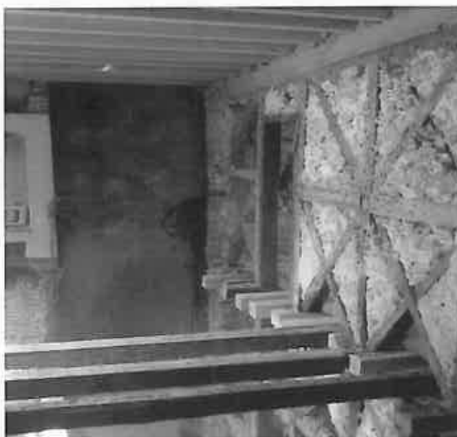
Figura 4.3 – Paredes de Frontal e vigeamento dos pisos.
