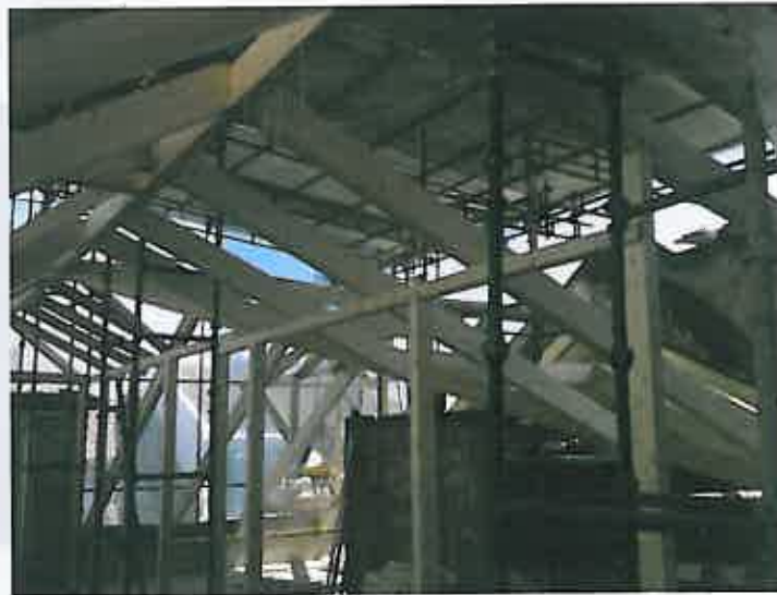
Figura 5.33 – Estrutura da cobertura.
