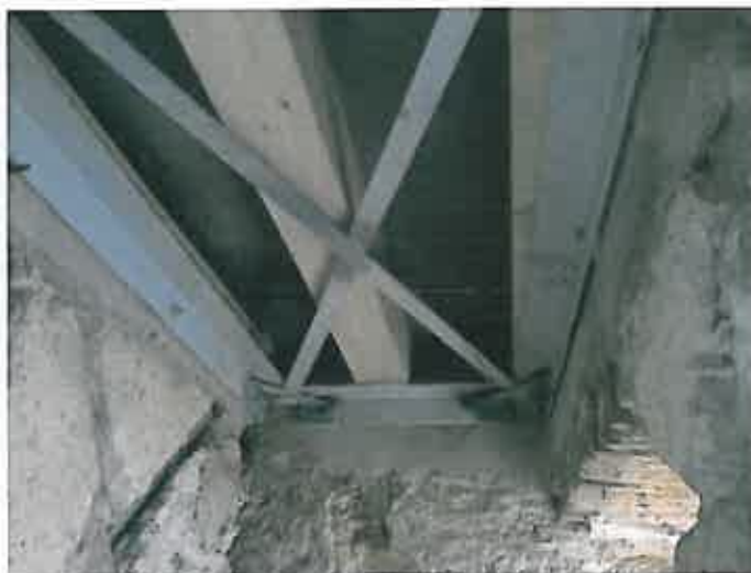
Figura 5.24 – Soldadura topo a topo entre cantoneiras metálicas
