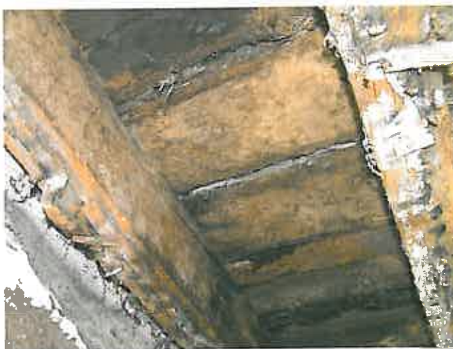
Figura 4.4 – Evidência de presença de Caruncho.
