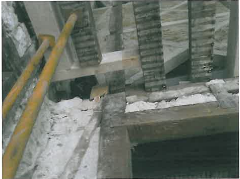
Figura 5.38 – Abertura em pavimentos para execução de couretes.
