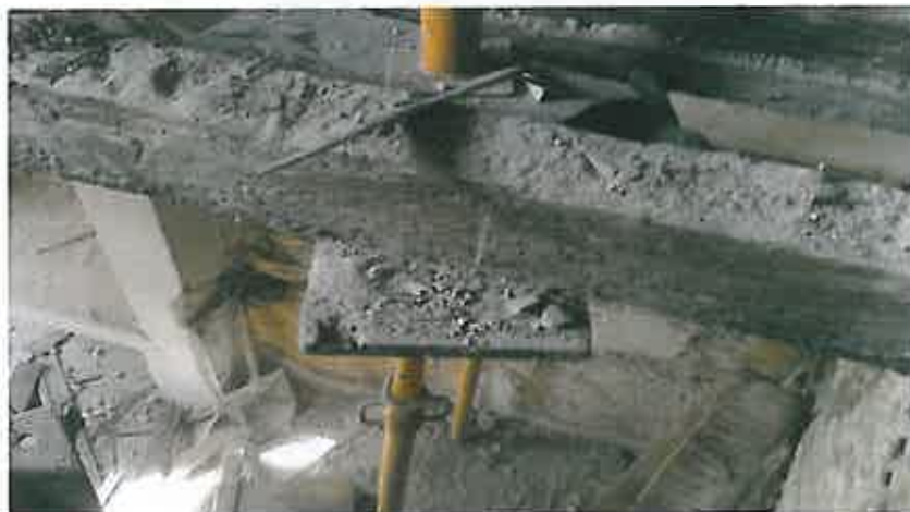
Figura 3.11 – Exemplo de viga com orifícios de saída.
