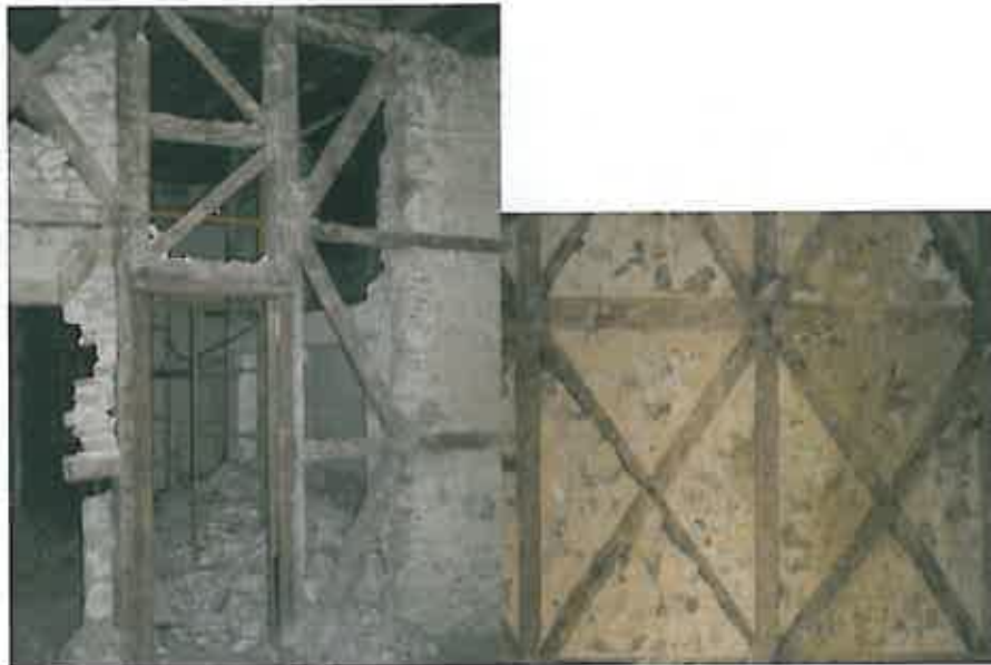
Figura 3.7 – Exemplo parede de frontal.
