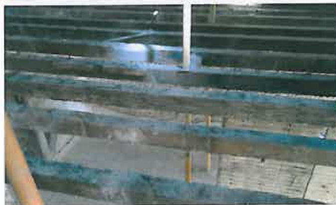
Figura 5.14 – Vigas de madeira dos pisos em elevado estado de degradação.
