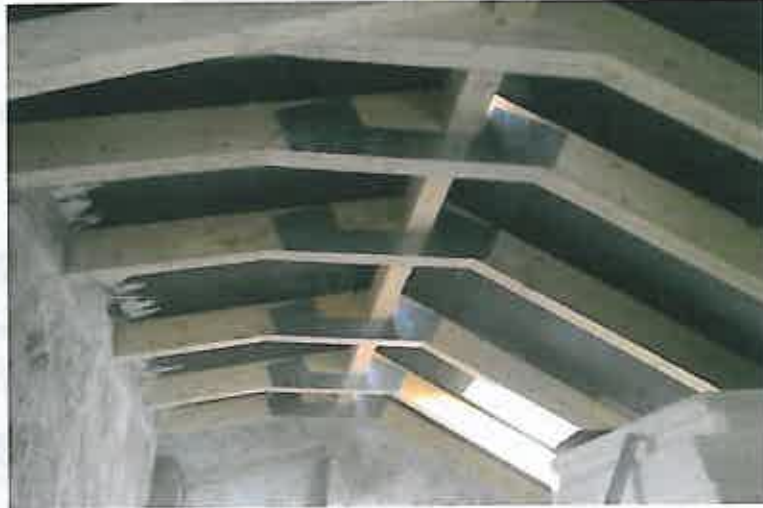
Figura 5.32 – Chapas de ligação entre elementos da cobertura.
