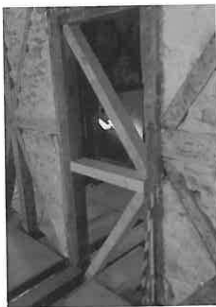
Figura 5.21 – Fecho de vão existente com novas vigas de madeira.
