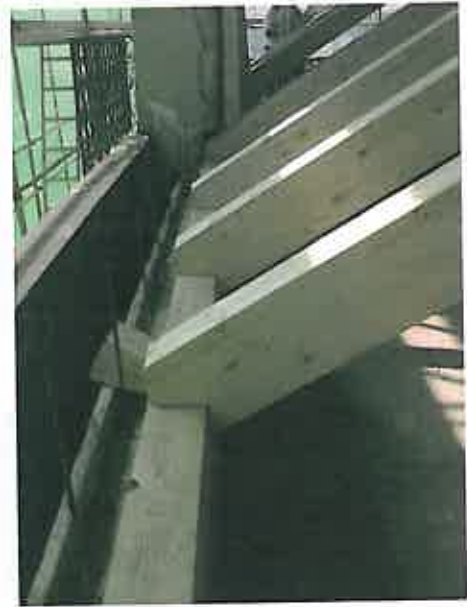
Figura 5.31 – Execução de Frechal.
