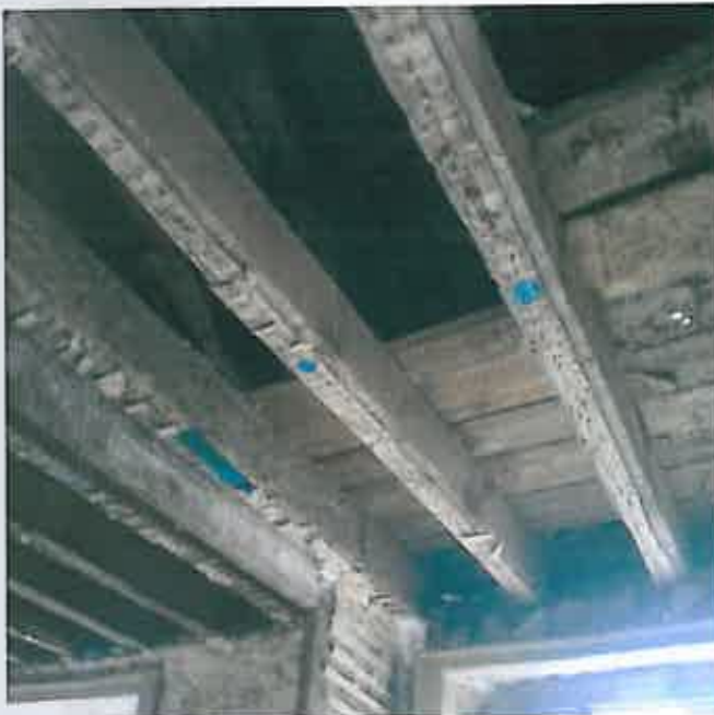
Figura 5.16 – Marcação das vigas a remover com spray.
