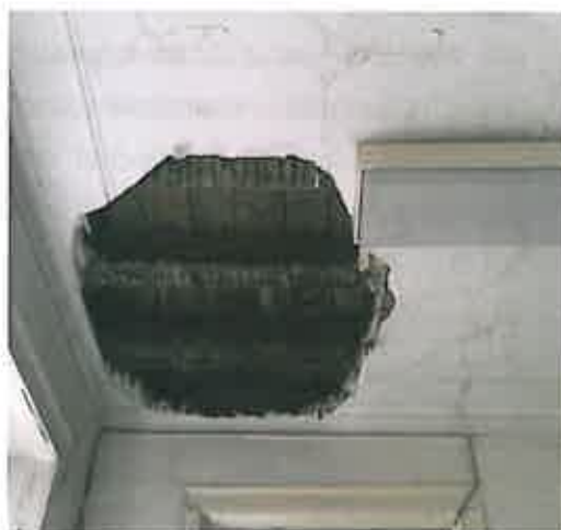
Figura 5.11 – Parte demolida de tectos em estafe existentes.
