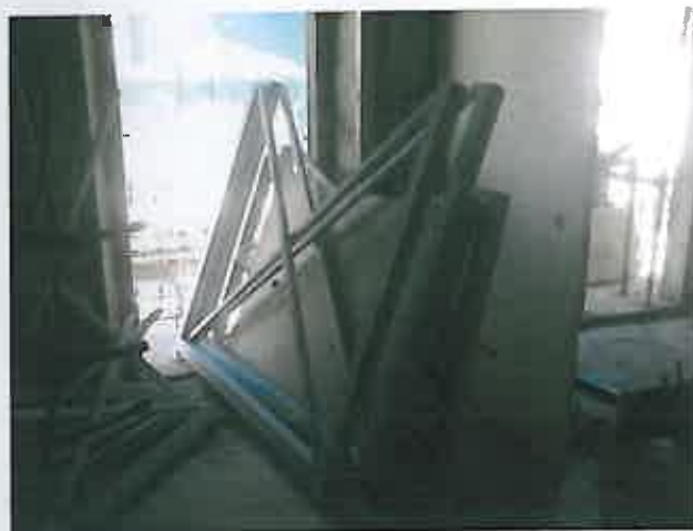
Figura 5.36 – Elementos pré fabricados da estrutura do elevador.
