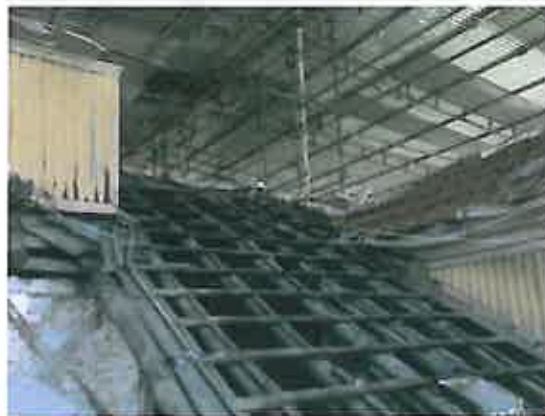
Figura 5.3 – Estrutura da cobertura.
