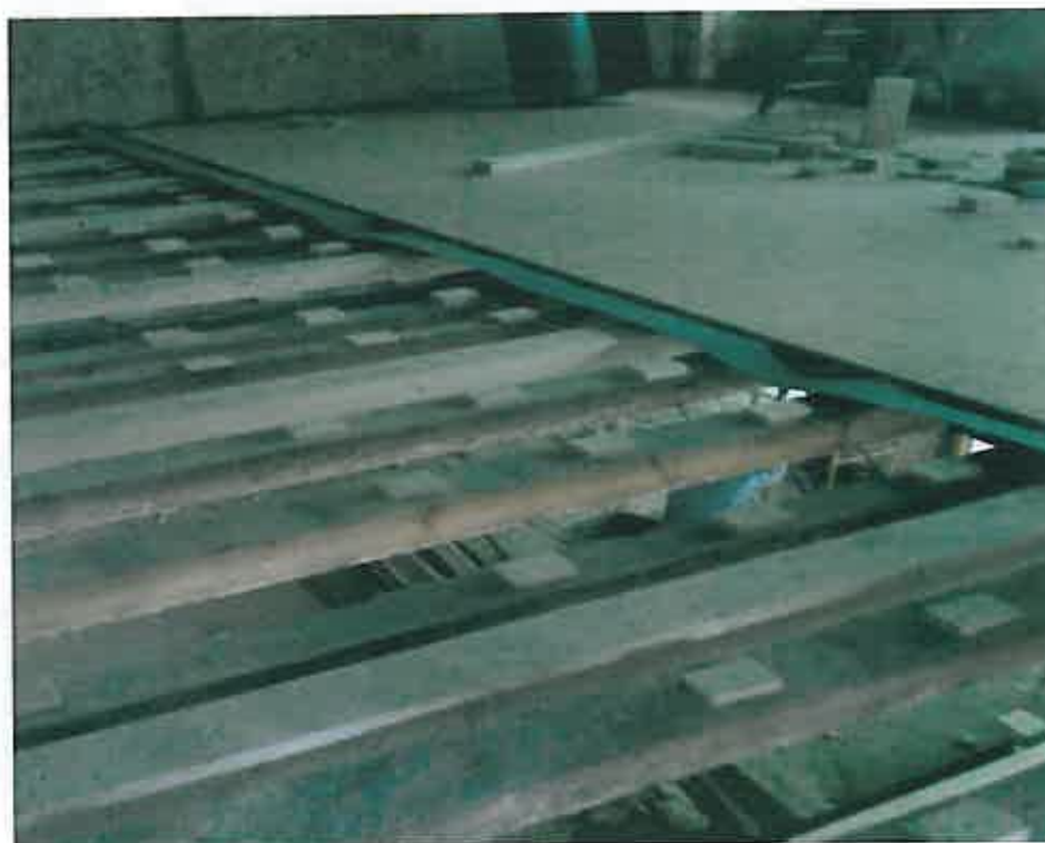
Figura 5.17 – Revestimento do pavimento já com elementos estruturais nivelados.
