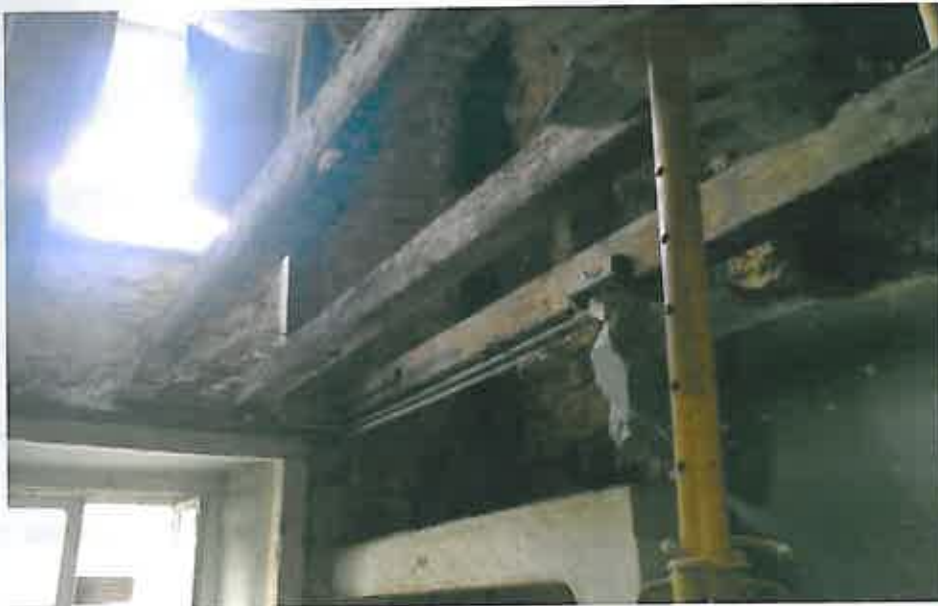
Figura 5.2 – Entrega do pavimento nas paredes exteriores.
