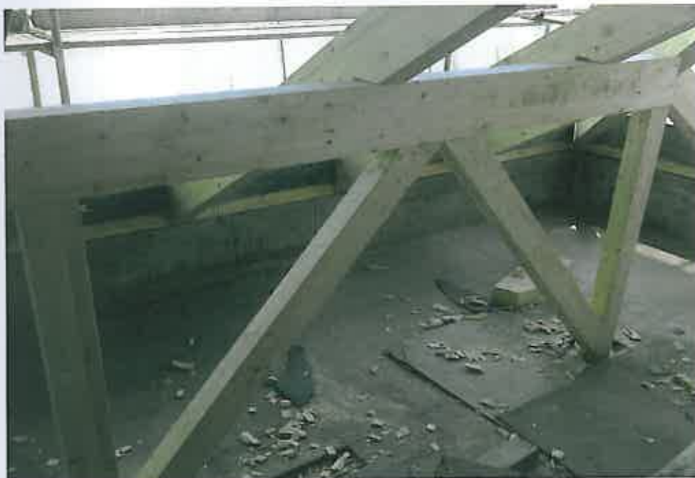
Figura 5.26 – Corte do pavimento já executado para ligação inferior das novas paredes de frontal
