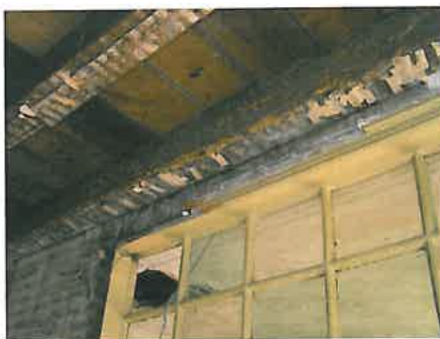
Figura 4.4 – Evidência de presença de Caruncho.
