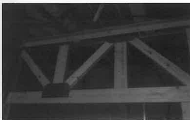
Figura 5.19 – Elementos estruturais das paredes de frontal ligados com chapas.
