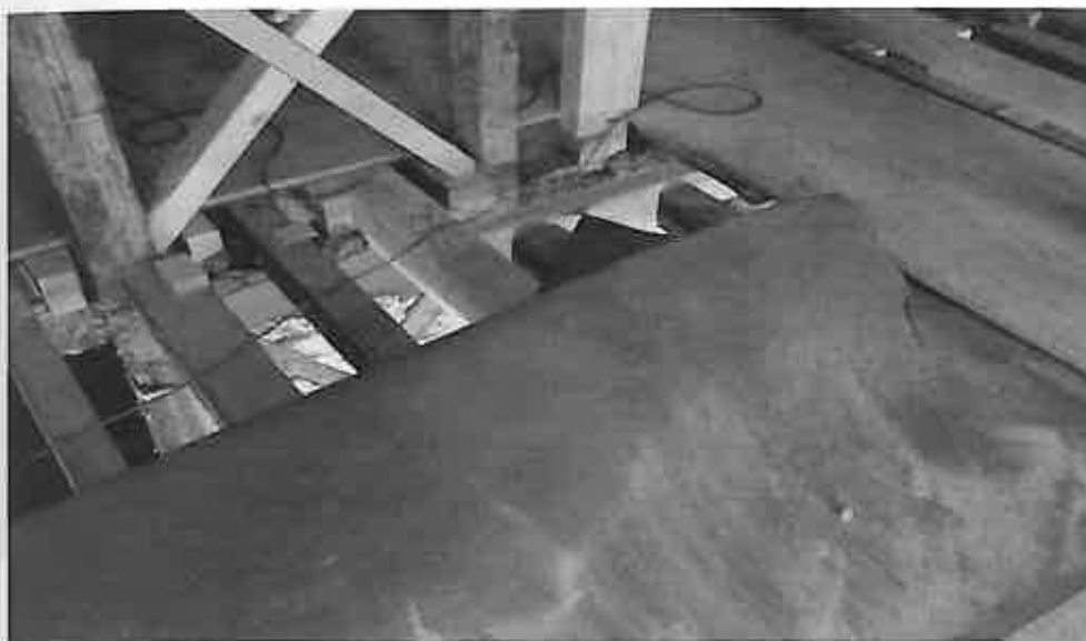
Figura 5.18 – OSB por colocar perto dos encontros com as paredes de frontal para selagem.
