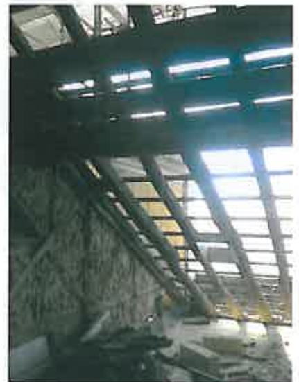
Figura 5.4 – Estrutura da cobertura.
