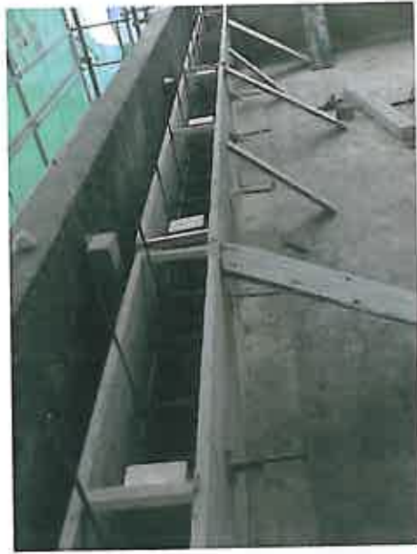
Figura 5.30 – Execução de Frechal.
