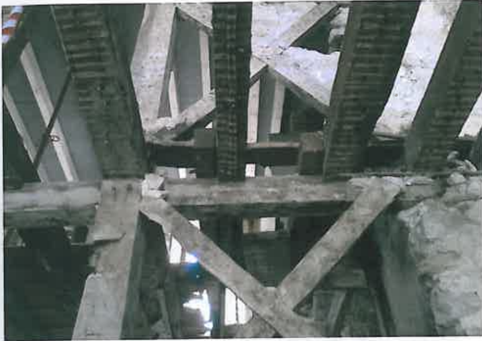
Figura 5.1 – Entrega do pavimento nas paredes de Frontal.
