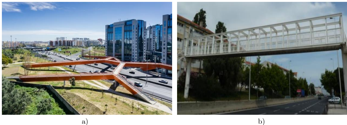
Figura 1.1 – Exemplos de pontes pedonais: a) Ponte pedonal sobre a segunda circular; b) Ponte pedonal na Avenida Marechal Gomes da Costa.
