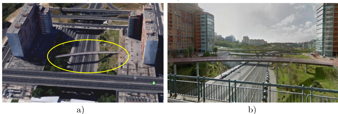
Figura 6.2 – Vista da ponte pedonal a estudar obtidas a partir do Google Earth; a) Vista Panorâmica; b) Vista lateral.
