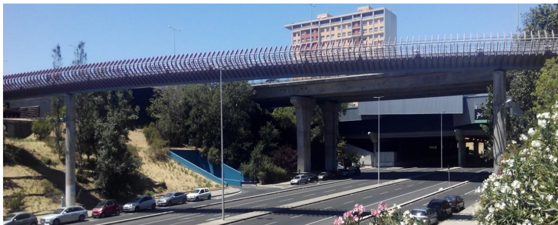
Figura 6.1 – Vista da ponte pedonal.
