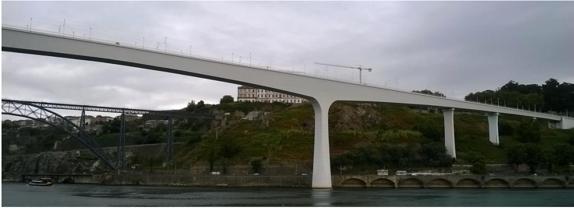
Figura 4.1 – Ponte ferroviária de São João vista do lado de Gaia.
