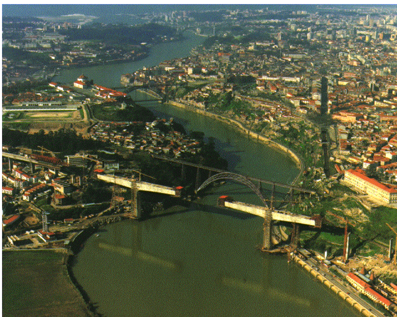
Figura 4.6 – Processo construtivo da ponte S. João à partir dos pilares centrais em consola. (Fonte: A Ponte de São João, de Luís Lousada Soares)
