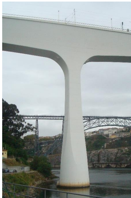
Figura 4.5 – Pormenor dos pilares da ponte ferroviária em estudo.
