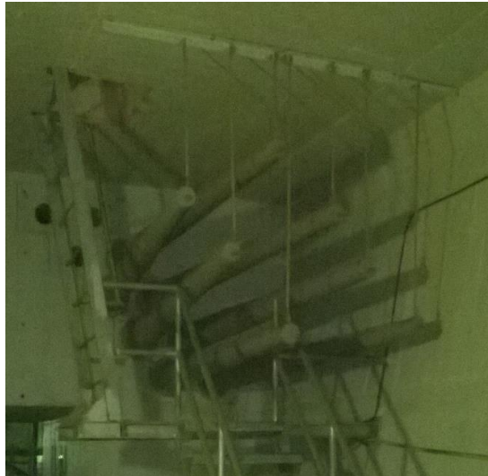
(a) Ancoragem sobre o pilar PD2
