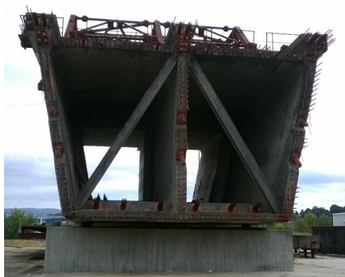
Figura 4.3 – Secção transversal da viga de caixão bicelular usada na ponte de São João.
