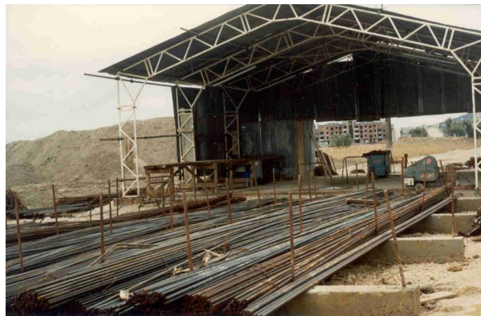
Figura 28 – Exemplo de armazenamento do aço evitando o contacto com o solo ( www.civil.ist.utl.pt )
