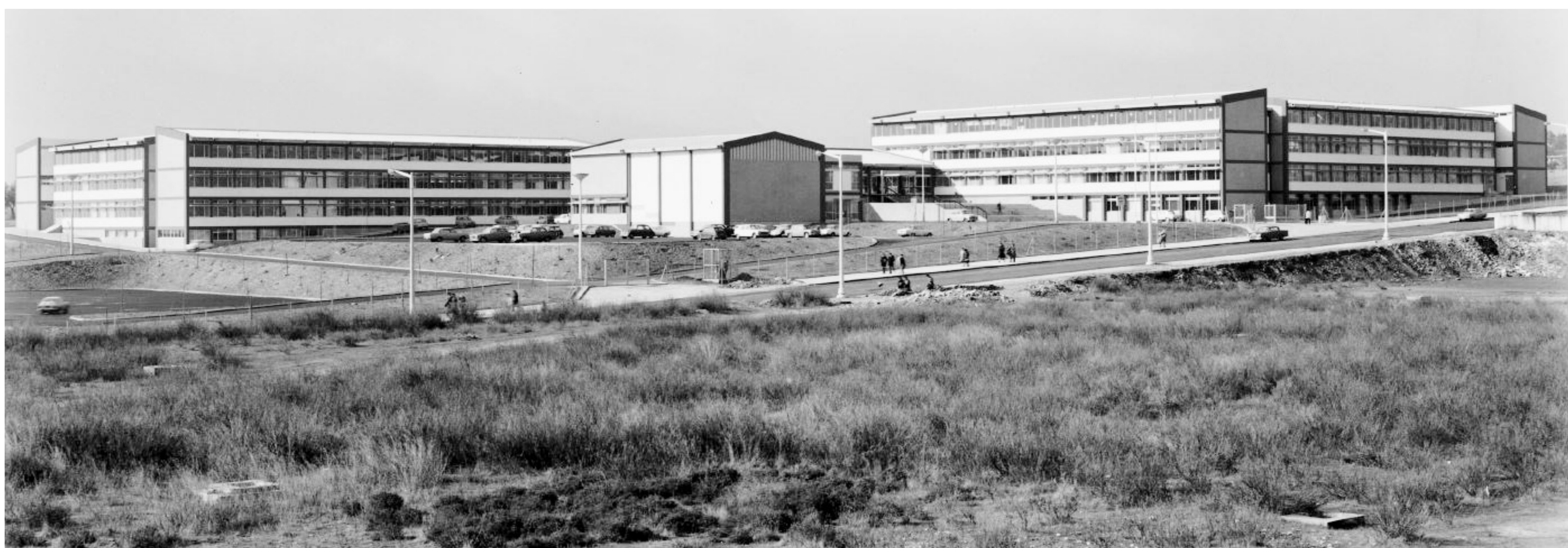
Vista geral das instalações do IIL em 1970 © ISEL
