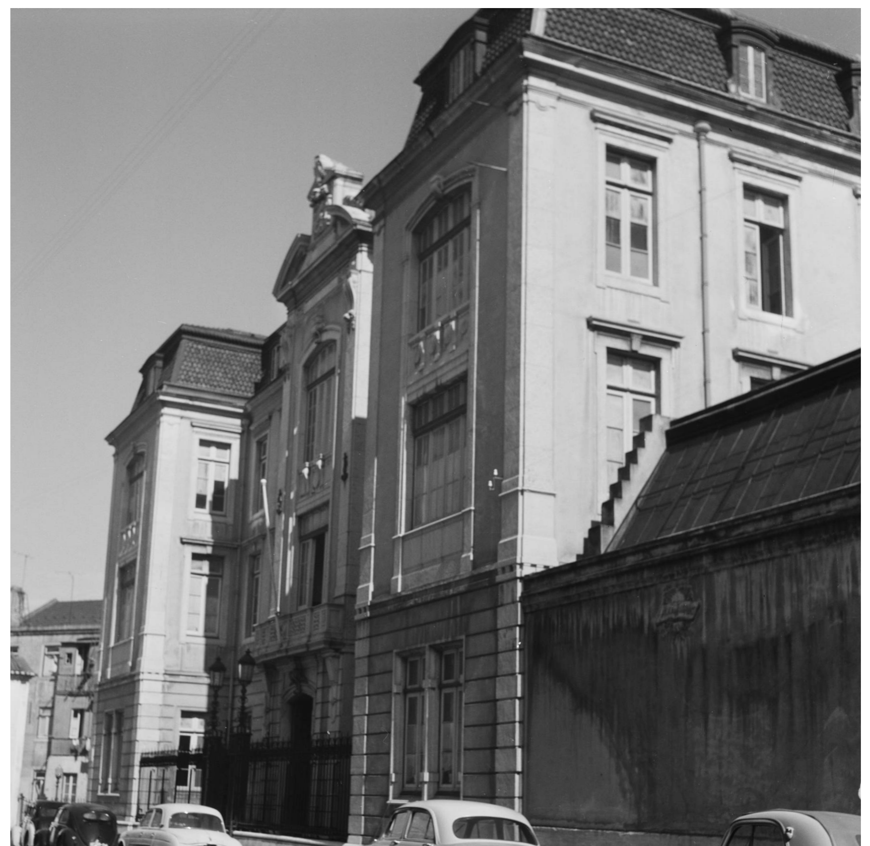
Instalações entre 1911 e 1913 da Secção Secundária do extinto Instituto Industrial e Comercial de Lisboa. Escola Industrial Marquês de Pombal, posteriormente Escola Secundária de Fonseca Benevides. Edifício devoluto. Rua de Alcântara © Arquivo Municipal de Lisboa
