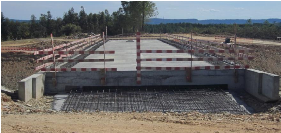
Laje de transição e tabuleiro betonado.
