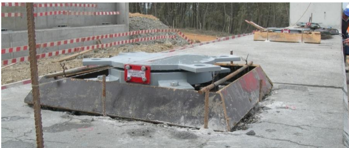
Aparelhos de apoio definitivos, armaduras de reforço na zona dos aparelhos de apoio e cofragem do plinto.
