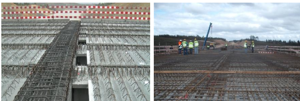
Tabuleiro: à esquerda pré-lajes colocadas e viga carlinga betonada e à direita armadura para “laje de compressão” colocada sobre o tabuleiro.
