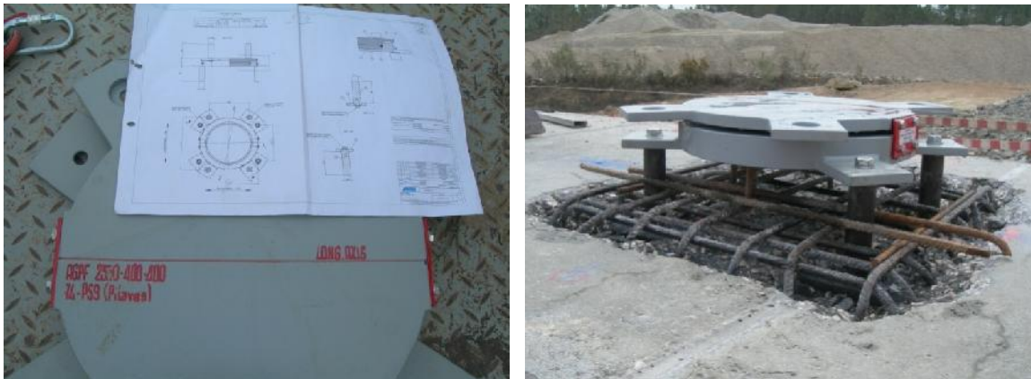
Aparelhos de apoio provisórios.
