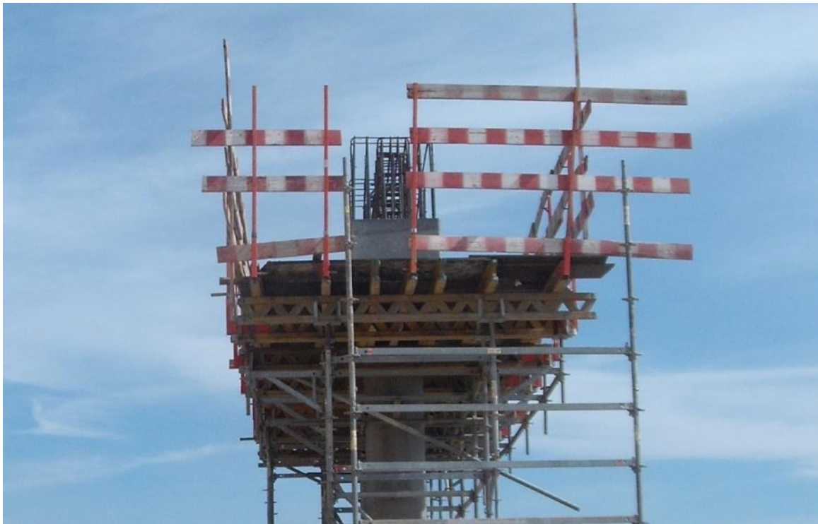
Pilares: viga travessa betonada e armaduras de espera para viga carlinga.
