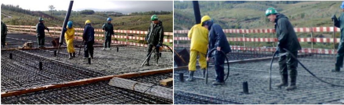
Tabuleiro: betonagem e vibração da “laje de compressão”.
