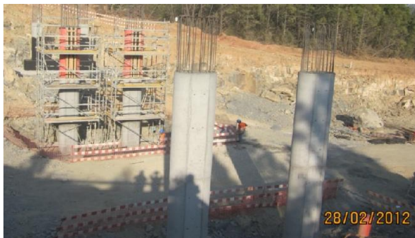
Pilares e suas fundações.
