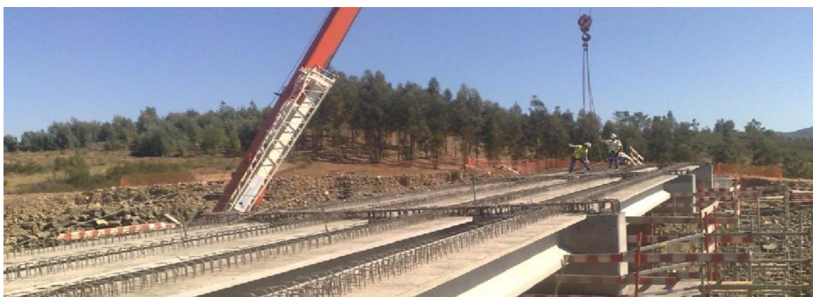
Tabuleiro: colocação de pré-lajes.
