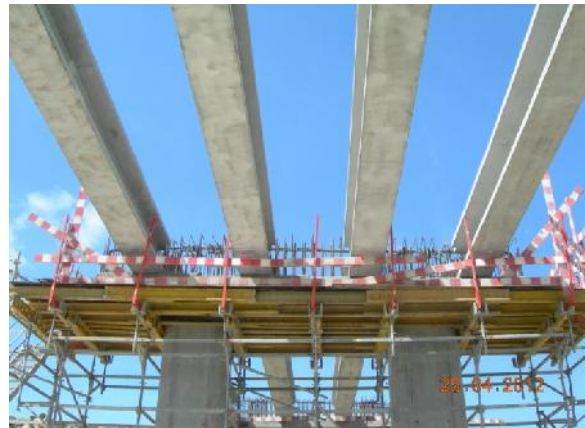
Tabuleiro: colocação de vigas pré-fabricadas.
