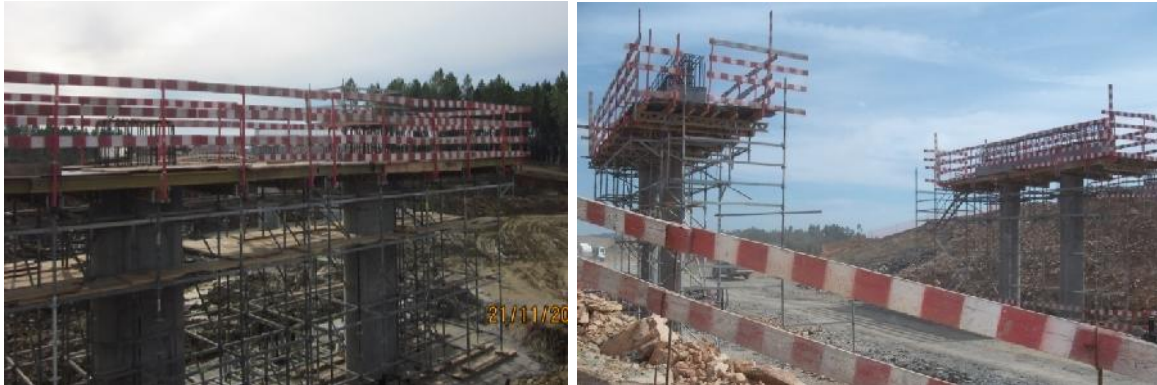
Pilares: à esquerda com armadura de espera para ligação dos pilares à viga travessa e à direita já com a viga travessa betonada.
