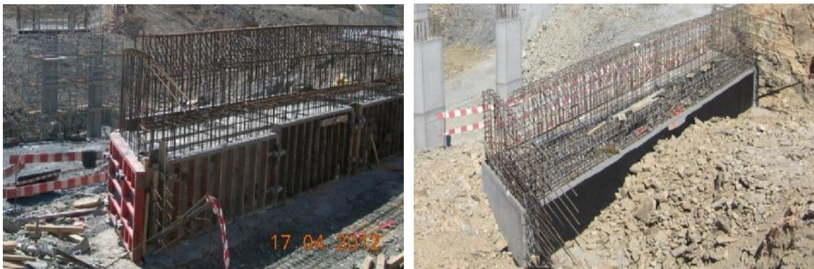
Encontros: gigante tipo “batólito”, à esquerda cofragem e à direita elemento já betonado. Armaduras dispostas para o muro testa e muros ala
