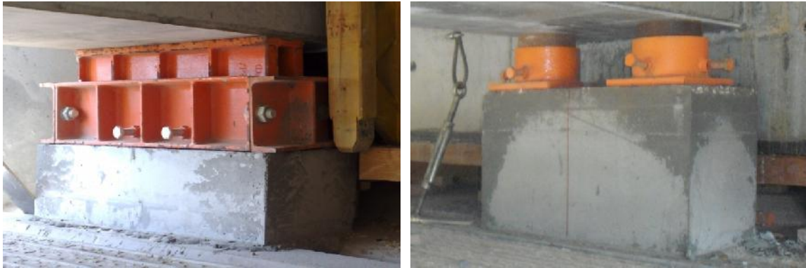
Aparelhos de apoio provisórios.
