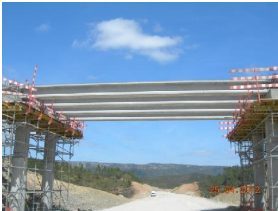
Tabuleiro: colocação de vigas pré-fabricadas.
