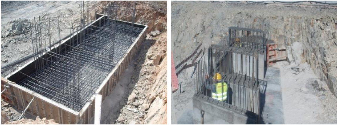
Encontros: fundações diretas e gigantes (fustes)
