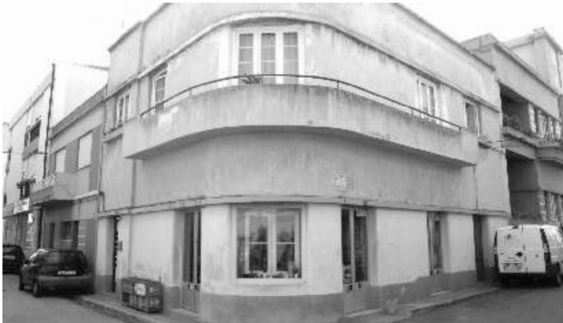
Rua 1º de Dezembro, n.º 64. Terceira sede da Associação Comercial de Peniche
