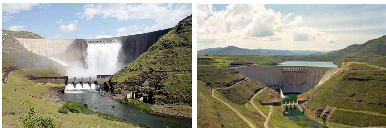
Figura 2.10: Barragem de Katse, África do Sul.
