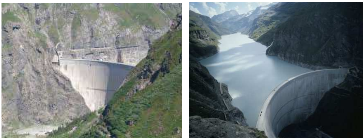
Figura 2.11: Vista da barragem de Mauvoisin, Suíça.
