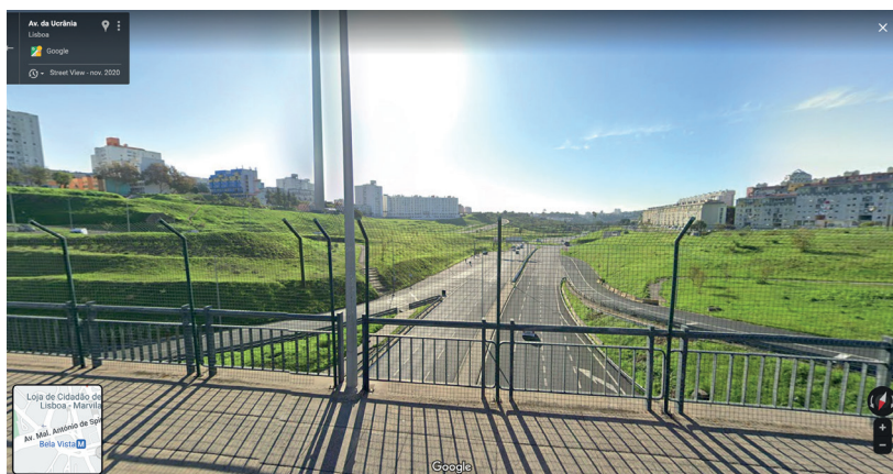
Perspectiva da Av. Santo Condestável desde a via da Av. da Ucrânia que liga as duas encostas do vale. Fonte: Google Maps (captura de imagem de 2020).
