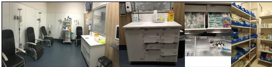
Figura M2.8: Organização do espaço. Limpeza e arrumação e identificação de materiais, solutos, medicamentos e outros consumíveis, bem como equipamentos.
