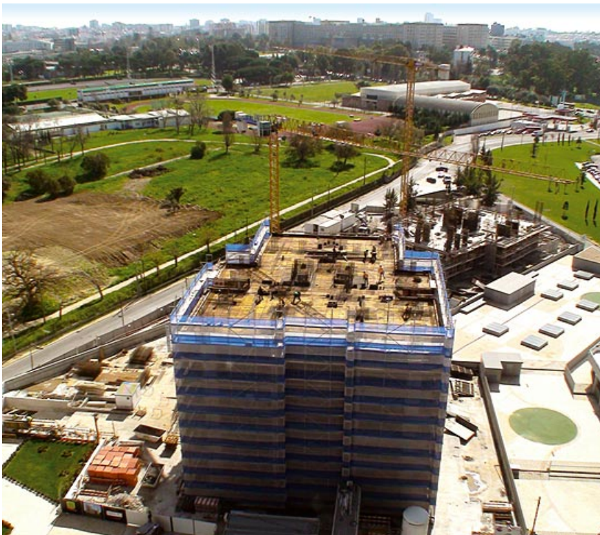
Figura 4.1.1 – Andaime da torre D acompanhando a estrutura.
