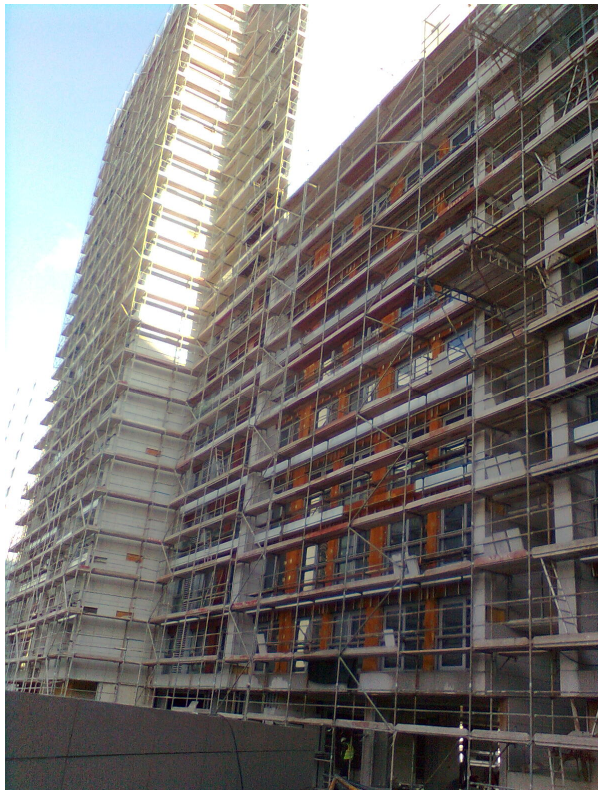
Figura 4.1.5.1 - Andaime sul finalizado
