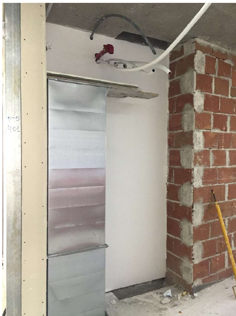
Figura 3-48 - Conduto de desenfumagem sem negativo para passar para o piso superior
