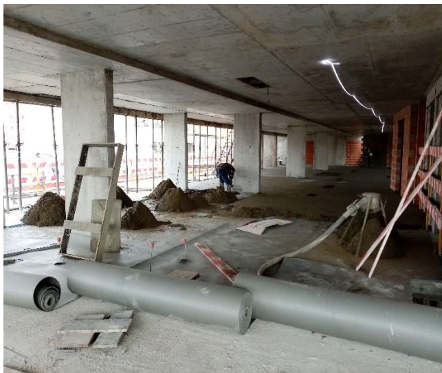
Figura 3-8 - Rolos de manta acústica por baixo da betonilha
