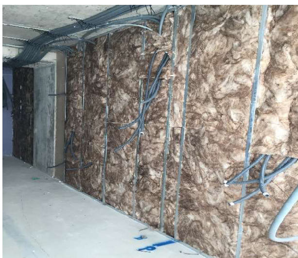
Figura 3-21 - Parede de unidade de alojamento, já com tubagem para instalações elétricas e isolamento em lâ de rocha
