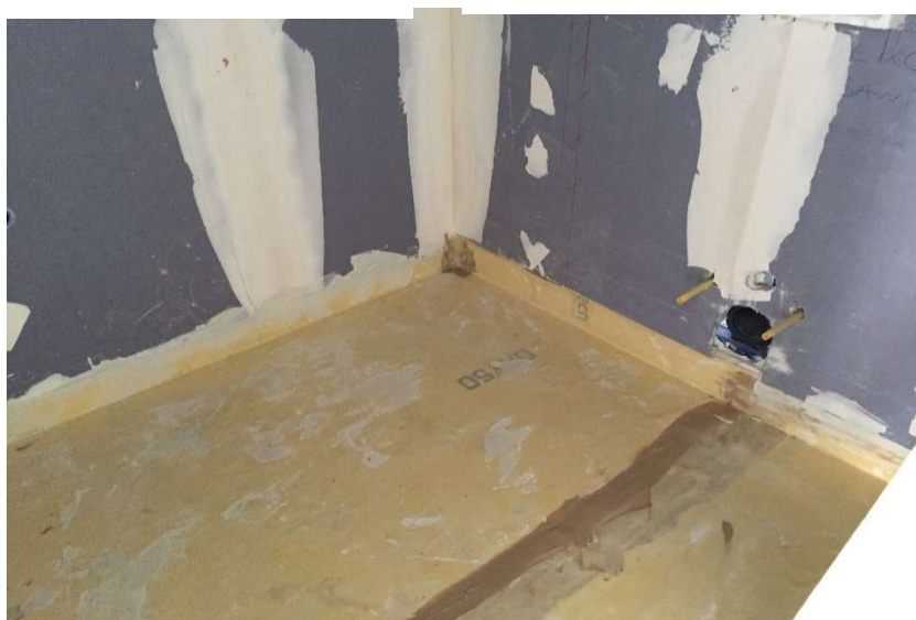
Figura 3-31 - Impermeabilização no pavimento da IS, fora da zona de duche
