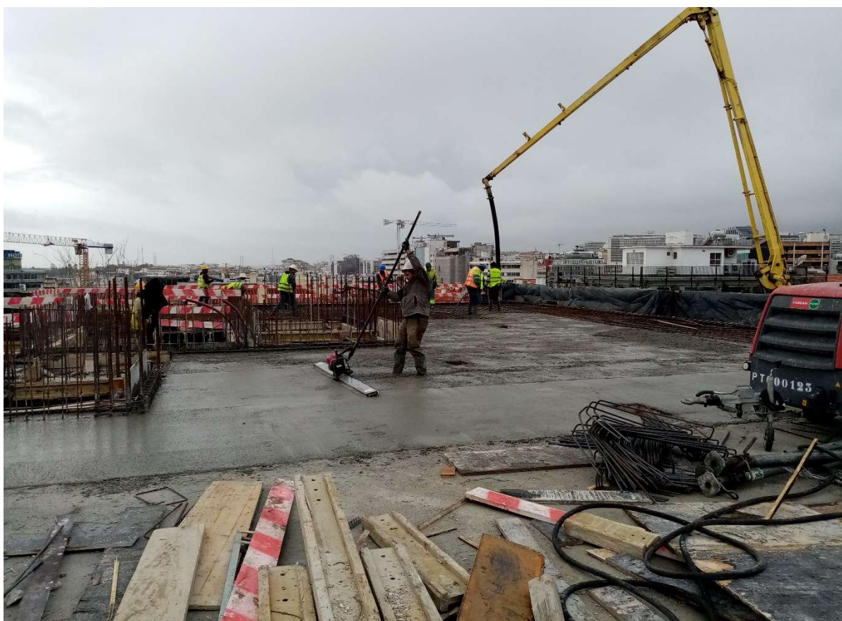
Figura 3-6 - Betonagem de laje do Piso 7 (Cobertura)
