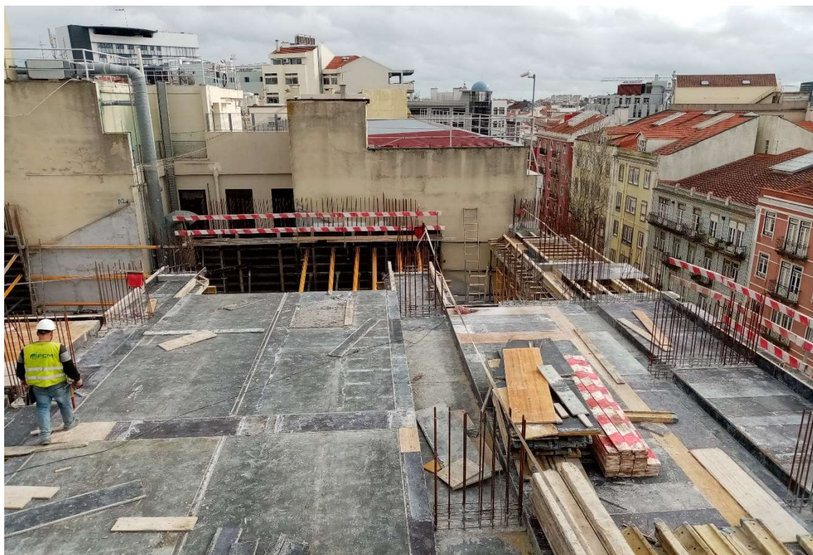
Figura 3-4 - Execução da cofragem da laje do Piso 6
