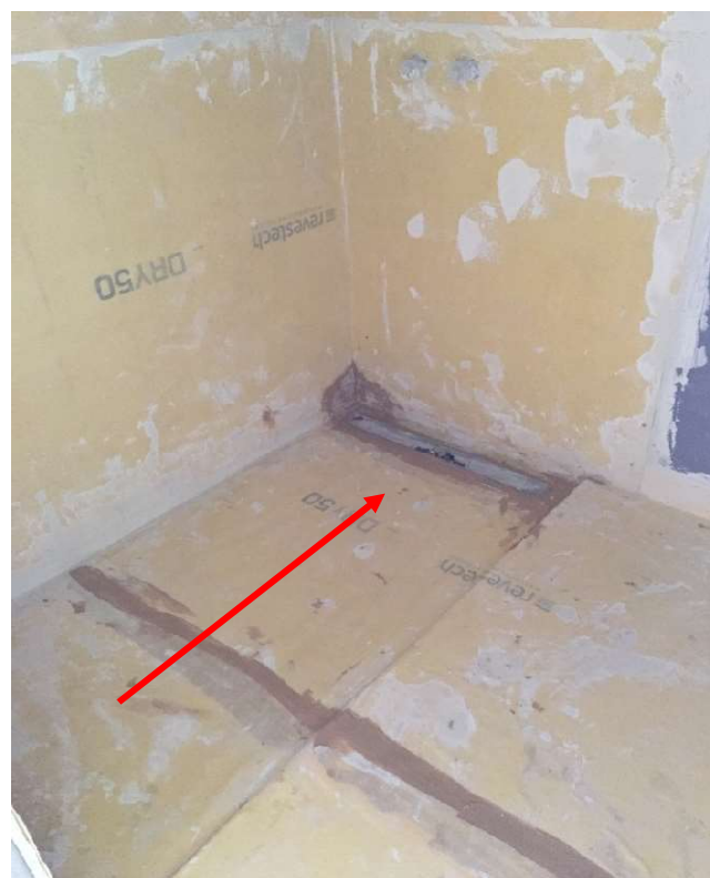
Figura 3-30 - Impermeabilização da base de duche
