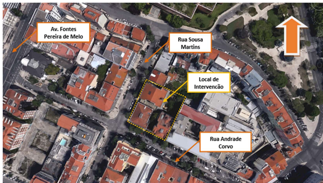
Figura 1-1 - Vista aérea da localização da empreitada (GoogleMaps)
