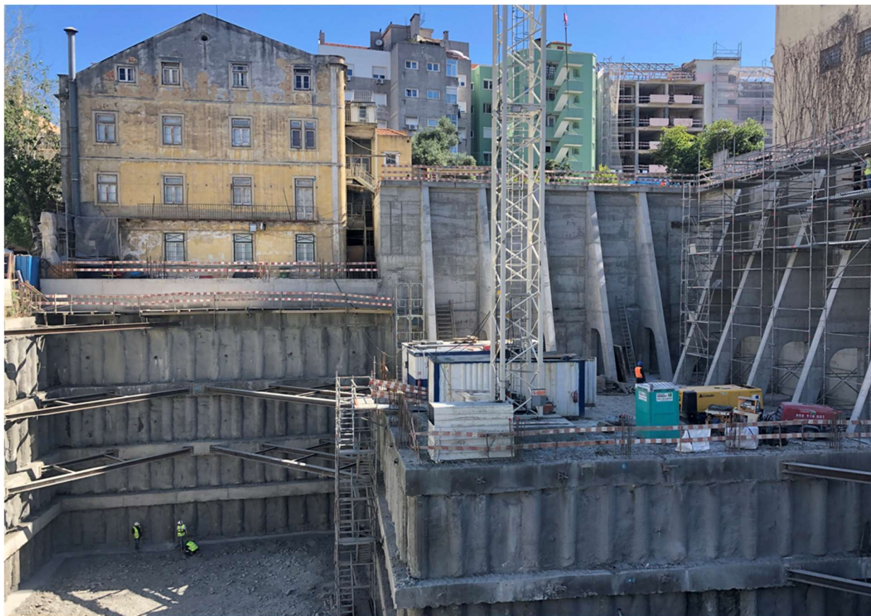
Figura 2-3 – 3ª visita à obra - Agosto 2019
