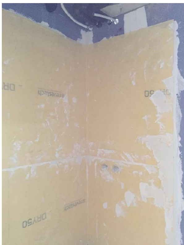
Figura 3-29- Impermeabilização das paredes na zona de duche
