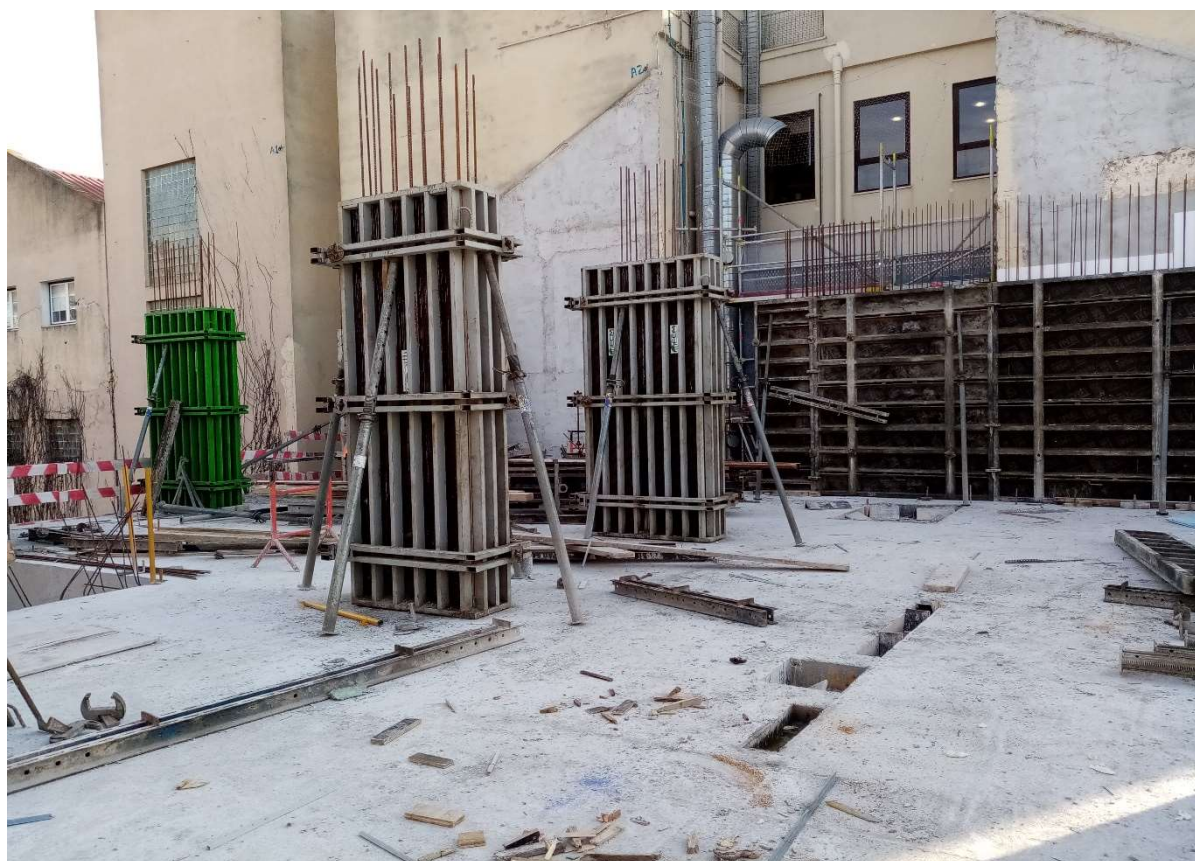
Figura 3-2 - Cofragem de elementos verticais
