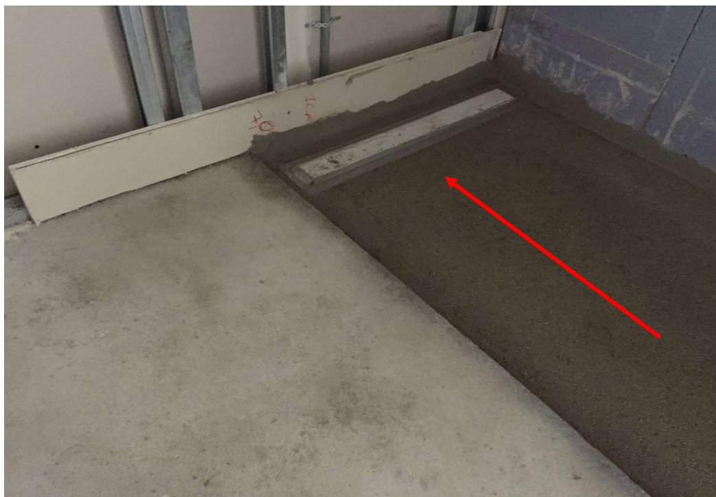
Figura 3-25 - Base de duche, pronta a impermeabilizar e revestir
