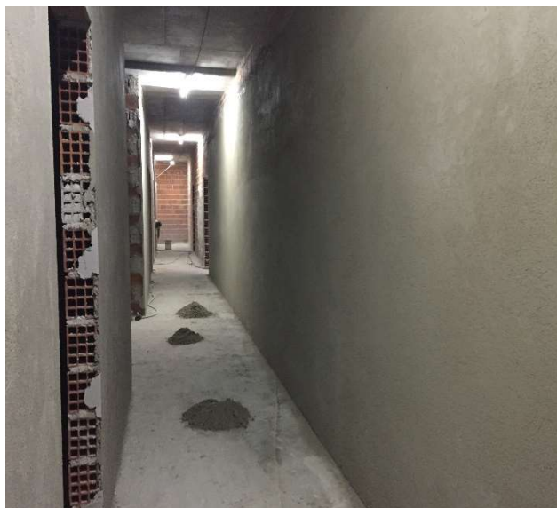
Figura 3-14 - Acabamento do reboco com Redur PK02 da Secil
