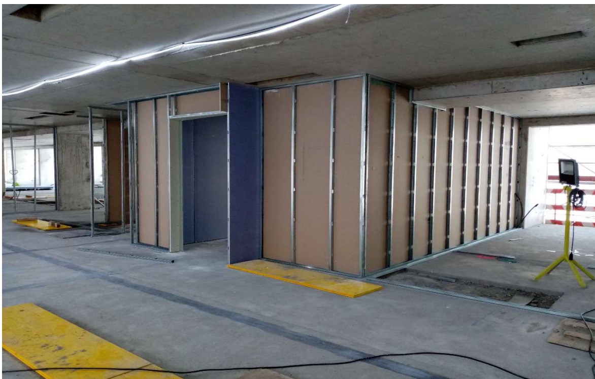
Figura 3-12 - Execução da primeira unidade de alojamento (“Quarto Modelo”)
