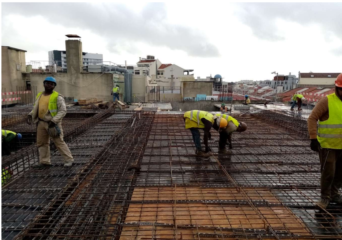
Figura 3-5 - Armação da laje do Piso 7 (Cobertura)
