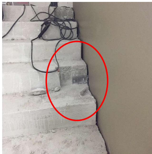
Figura 3-37 - Pormenor da fixação da guarda
