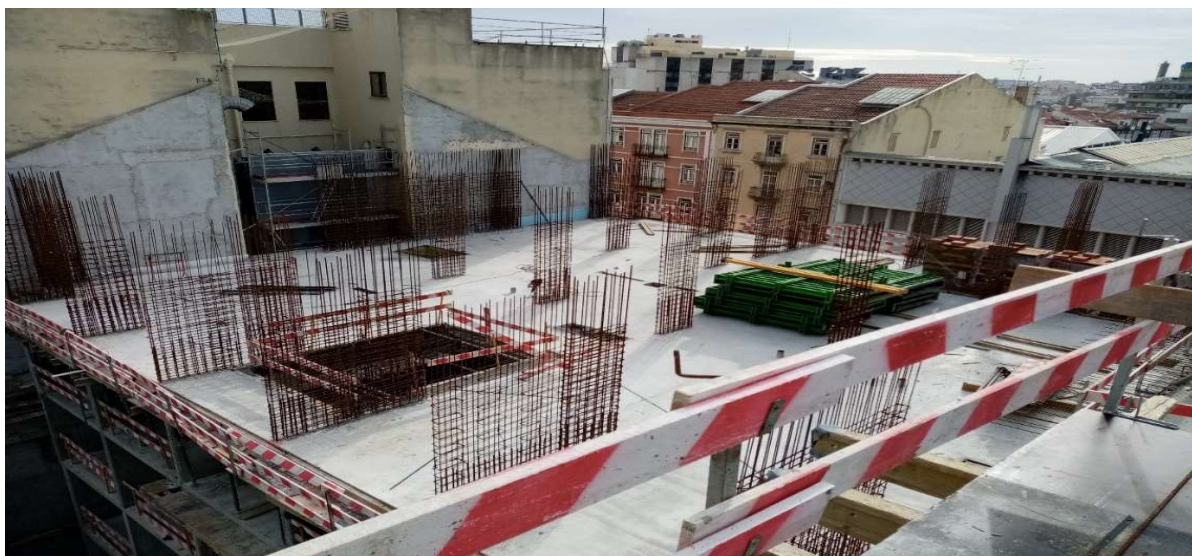
Figura 3-1 - Armadura de elementos verticais.
