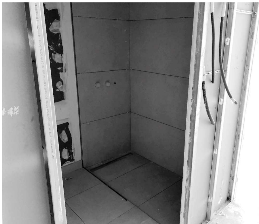
Figura 3-32 - Revestimento cerâmico na IS do Quarto Modelo
