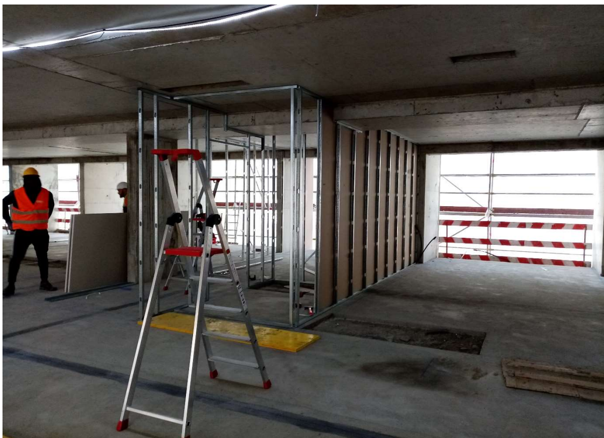
Figura 3-11 - Início da execução das paredes divisórias
