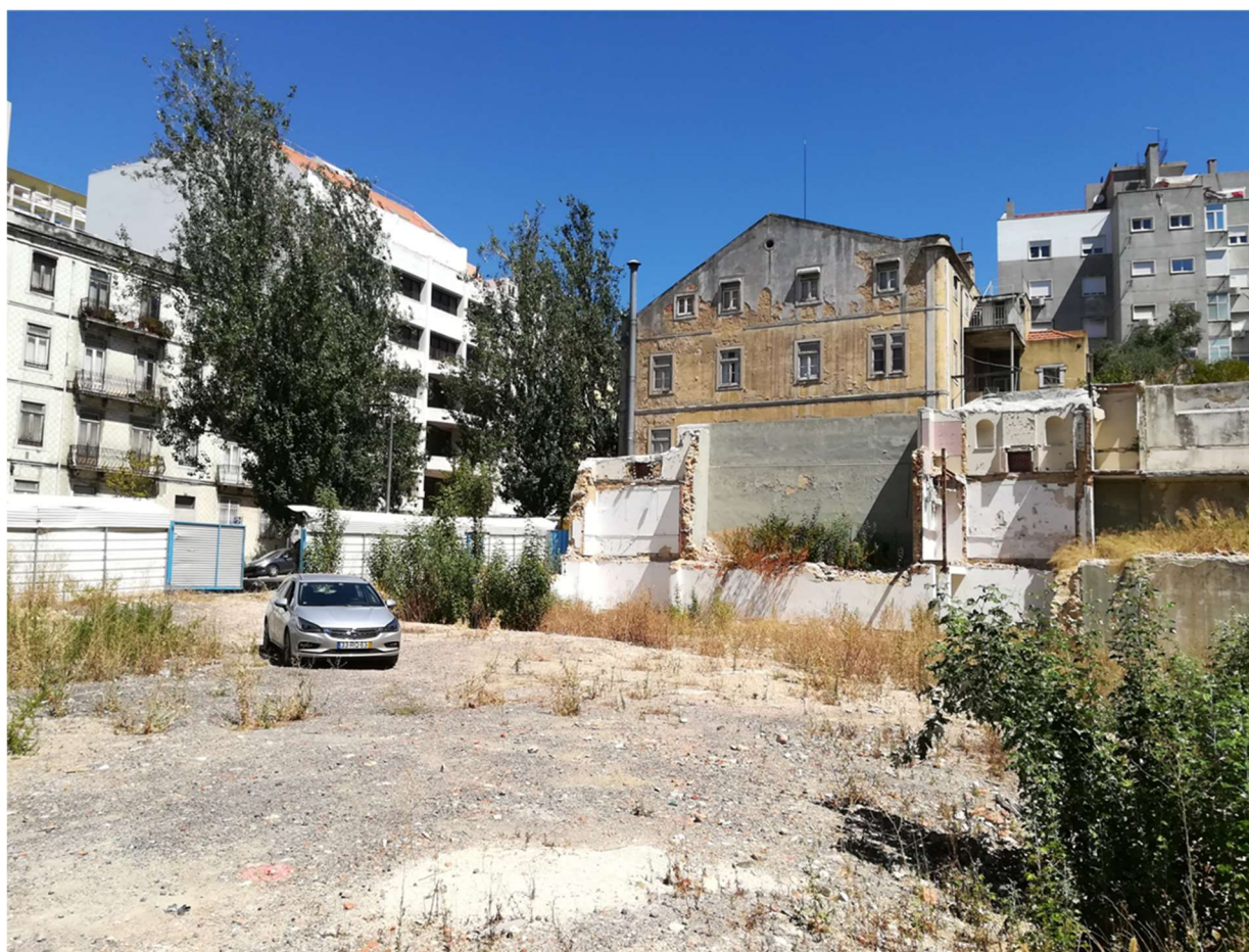
Figura 2-1 - 1ª visita à obra – Dezembro 2018
