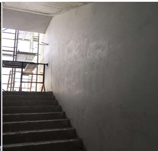
Figura 3-17 - Estuque na escada E3, entre pisos 0 e 1
