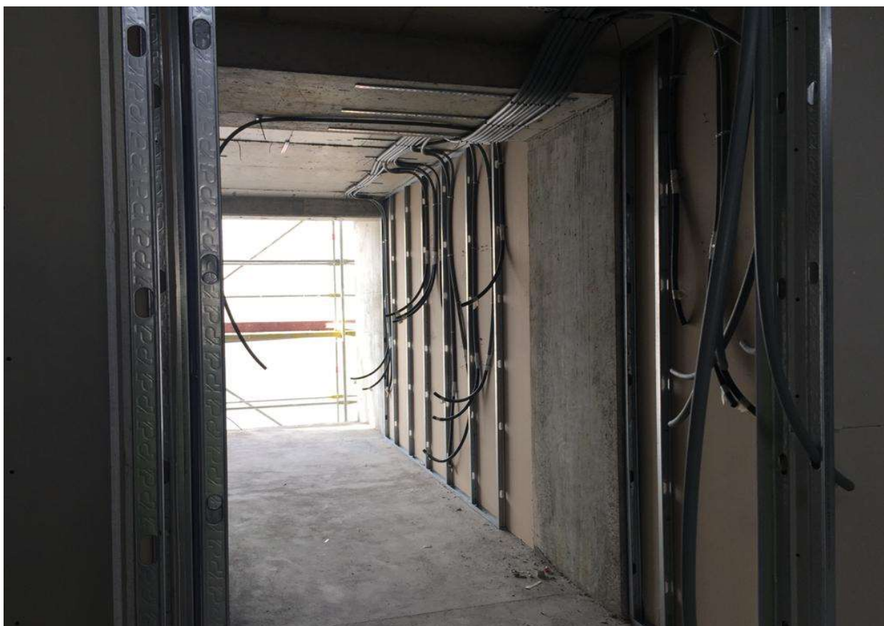
Figura 3-18 - Colocação de tubagem para cabos elétricos nas unidades de alojamento
