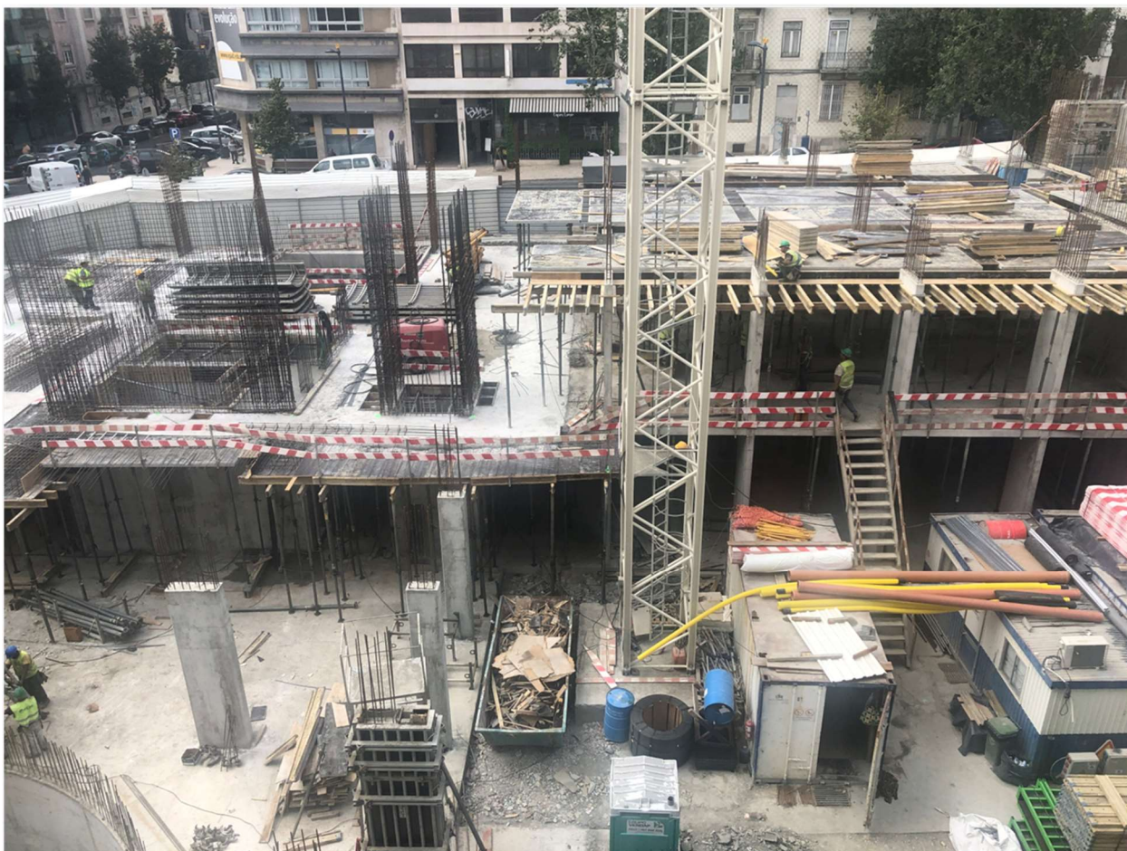
Figura 2-4 - 4ª visita à obra - Março 2020
