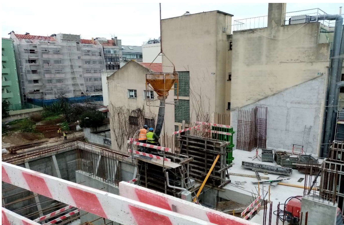
Figura 3-3 - Betonagem de elementos verticais
