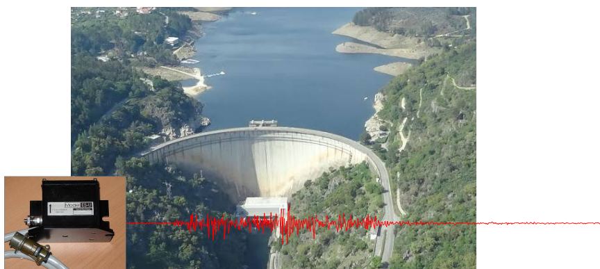
Figura 5.38 – Sistema de monitorização em contínuo instalado na barragem do Cabril.
