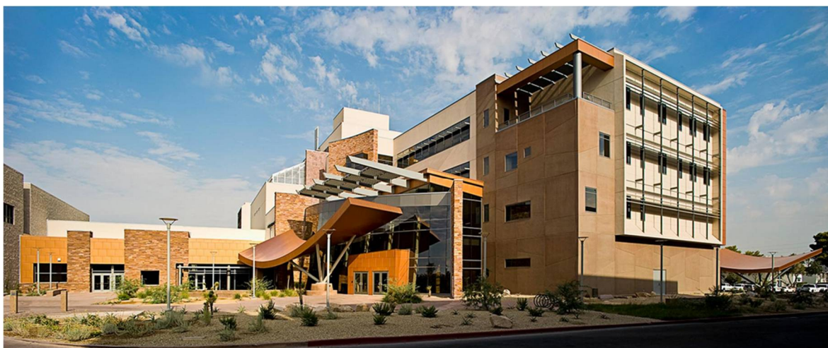
Figura 2.5 – Edifício do departamento de Ciências e Engenharia da Universidade de Nevada, Las Vegas (Kalkan et al., 2013).
