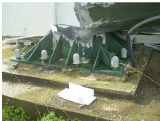
ILUSTRAÇÃO 3.11: ASPECTO GERAL DA BASE DA TORRE E LIGAÇÃO A FUNDAÇÃO.
