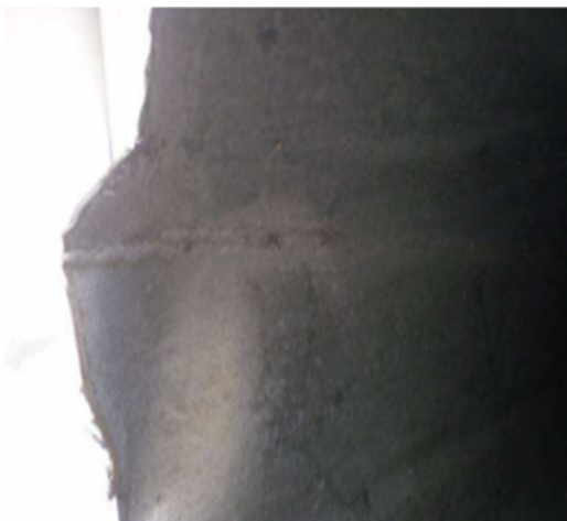
ILUSTRAÇÃO 3.8: CORDÃO DE SOLDADURA COM PENETRAÇÃO TOTAL NO INTERIOR DA TORRE.
