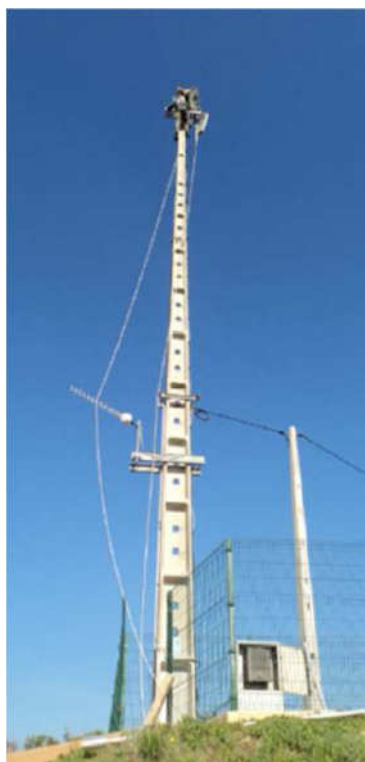
ILUSTRAÇÃO 2.13: TORRE TIPO POSTE BETÃO PRÉ-ESFORÇADO
