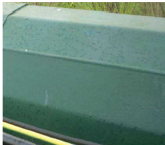
ILUSTRAÇÃO 3.9: ASPECTO DO CORDÃO DE SOLDADURA PELO EXTERIOR DO FUSTE
