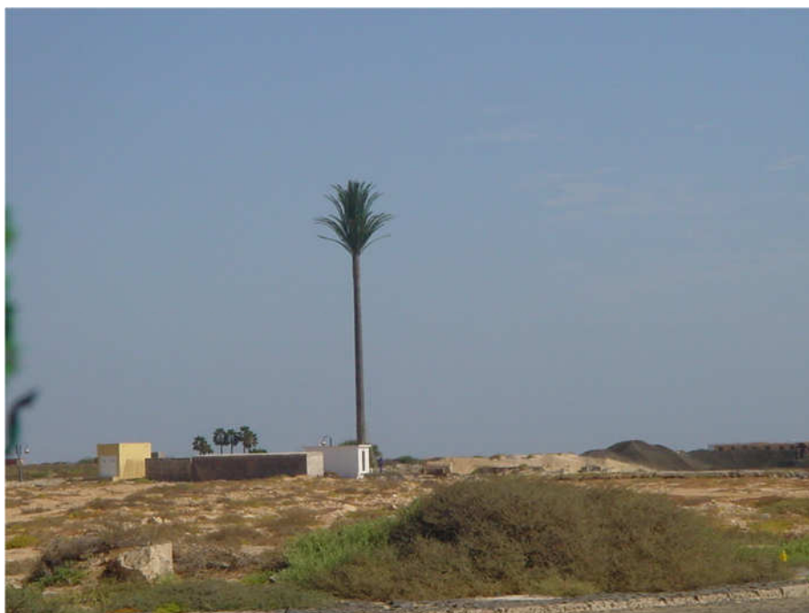
ILUSTRAÇÃO 1.2: TORRE TUBULAR CAMUFLADA “ÁRVORE TIPO PALMEIRA”, CABO VERDE.
