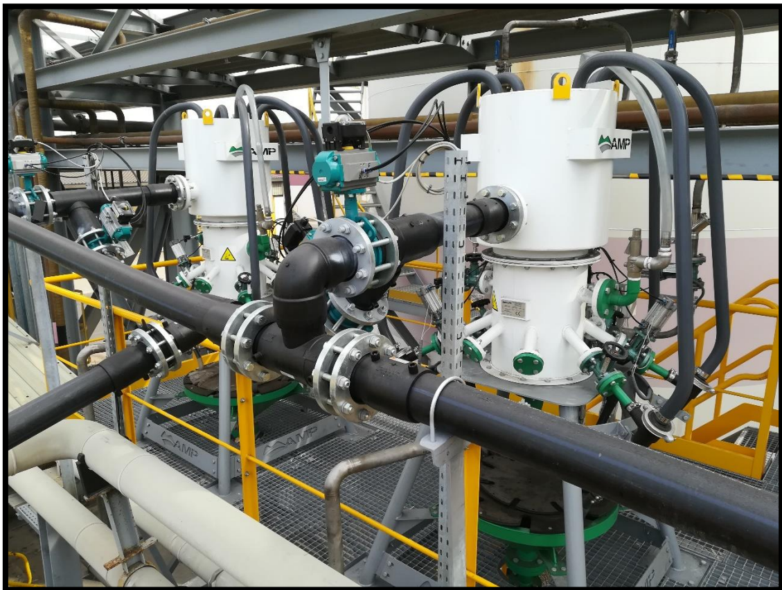
Figura 53: Instalação dos hidrociclones junto à ITEL
