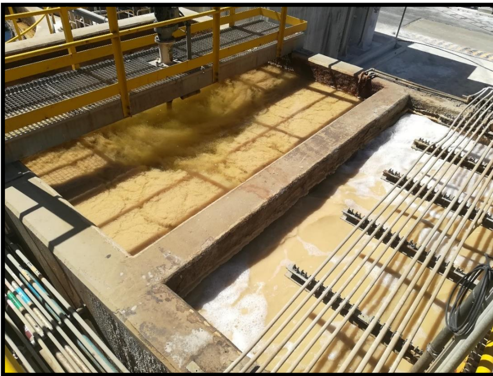
Figura 50: ITEL antes da implementação da solução da redução do teor de sólidos.
