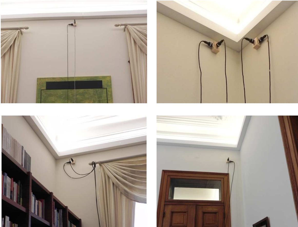
Figura 4.1 – Pormenores da fixação dos acelerómetros.
