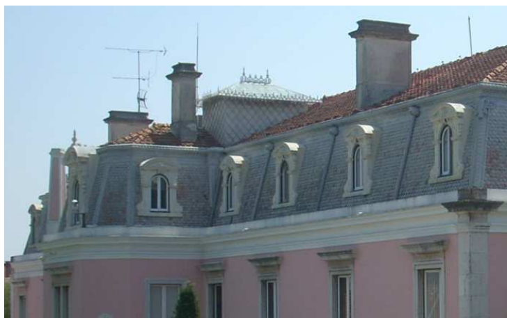
Figura 3.20 – Parte da fachada posterior do edifício.
