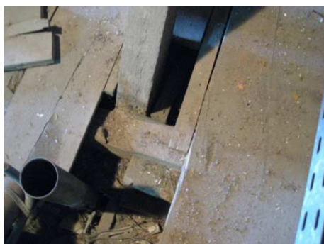
Figura 3.25 – Estrutura de madeira do teto do piso de mansarda.
