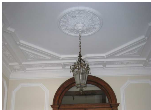
Figura 3.28 – Teto do hall de entrada do edifício.
