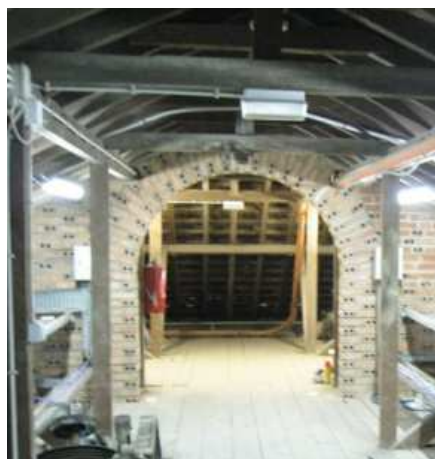
Figura 3.31 – Vista dos elementos estruturais da cobertura.
