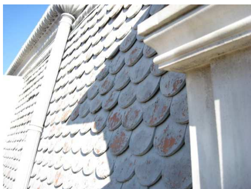
Figura 3.33 – Revestimento da mansarda em telha cerâmica plana.
