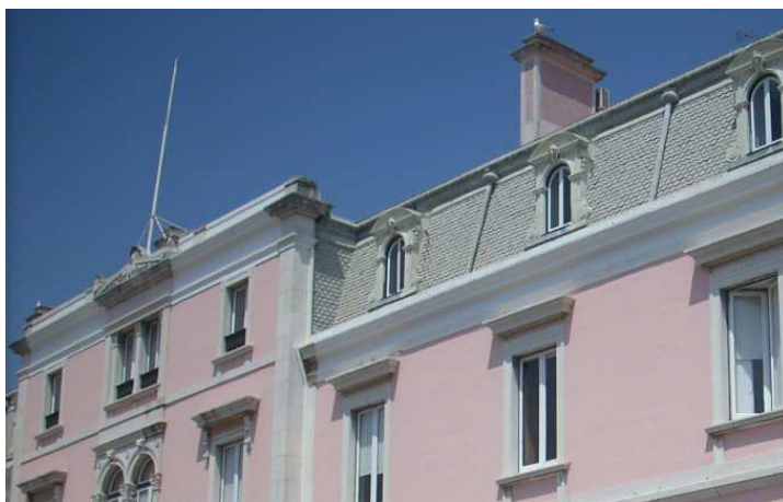
Figura 3.19 – Parte da fachada principal do edifício.
