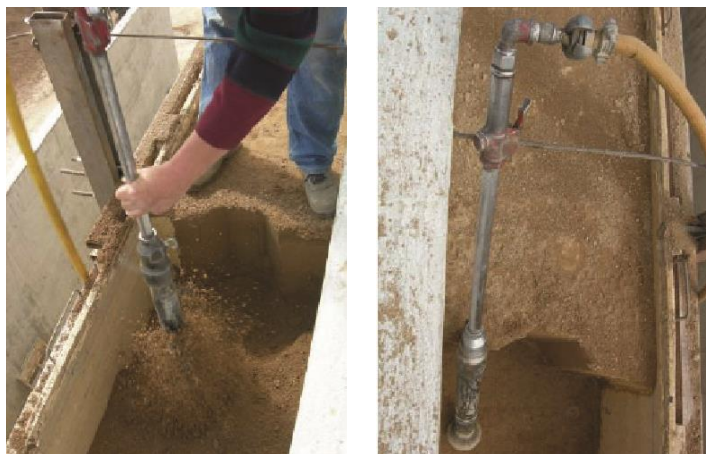
Figura 2.6 - Compactação de terra com recurso a compactador pneumático (Torgal et al., 2009)
