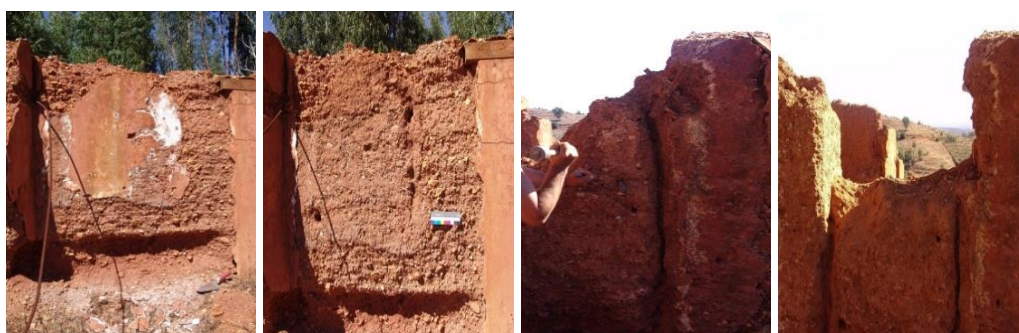
Figura 3.2 – Recolha de amostras: remoção do bloco e corte da taipa em blocos (Gomes, 2013)
