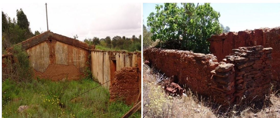
Figura 3.1 – Edifício do Monte do Pá Danado em Odemira (Gomes, 2013)
